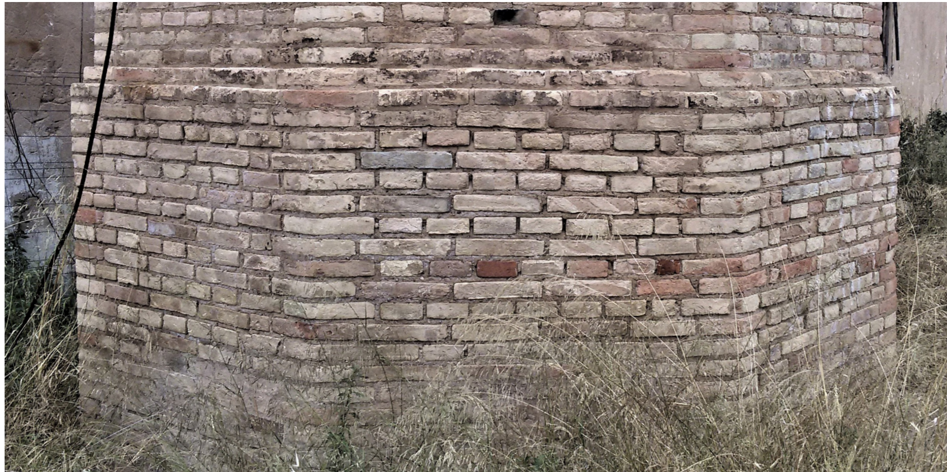
Fig. 10.94 (Arriba) Piezas empleadas en la construcción de la chimenea. Ladrillo aplastillado de esquina y ladrillo de dimensión estándar. Fuente: (Ivorra, y otros 2015)
