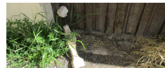
Fig. 11.5 (Derecha bajo) Balaustre de balcón que se ha desprendido y caído al suelo.
