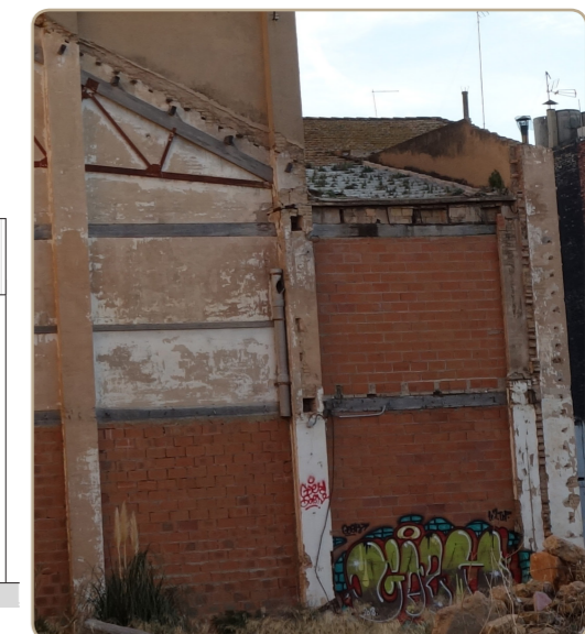
Fig. 10.24 Vista de parte del cerramiento de ladrillo hueco colocado a panderete.
