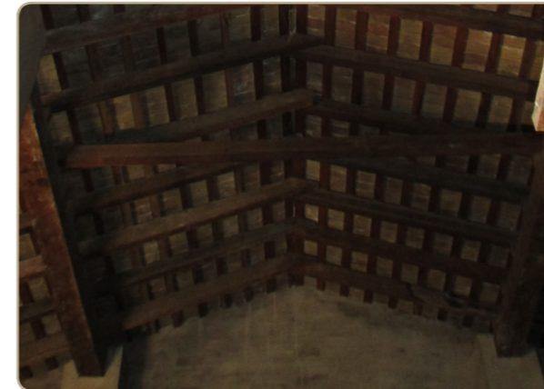
Fig. 10.42 Vista de cubierta a dos aguas con pares de madera.
