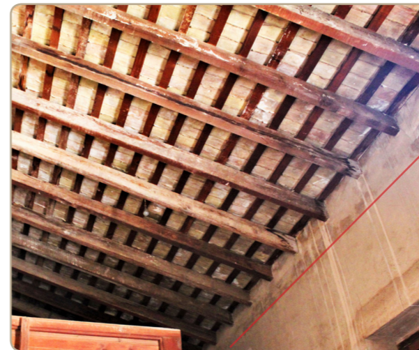
Fig. 10.17 Extradós del muro de mampostería en su encuentro con cubierta, se aprecia la formación de la cornisa mediante ladrillo.
