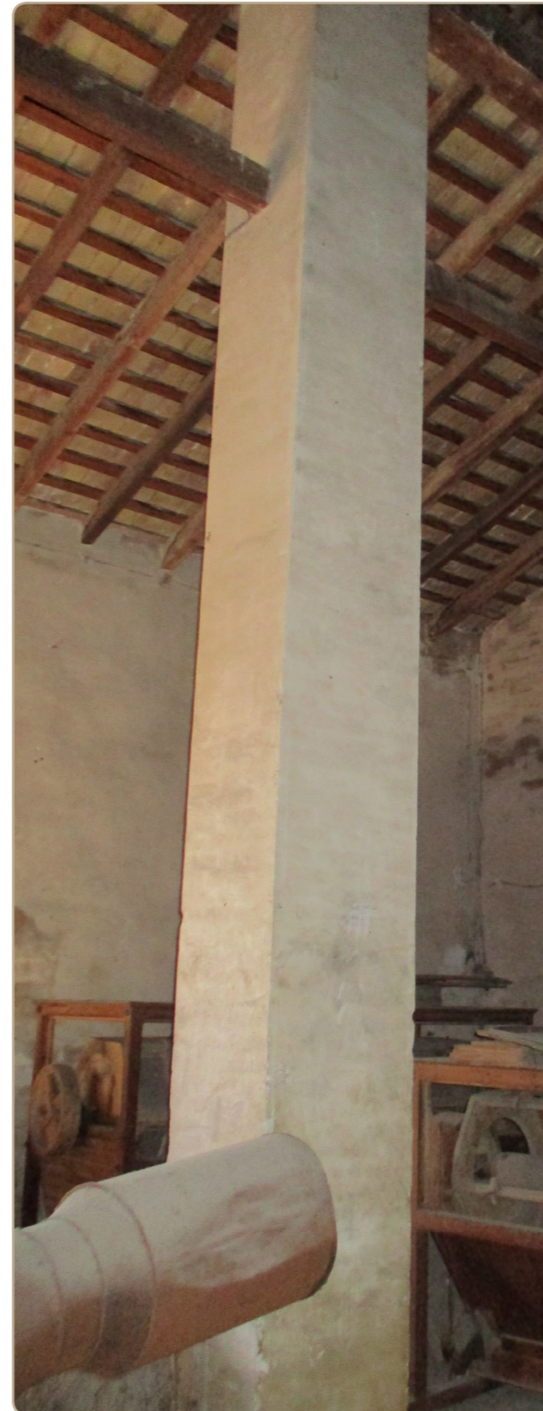
Fig. 10.20 Pilar de fábrica de ladrillo macizo situado en la primera planta.
