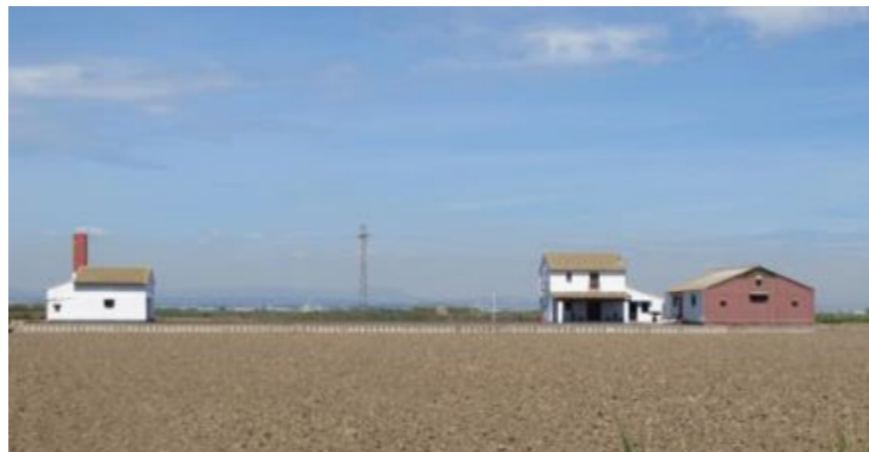
Fig. 3.11 (izquierda) Vista casa y almacén-trilladora.(Vendrell 2016)
