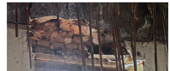
Fig. 10.11 Dintel de hueco en el que se aprecia que las piezas colocadas encima y debajo de la viga de madera, tienen una altura casi igual que la propia viga. Son piezas especiales de piedra tallada con altura mayor a la del ladrillo.
