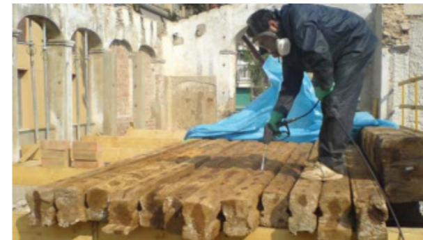
Fig. 11.32 Pulverización de vigas. Fuente: http://www.rehabimed.net/Publicacions/Metode_Rehabimed/II.%20Rehabilitacio_Ledifici/ES/2a%20Parte.%20Herramienta%209.pdf (pág. 9)
