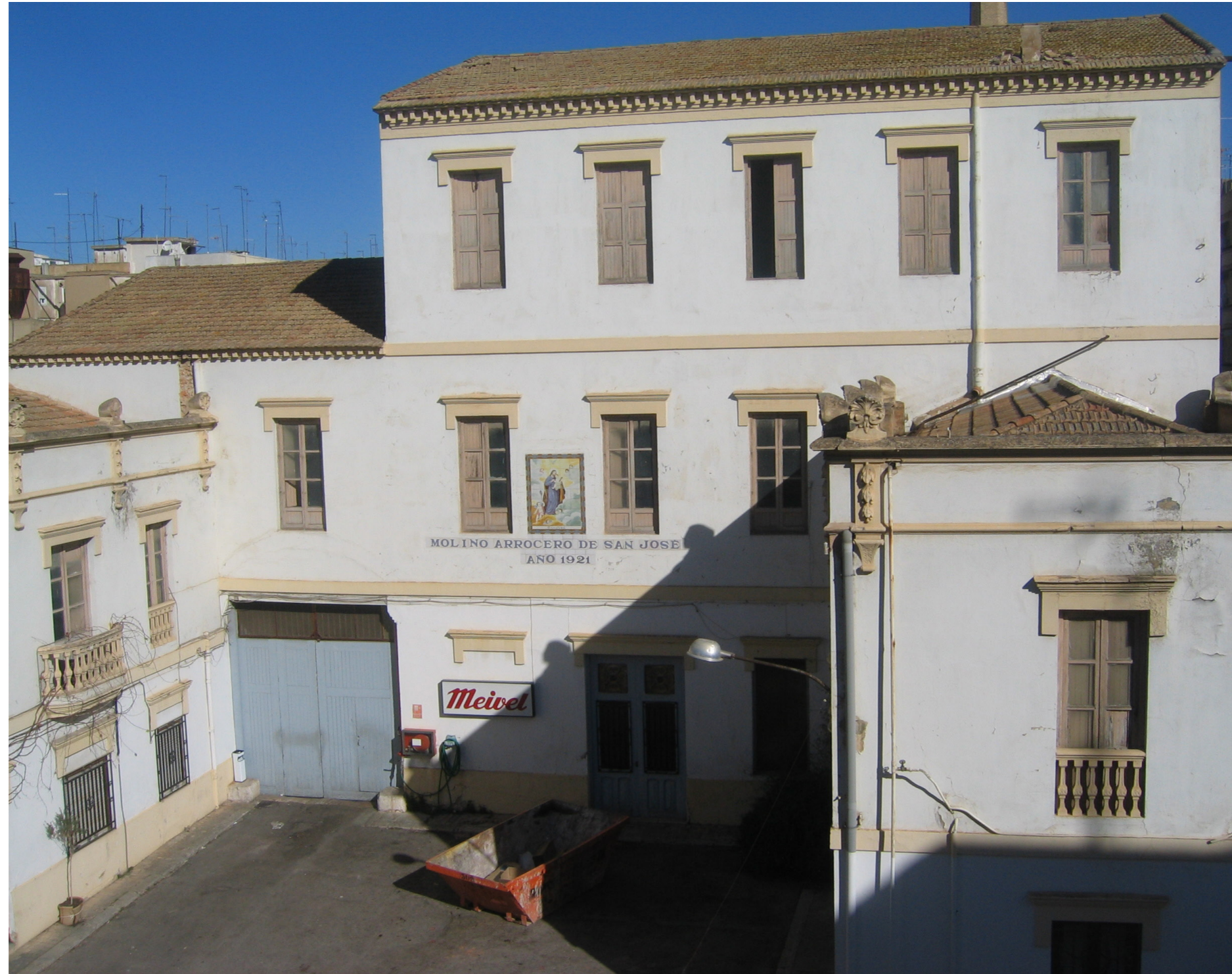
Fig. 10.1 Vista general de la fachada del inmueble desde cubierta del edificio enfrentado. Año 2007. Fuente: Documentación gráfica de Jorge Castellano Belloch.
