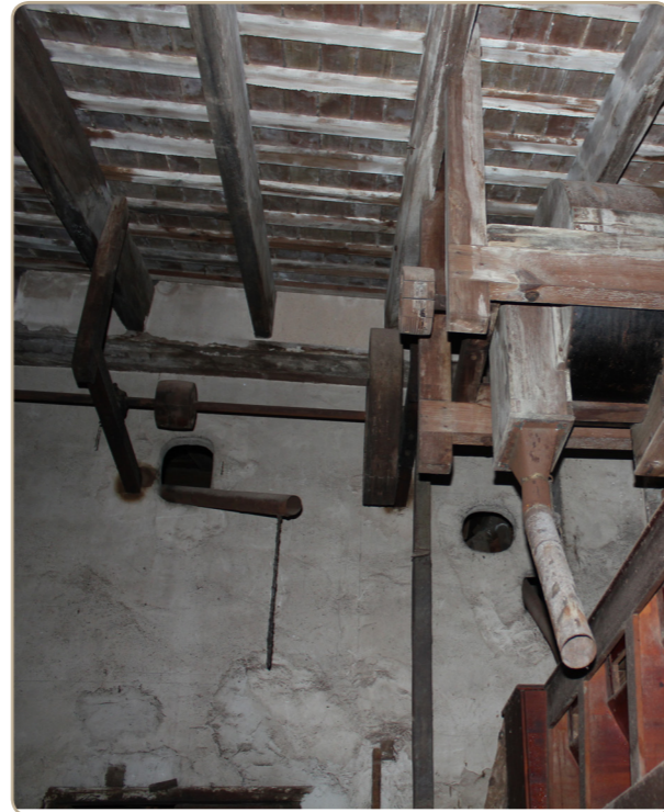
Fig. 10.46 Vista de cubierta a un agua con pares de madera.
