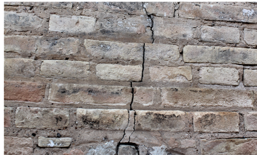
Fig. 10.102 (Derecha abajo) Vista de grieta producida en la parte superior del acceso. Rotura tanto por junta como por ladrillo.
