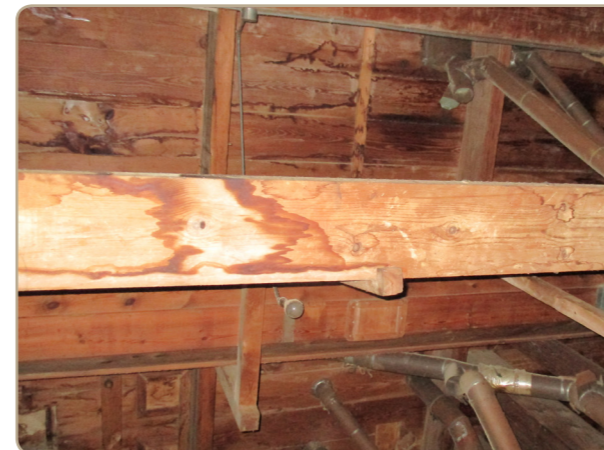
Fig. 10.35 (izquierda) Vista del forjado desde su cara inferior.
