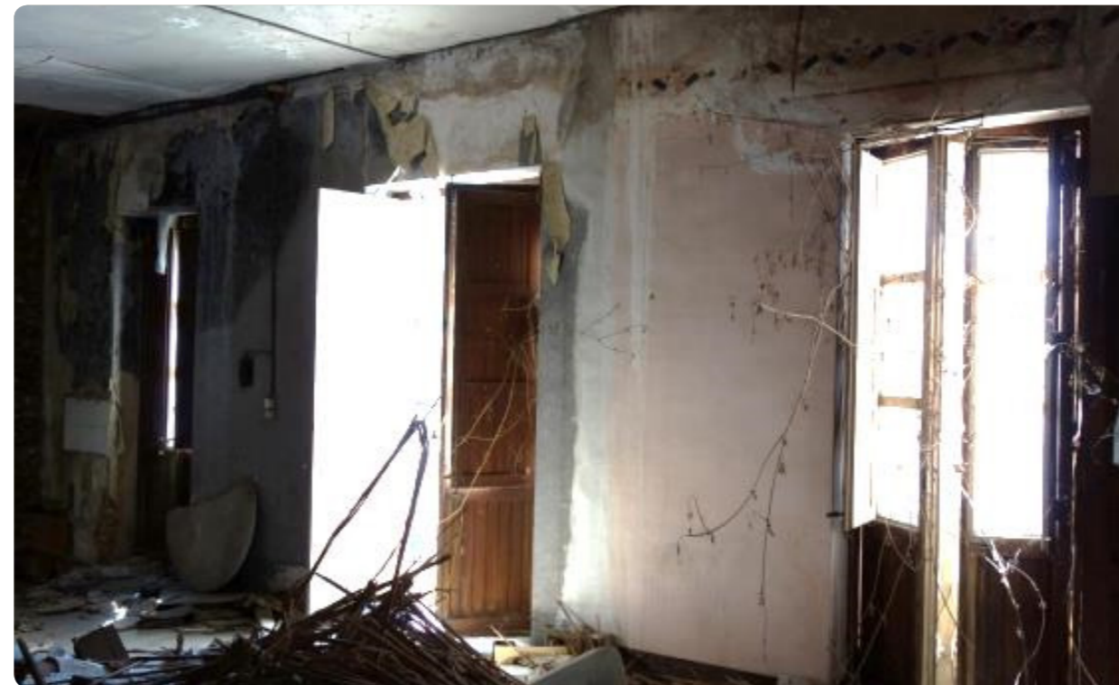
Fig. 10.56 (Izquierda) PB cuerpo lateral izquierdo. Se aprecia pintura tonos azules, empapelado posterior y recubrimiento con cartón-yeso. Se aprecia también el falso techo de cañizo para ocultar forjado de vigueta y revoltón y un segundo falso techo más actual con perfilera metálica y placas de yeso.
