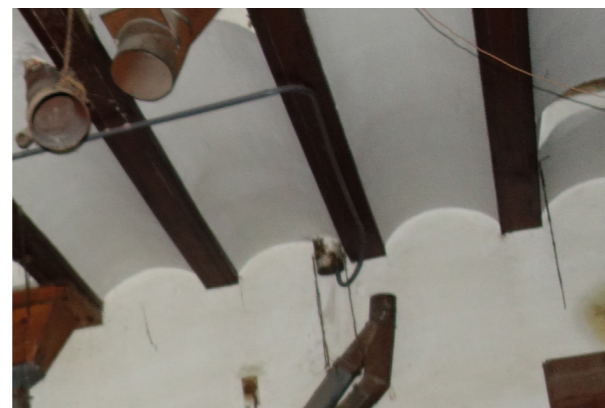
Fig. 10.13 (centro) Vista del encuentro de viguetas de forjado con el muro de fachada principal.
