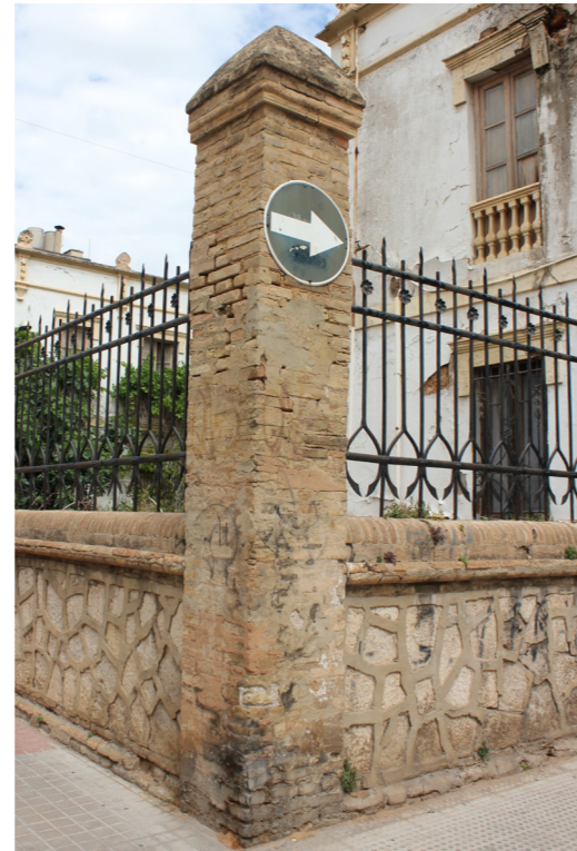
Fig. 11.26 (Izquierda) Señal anclada a pilar de delimitación de patio del molino.
