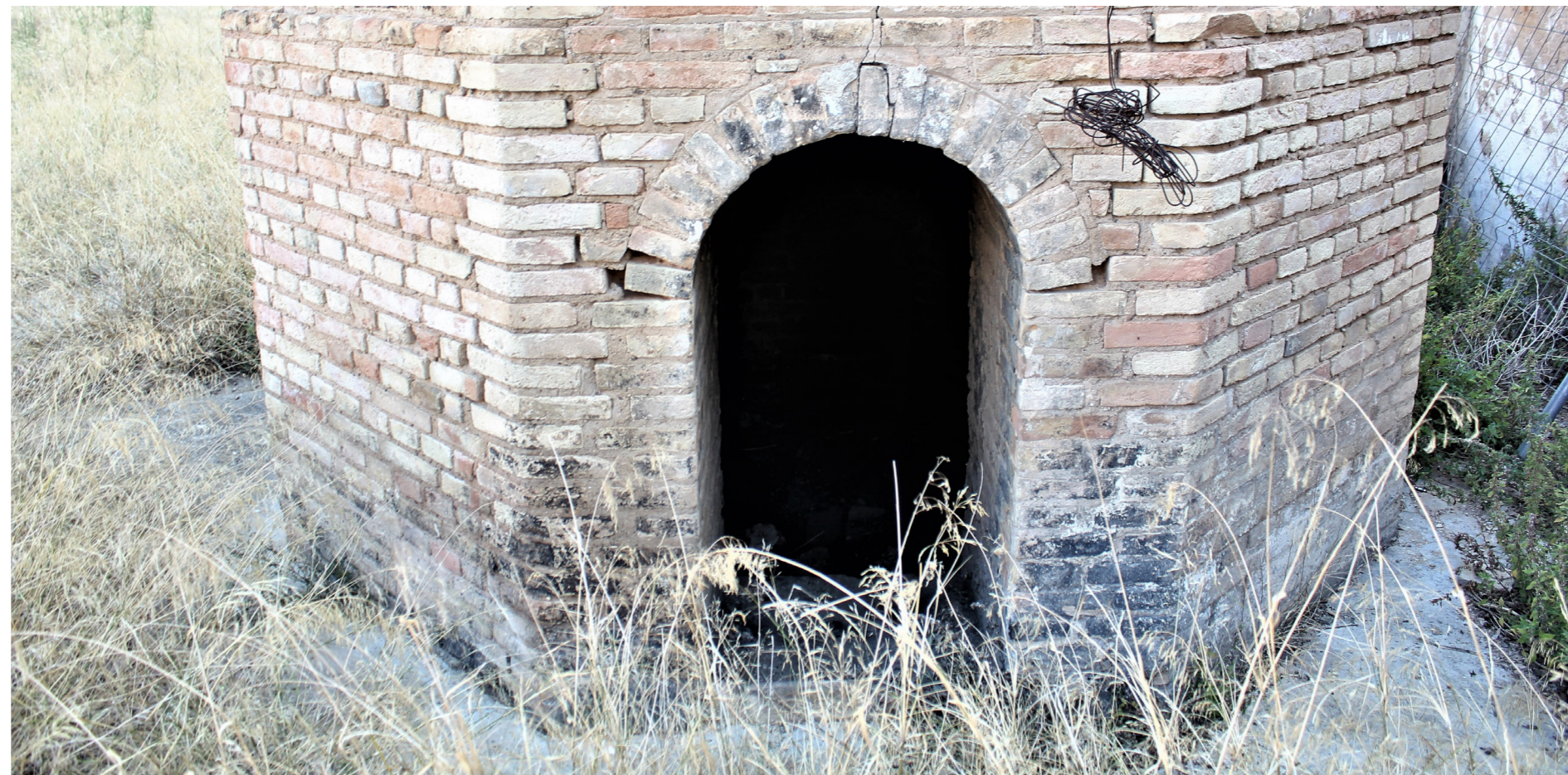
Fig. 10.92 (Arriba) Vista del cenicero de la chimenea, con ceniza, ladrillos y otros materiales.
