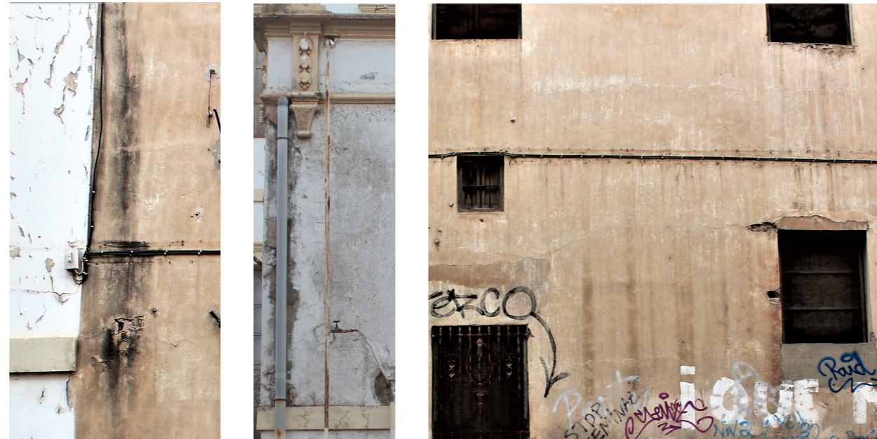
Fig. 11.9 Lavado diferencial de muro orientado a levante.
