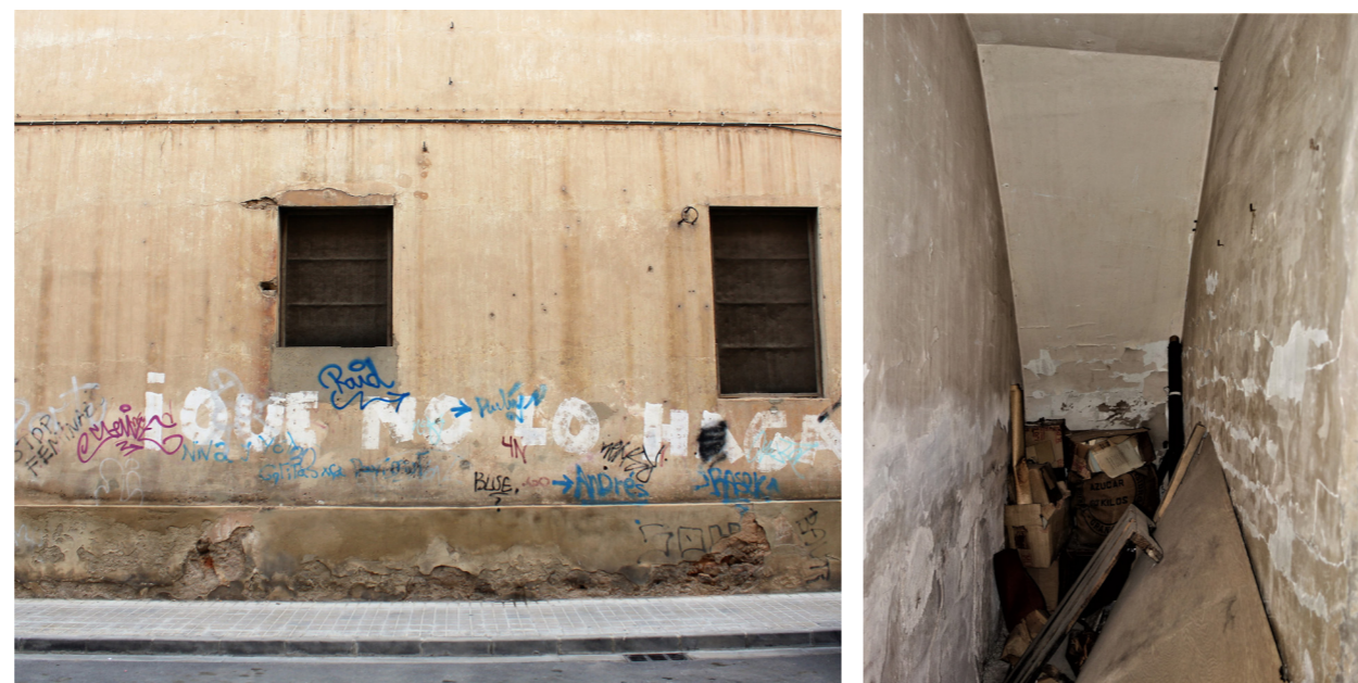
Fig. 11.10 Oscurecimiento de paramento y lesiones secundarias debidas a la humedad capilar.
