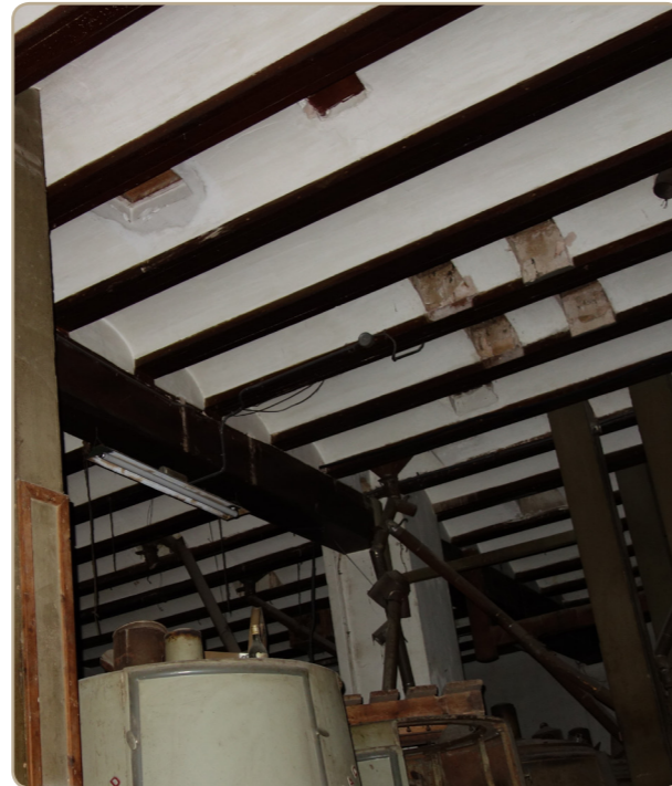
Fig. 10.68 Acabado de parte inferior de forjado en edificio destinado a molino.
