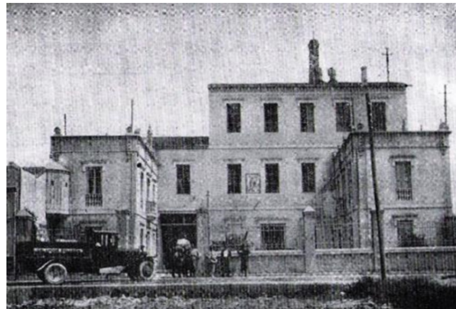
Fig. 3.28 (izquierda) Fachada Molino Arrocero San José en 1926. (Navarro Soler [1927] 2000, 195).
