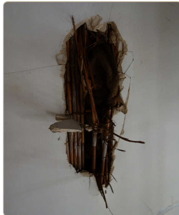
Fig. 10.69 y 10.70 Vistas de falso techo de cañizo y yeso.
