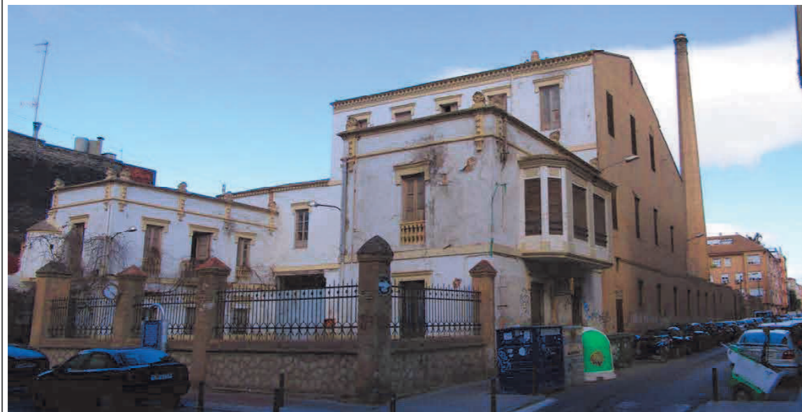
Vista de la totalidad de los elementos protegidos: Molino, alas anexas y chimenea
