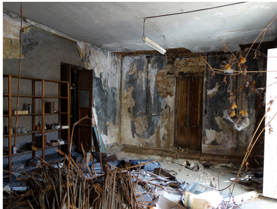
Fig. 7.5 (Izquierda) Pavimento de la 1º planta de la nave lateral en el que se aprecia que en su momento debió existir una partición aunque en la actualidad sea un espacio diáfano.
