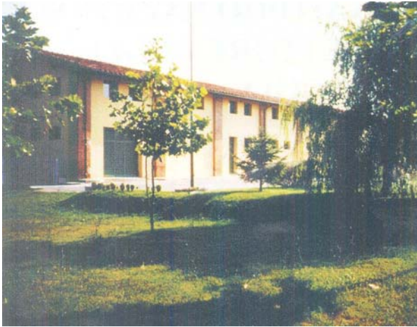
Figura 1: Il capannone completamente ristrutturato sede del Laboratorio Nazionale dell'Irrigazione
