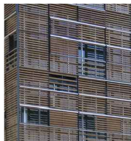
Fachada de protección solar. referente: Torre Cube, de Carme Pinos
