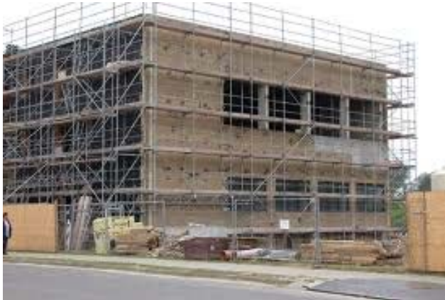
Construcción de fachada ventilada con aislante
