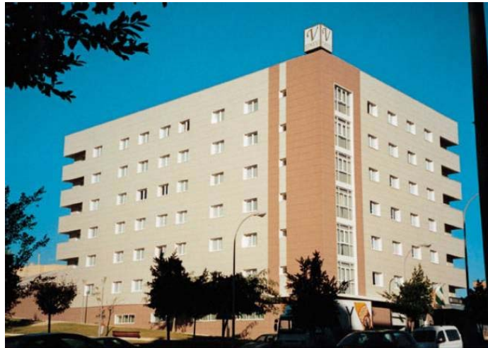
Edificio con Fachada ventilada sin remates de esquina ejecutados
