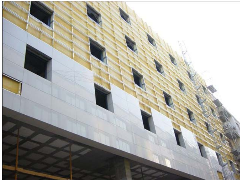
Ejecución de revestimiento cerámico
