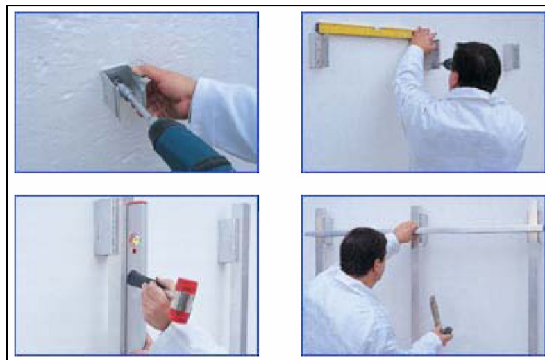
Replanteo y Nivelación de puntos de anclaje
