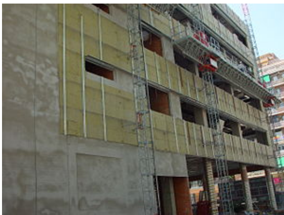
Fotos de la construcción de cerramientos con fachada ventilada
