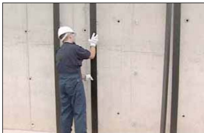
Colocación de la estructura
