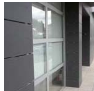
-Fachada ventilada con placas de fibrocemento marca FAVENORTE con composición de cemento y celulosa.
