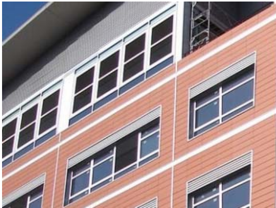
Edificio antigua metalúrgica (Barcelona) Sistema de placa CERAM 250
