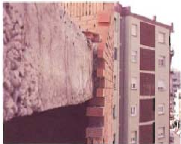
Disposición habitual de recortes de ladrillos en forjado
