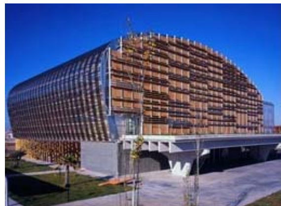
Fotos de la construcción de cerramientos con fachada ventilada
