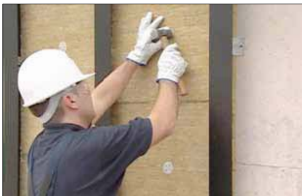
Colocación Lana de vidrio
