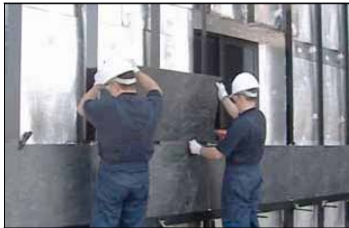
Fijación de baldosas a la estructura (BUTECH Porcelanosa)
