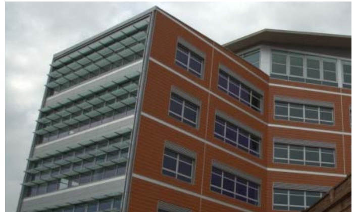
Edificio antigua metalúrgica (Barcelona) Sistema de placa CERAM 250
