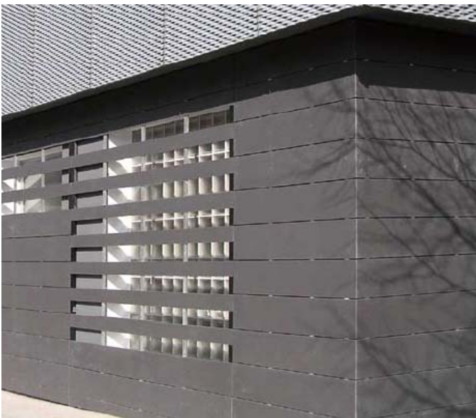
-Fachada ventilada con placas de fibrocemento marca FAVENORTE con composición de cemento y celulosa.
