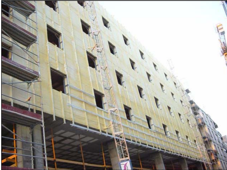
Entramado metálico con aislante ya colocado
