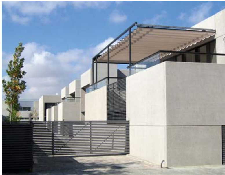
Foto de adosado con cerramiento de hormigón prefabricado
