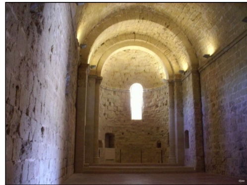
Ejemplos de muro y bóveda de cañón de piedra románico
