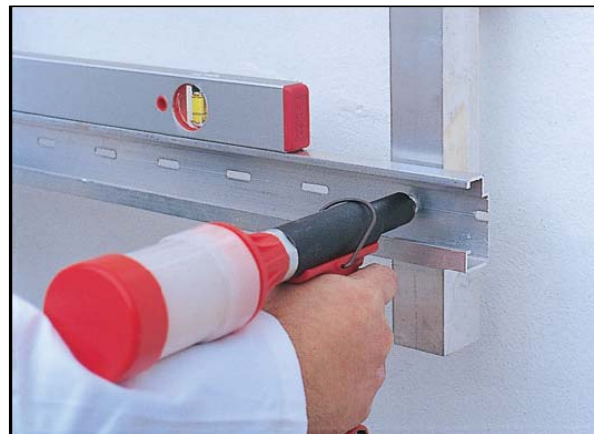
Taladro en perfilera
