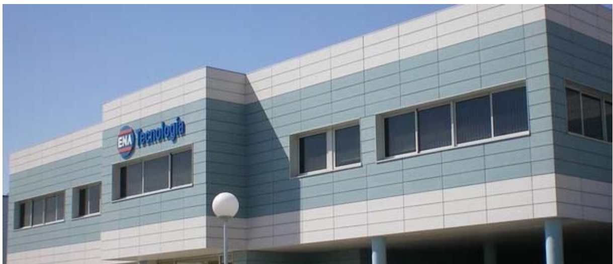
Edificio de oficinas en (Getafe) Sistema de placa CERAM 300
