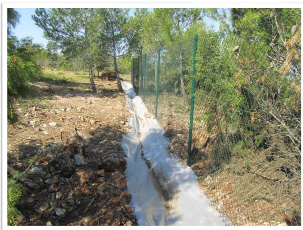
*Figura 22- Franja de desviación de escorrentía ubicada en la parte superior de la parcela*
