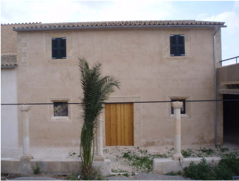
Ventanas de la planta primera
