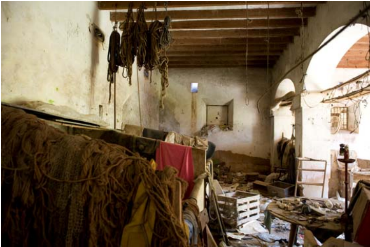
7- Apertura hueco puerta
