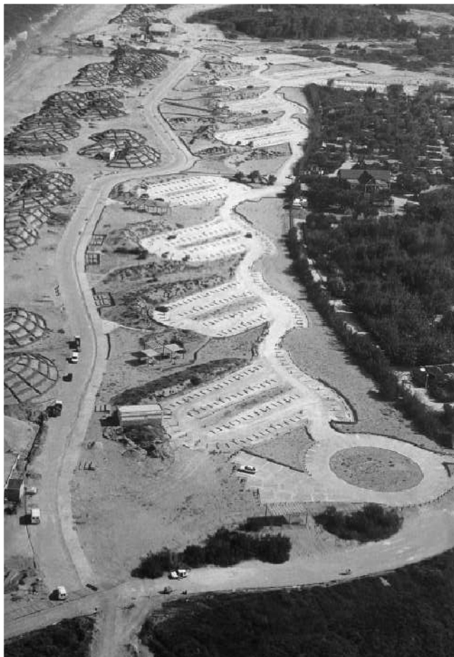
Regeneración dunar en el sector norte de la Devesa
