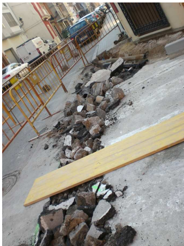
Apertura de zanja
