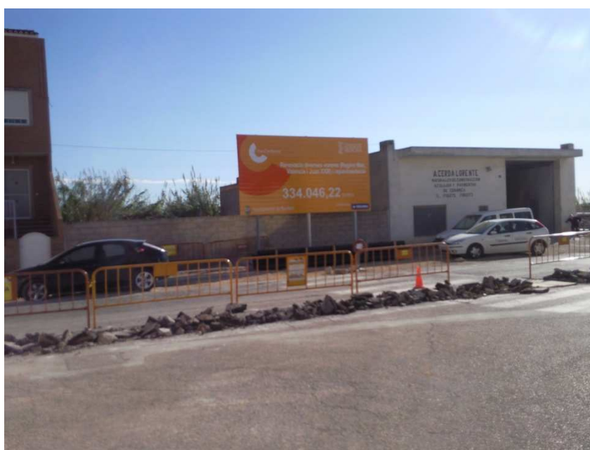
Apertura de zanja para la renovación del saneamiento.
