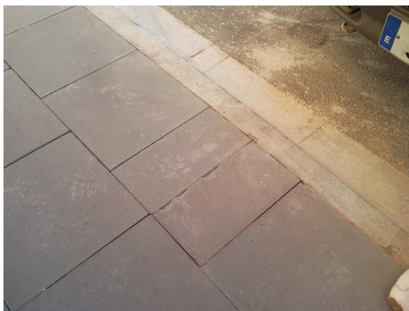
Antes de la recepción de las obras se retirarán las piezas en mal estado, y se colocarán nuevas
