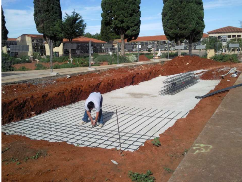
Armado de la parrilla inferior
