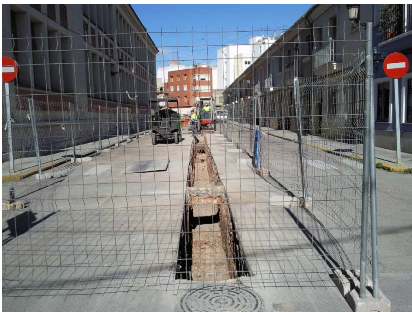
Apertura de la zanja
