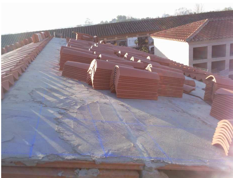
Replanteo de las tejas de la cubierta inclinada
