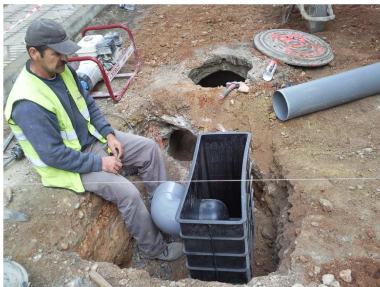
Colocación de imbornales sifónicos
