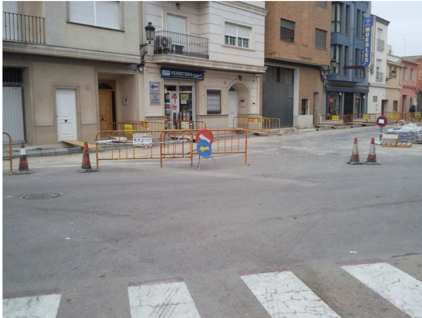
Señalización de obra
