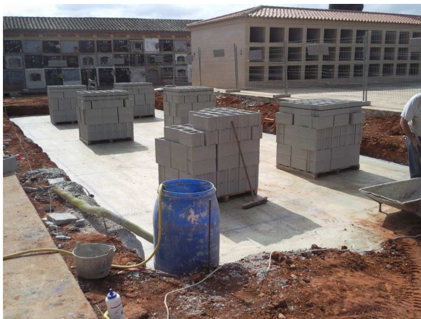
Recepción de los bloques de hormigón
