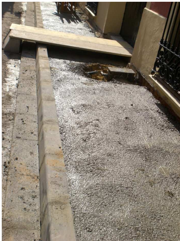
Ejecución de la solera de hormigón.
