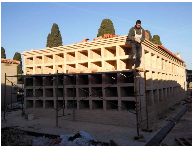
Ejecución de la cubierta
