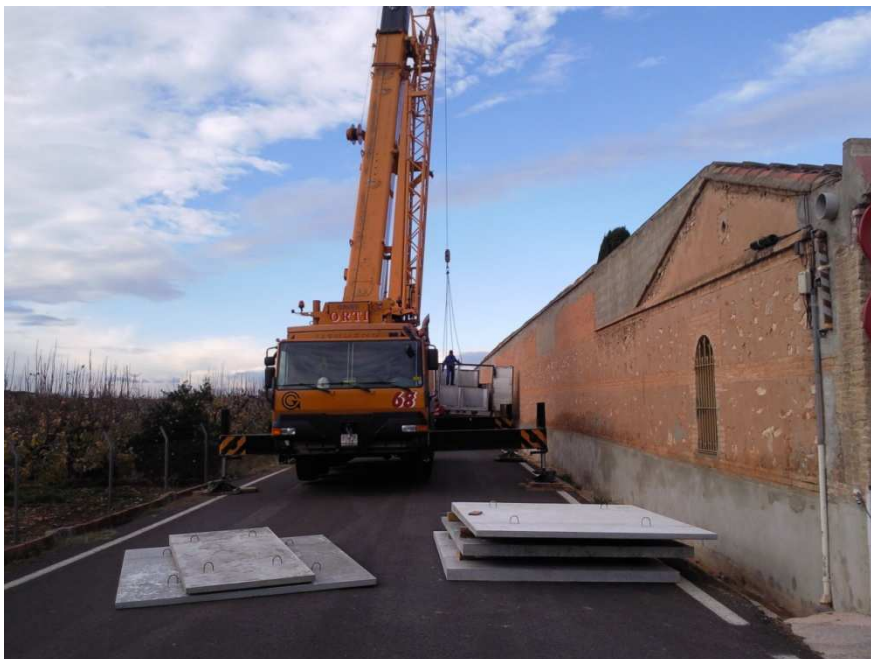
Grúa montaje de los nichos prefabricados
