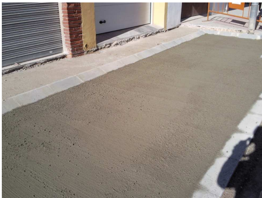
Colocación de las baldosas de la acera sobre solera de hormigón
