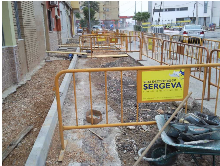
Tramo de la Calle con la zanja ya cubierta, bordillos colocados y capa de arena en las aceras.
