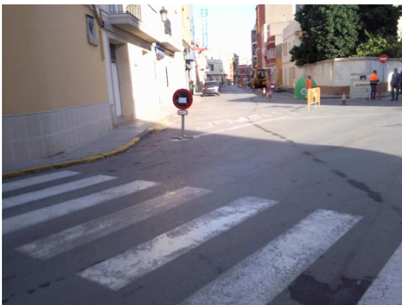
Vista general del estado actual del vial
