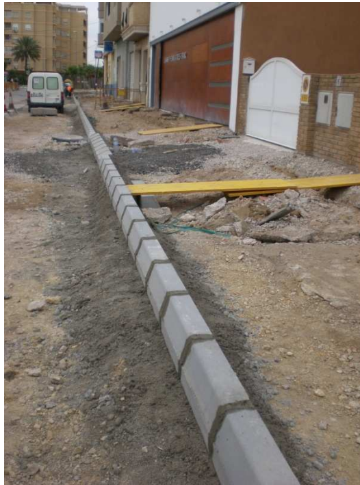
Tramo de calle con bordillos colocados.
