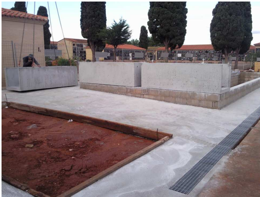
Colocación de nichos prefabricados
