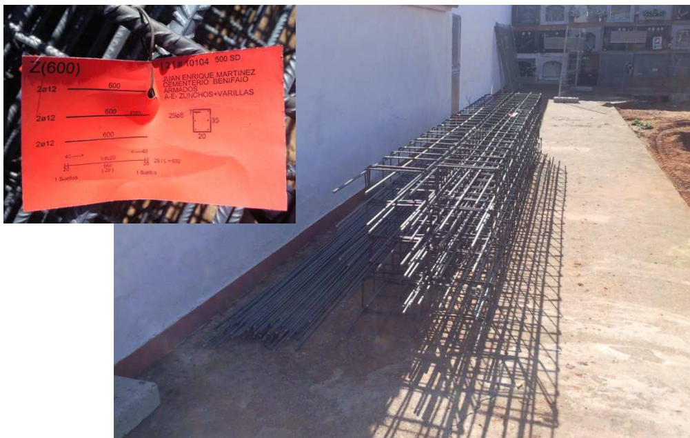
Recepción de la ferralla armada, y armadura normalizada
