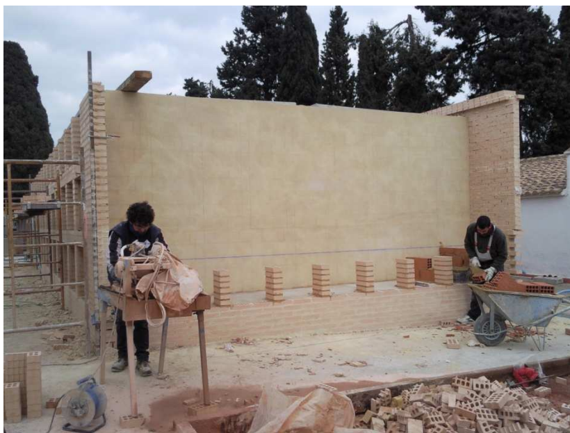
Ejecución de los columbarios
