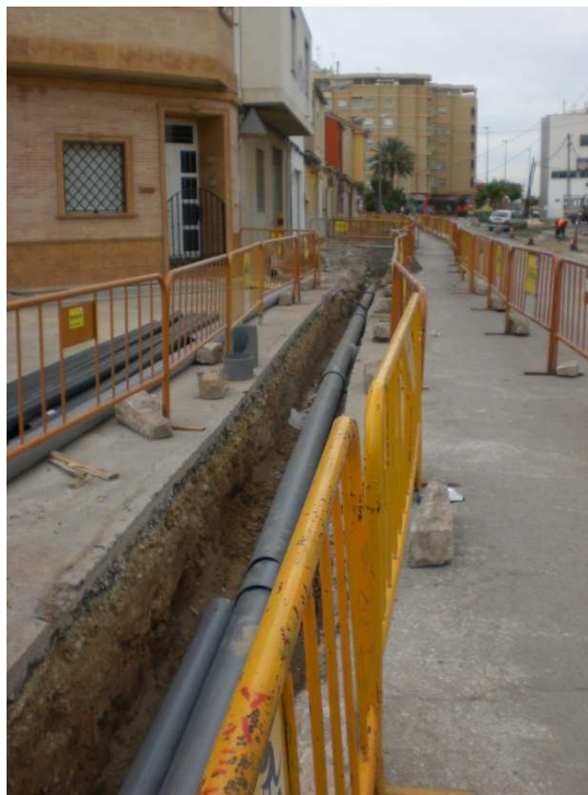
Apertura de zanja, colocación de tubería.
