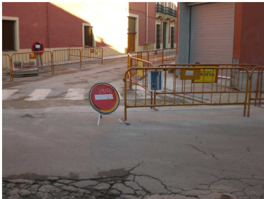
Señalización de la obra y accesos peatonales.
