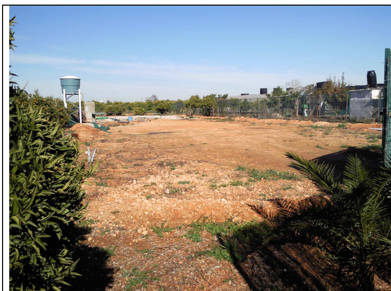
Fotografía donde se observa la retirada de 10 cm de capa de tierra vegetal en la zona sur de la parcela, y la existencia del depósito de agua y la presunta barbacoa.
