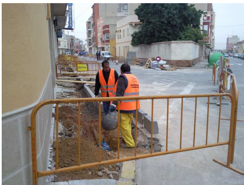
Colocación de bordillo
