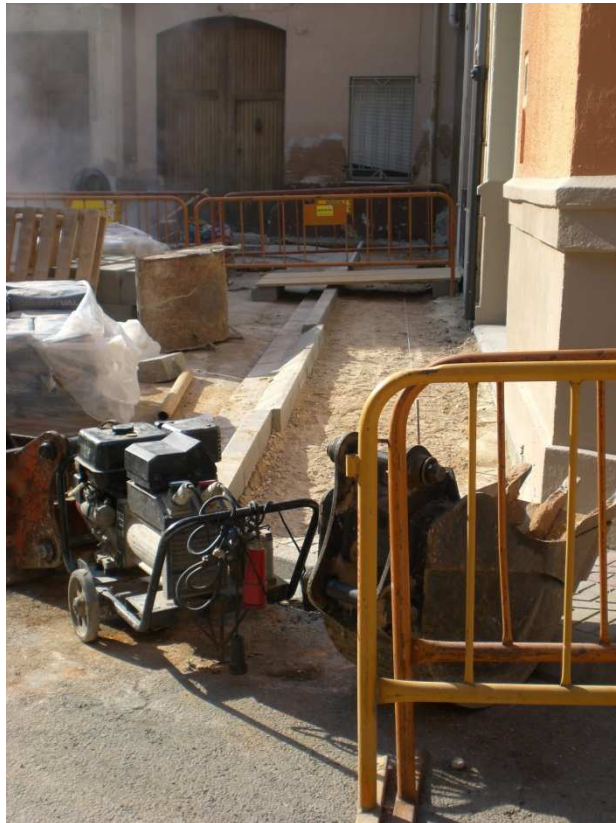
Colocación de bordillos y capa de zahorra compactada al 100% Próctor Modificado
