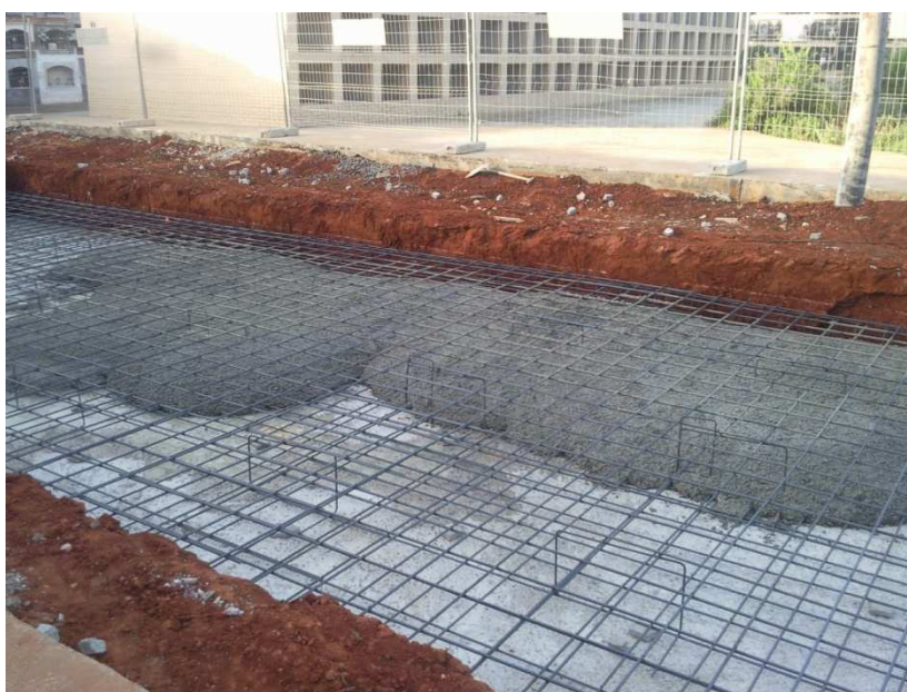
Vertido del hormigón
