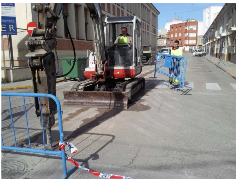
Demolición con medios mecánicos
