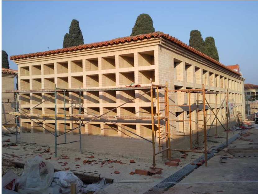
Ejecución del resto de los faldones que conforman la cubierta
