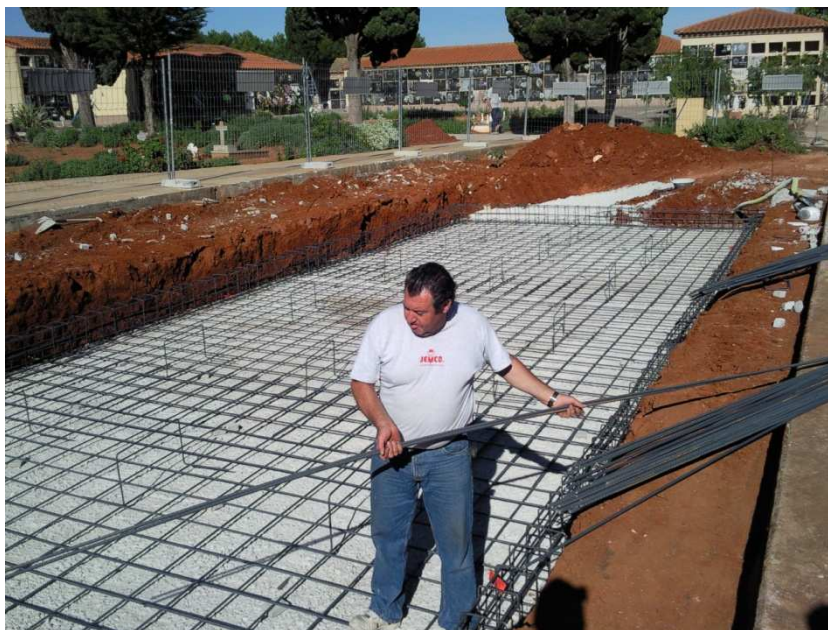
Armado de la parrilla inferior, colocación del zuncho perimetral y de separadores (pies de pato) para el apoyo de la parrilla superior
