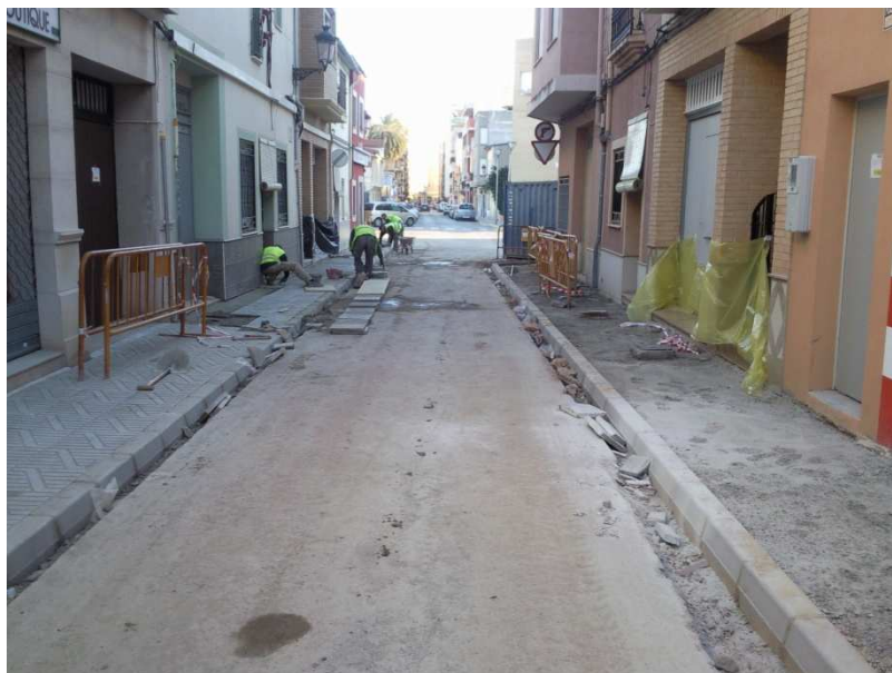
Colocación de baldosas en las aceras
