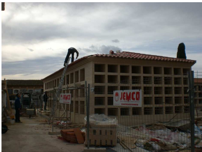
Ejecución del último faldón de la cubierta
