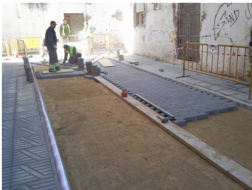
Colocación del adoquinado
