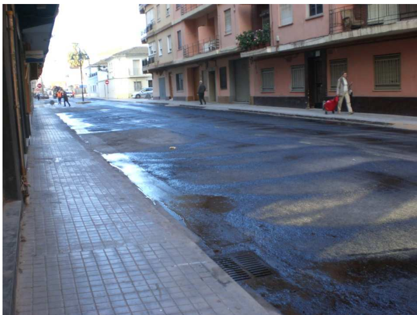
Asfaltado Calle La Fuente
