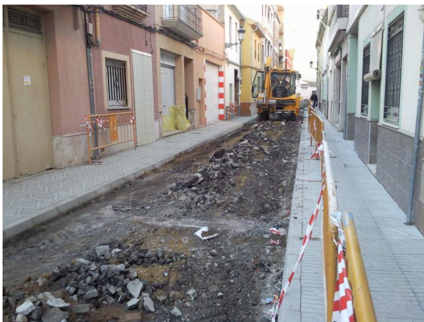
Levantamiento del asfalto para su posterior adoquinado
