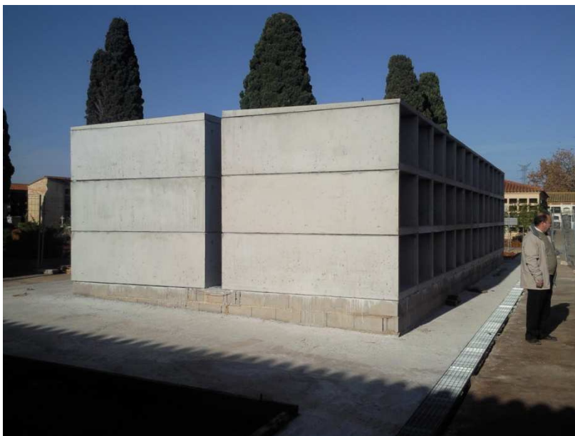
Vista de nichos prefabricados
