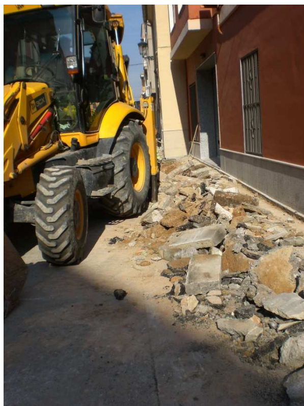
Demolición de la acera existente
