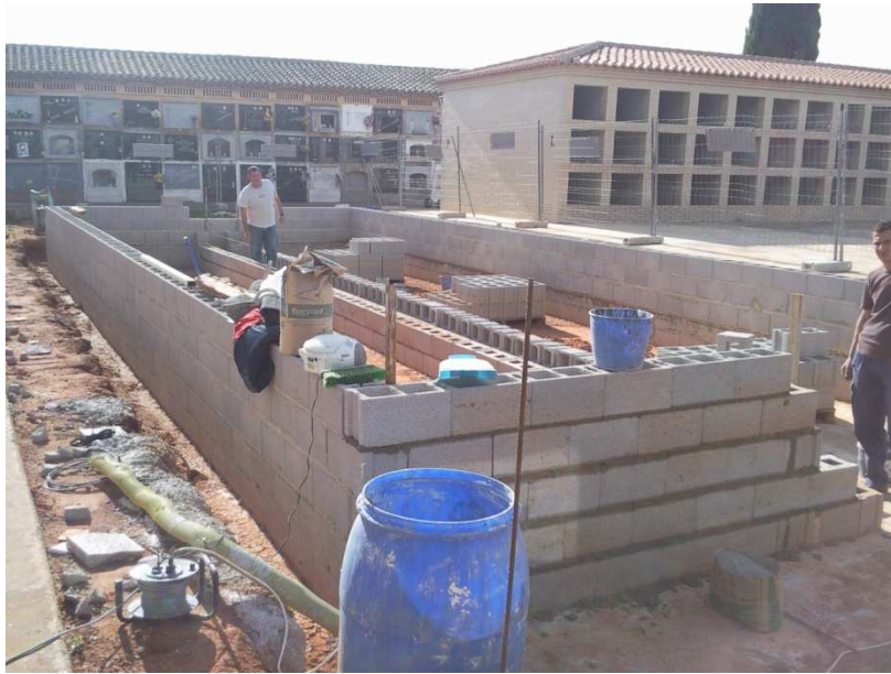
Construcción del cerramiento perimetral con bloques de hormigón
