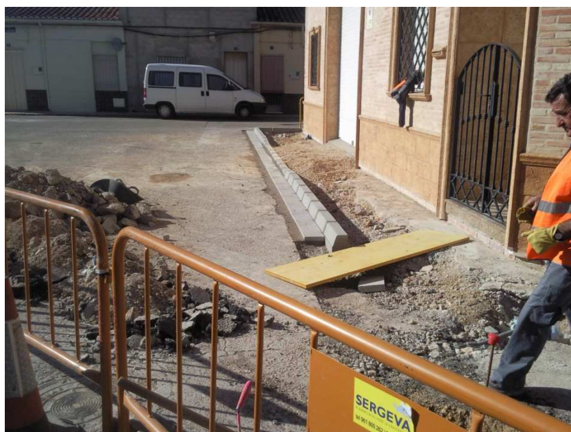
Demolición acera existente, colocación de bordillos y rigolas.
