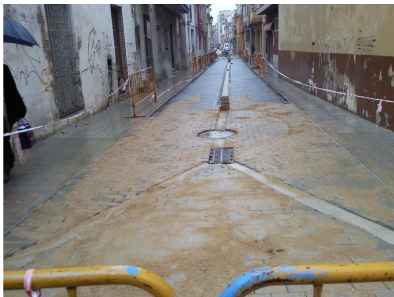
Vertido de arena para el relleno de juntas
