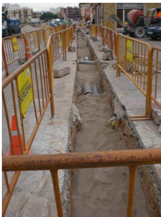
Relleno de arena sobre la nueva instalación.
