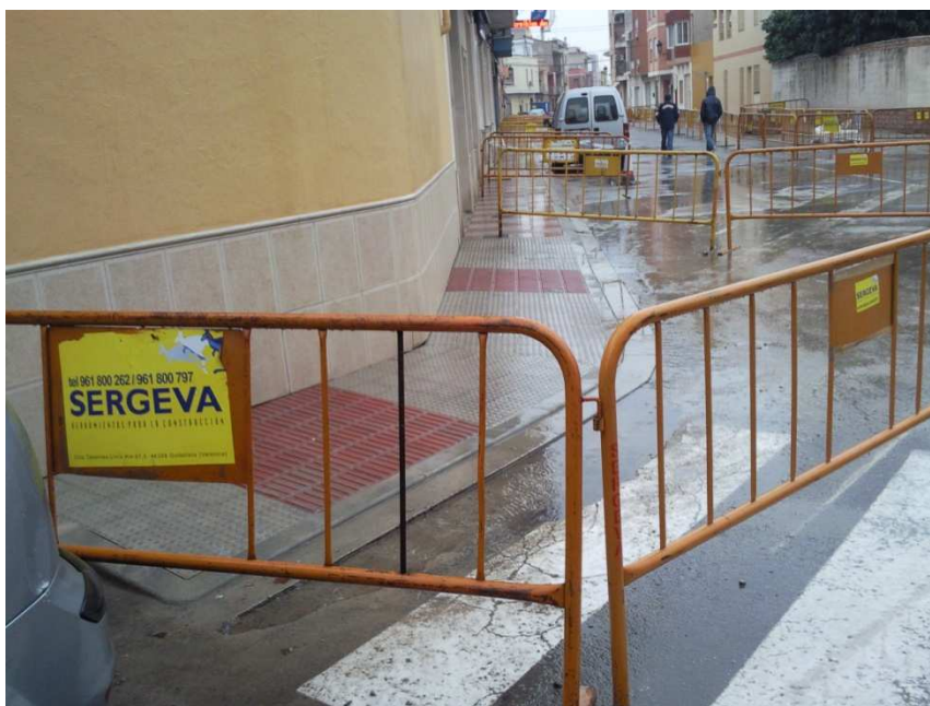
Ejecución de vado peatonal accesible a personas con la movilidad reducida
