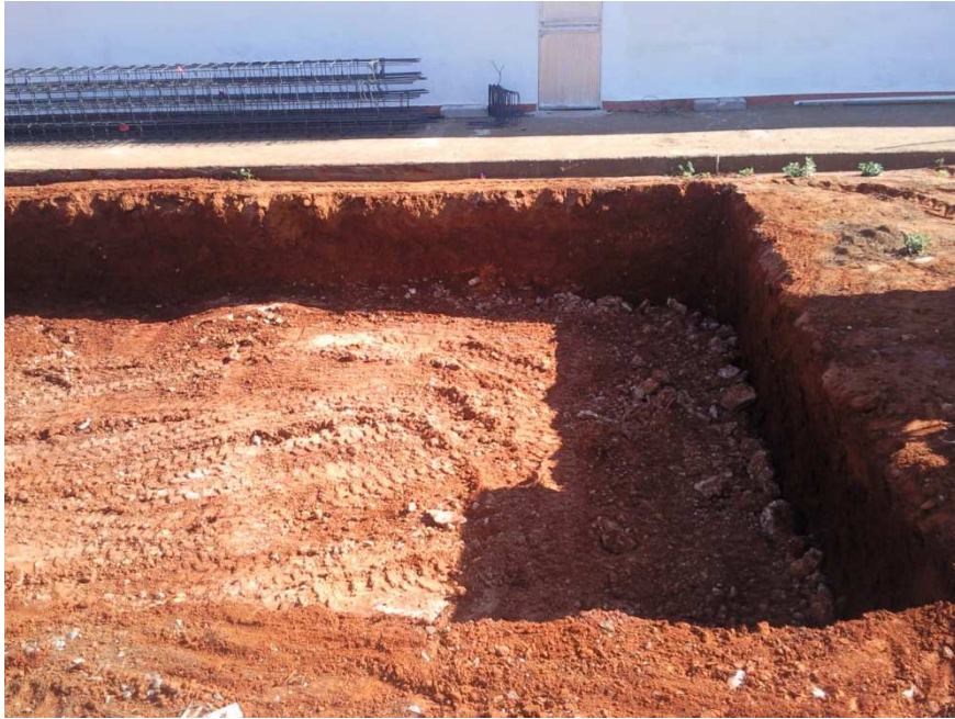
Movimiento de Tierras: Excavación de la losa de cimentación
