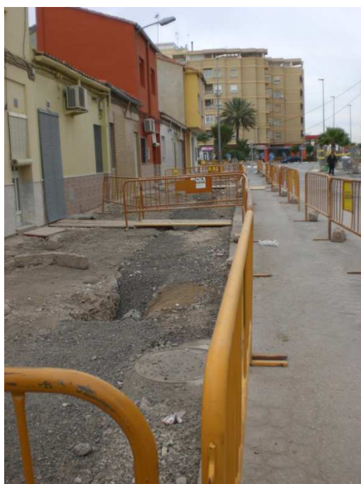
Relleno de arena sobre la nueva instalación.
