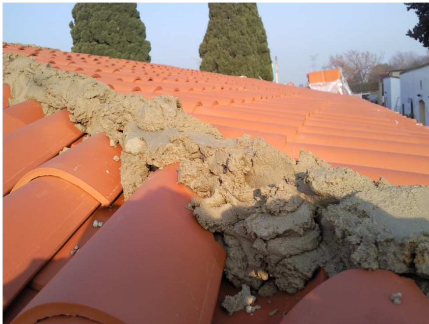
Ejecución de limatesas
