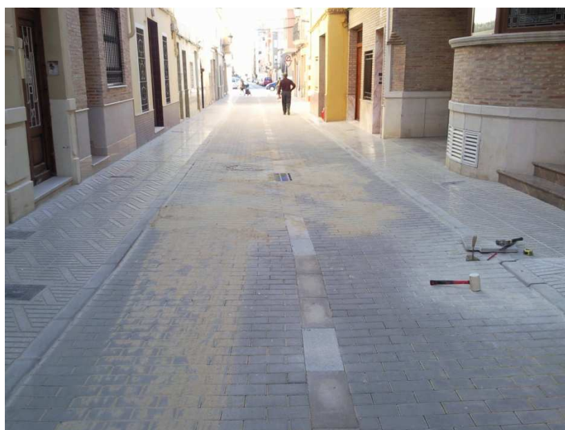
Regulación de los adoquines con medios manuales (maza) para nivelarlos
