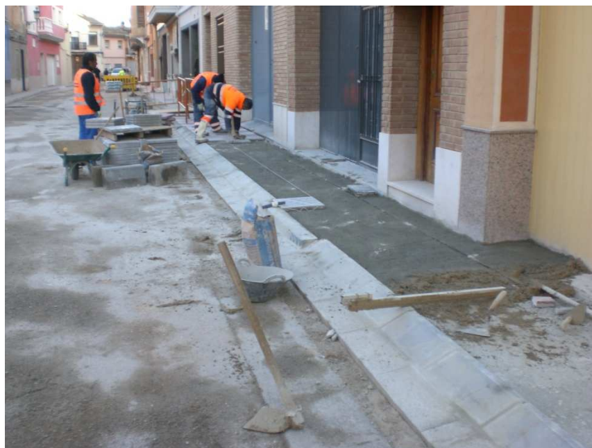
Colocación de pavimento de terrazo.
