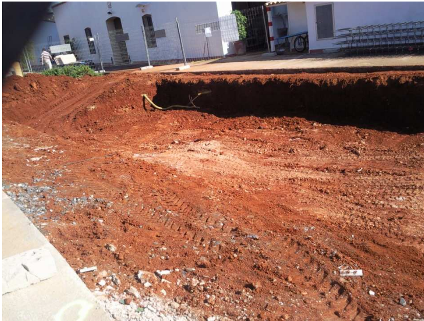
Excavación losa de cimentación
