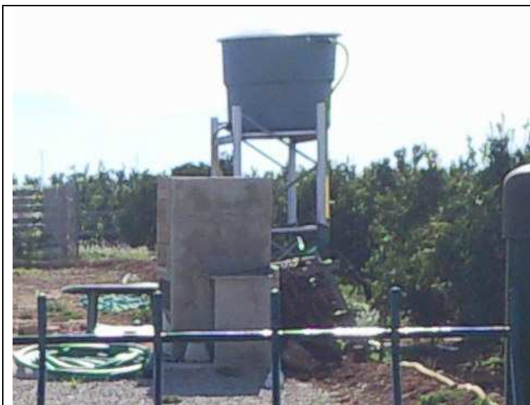
Detalle de la existencia de la presunta barbacoa junto al depósito de agua.
