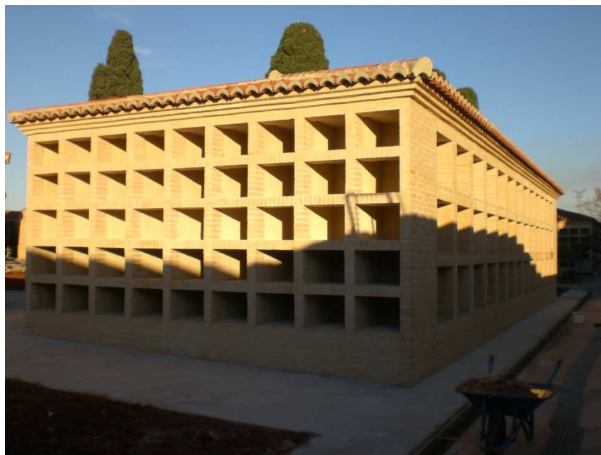
Ultimar detalles para la recepción de las obras
