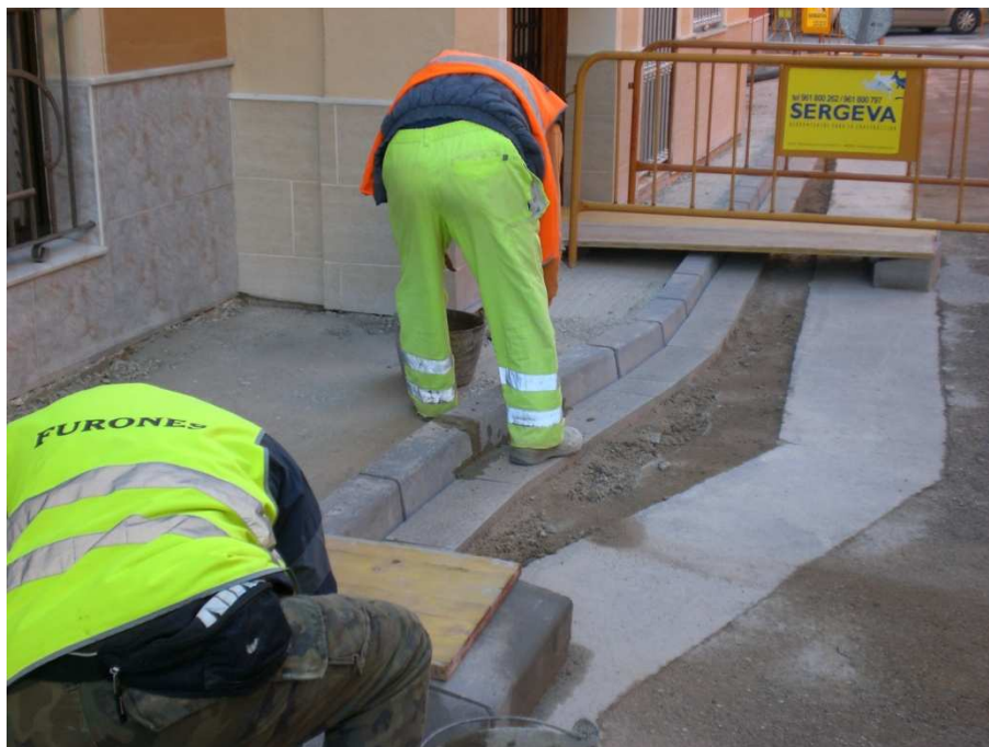
Remate de bordillos y rigola
