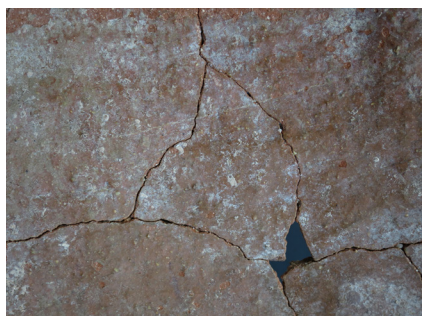
Figura 24. Concreciones calcáreas en el vidriado interior.
