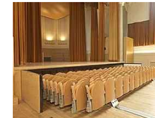
Almacenamiento de sillas bajo el escenario
