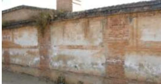
Imagen 11. Muro de tapia mixta con machones.
