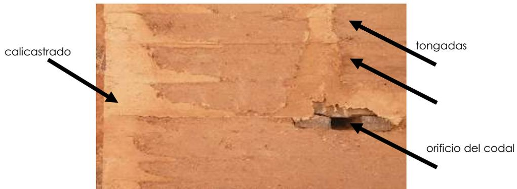
Imagen 8. Muro de tapia de tierra estabilizada. Fuente: <https://goo.gl/NUvggh>
