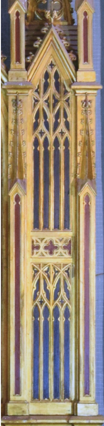
Fig. 19. Detalle de la calle lateral, se muestra el fondo de las tracerías y los pilares.
