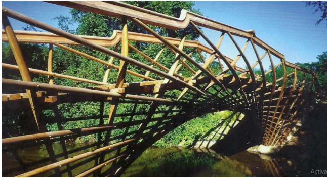
Fig 5.17. Estructura recíproca del Puente de Luxmore de Jamie McCulloch y Atelier One
