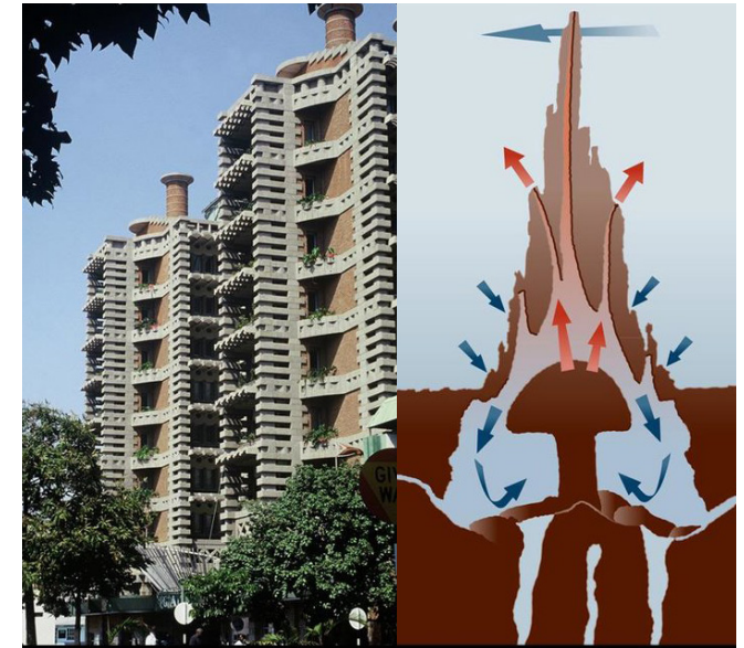
Fig 5.8. Vista exterior del Eastgate Center y su comparación con el sistema de ventilación de un termitero
