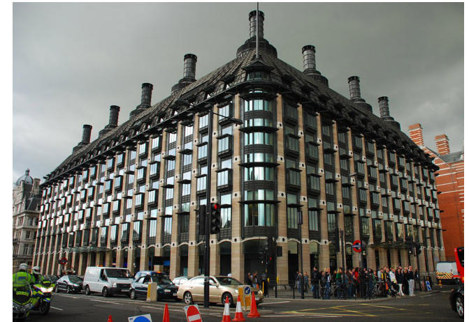
Fig 5.11. Vista exterior de Portcullis House en Londres.
