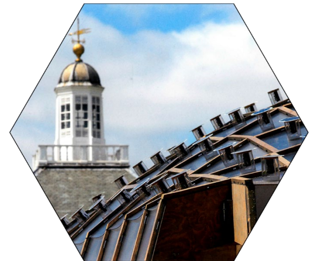
Figura 29. Vista detalle de la cubierta del pabellón en relación con la S.Gallery.
