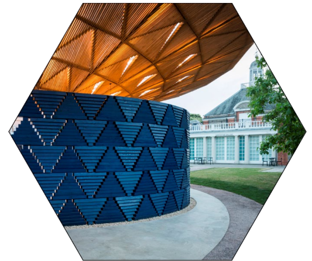
Figura 77. Vista del pabellón en relación con la Serpentine Gallery.
