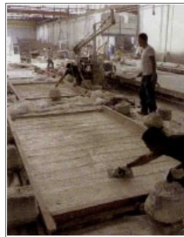
Elaboración de los paneles de GRC
