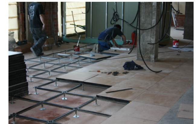
Instalación del suelo técnico
