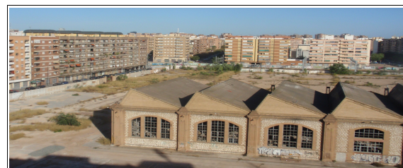
Nave existente en la parcela del proyecto
