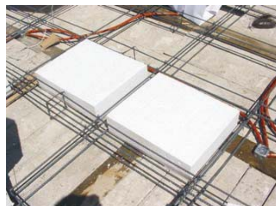
Forjado unidireccional de hormigón armado, nervios "in situ" aligerado con bovedillas de poliestireno expandido
