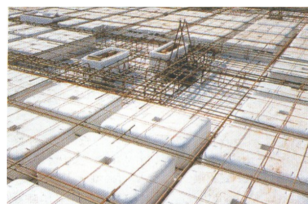
Forjado unidireccional de hormigón armado, nervios "in situ" aligerado con bovedillas de poliestireno expandido
