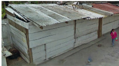
Módulo comercial individual, de madera y lámina de aluminio.
