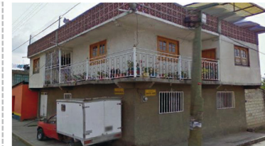
Vivienda de dos niveles por lo general por etapas. Ocupación total del terreno, sus acabados siguen siendo sencillos. Se pueden distinguir aleros, balcones y de manera variable garajes.
