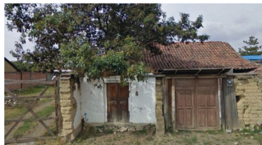
Vivienda con materiales tradicionales (adobe y teja). Terreno amplio con baja densidad de construcción.
