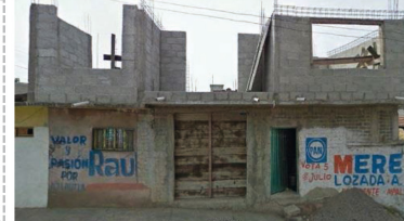
Vivienda en construcción, de uno a tres niveles.
