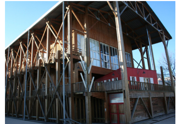
Patrick Bouchain. Construcción de un teatro y sala de ensayos con madera y chapa en Haute-Savoie, Francia.
