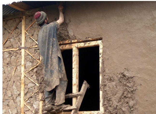
Article 25. Proyecto de autoconstrucción con adobe y resistencia sísmica en el Norte de Pakistán
