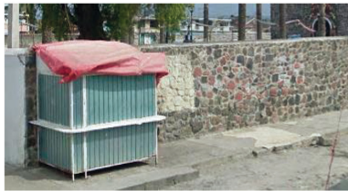
Módulo comercial individual, de aluminio y estructura de acero.
