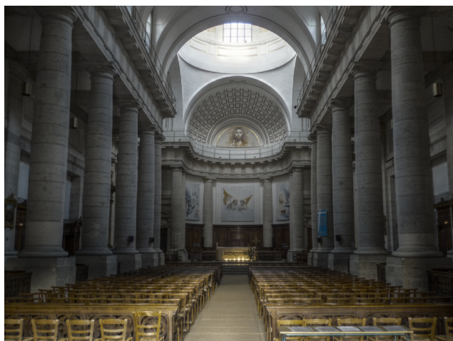
Figura 20. Léonard Roux. Iglesia de Saint-Vincent de Lyon (1759). Estado actual. Fotografía de Alexandre Norman (Wikimedia commons).
