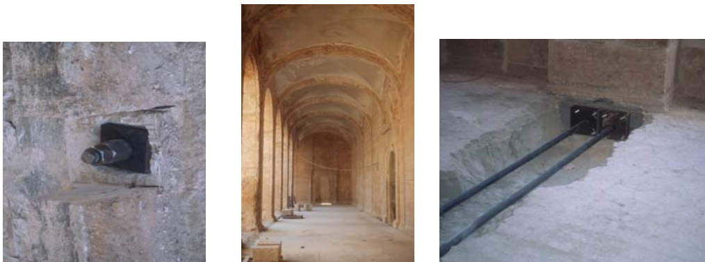
Figura 7: Atirantamiento en S. Miguel de los Reyes, Valencia
