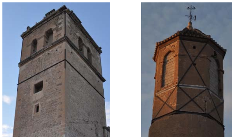
Figura 10: Refuerzo mediante zunchados en Lorca
