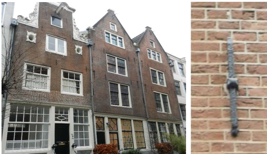
Figura 8: Anclajes tradicionales a nivel del forjado
