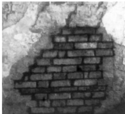
Figura 3: Reposición del muro [7]
