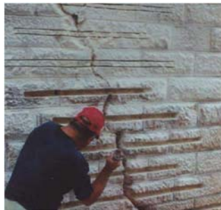
Figura 5: Refuerzo del muro mediante grapado [5]
