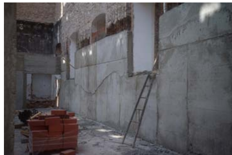
Figura 14. Intervención en muro fábrica, San Miguel de los Reyes.
