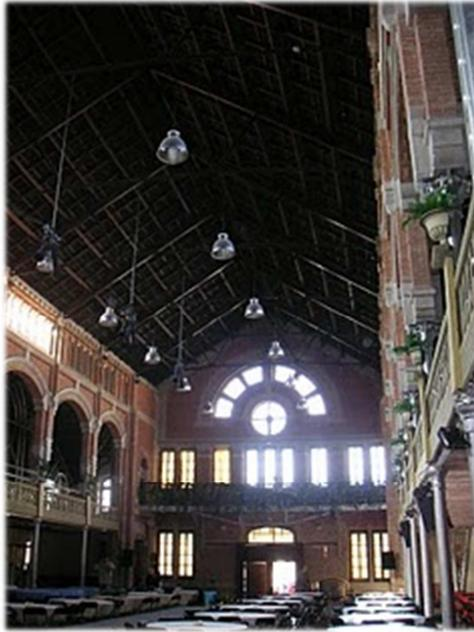
*Interior de la nave, donde se aprecia la estructura con cerchas de madera y metálicas, y pilares metálicos*
