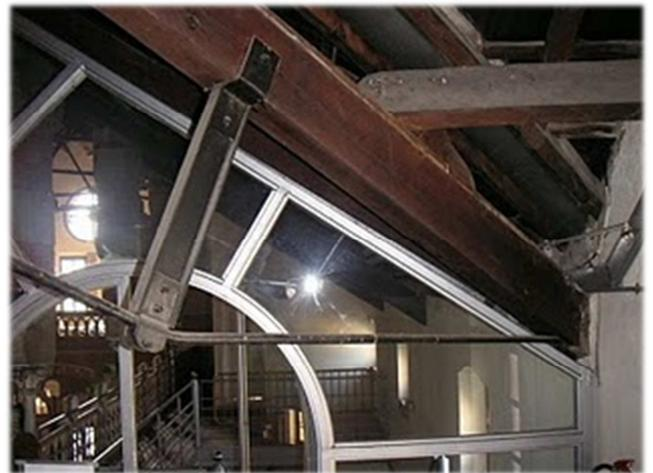
*Detalle de anclaje de cercha a muro*
