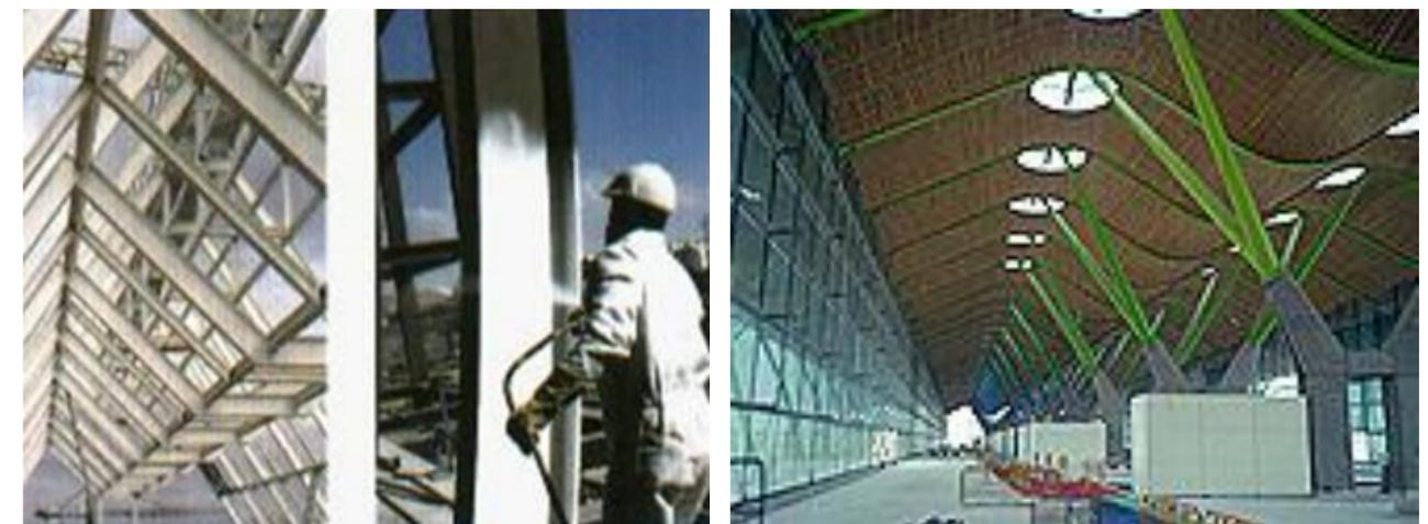
Ejemplos de aplicación de pintura intumescente de protección de la estructura metálica vista
