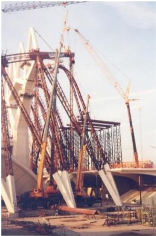
*Estructura de acero con arranques en forma de V.*
