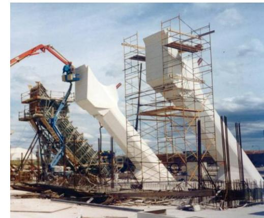
*Las imágenes muestran los diferentes tipos de encofrados utilizados en la obra, todos diseñados a medida para este proyecto.*
