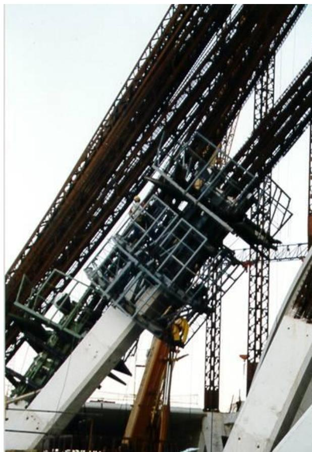
Armado y encofrado de los "dedos" de los testeros
