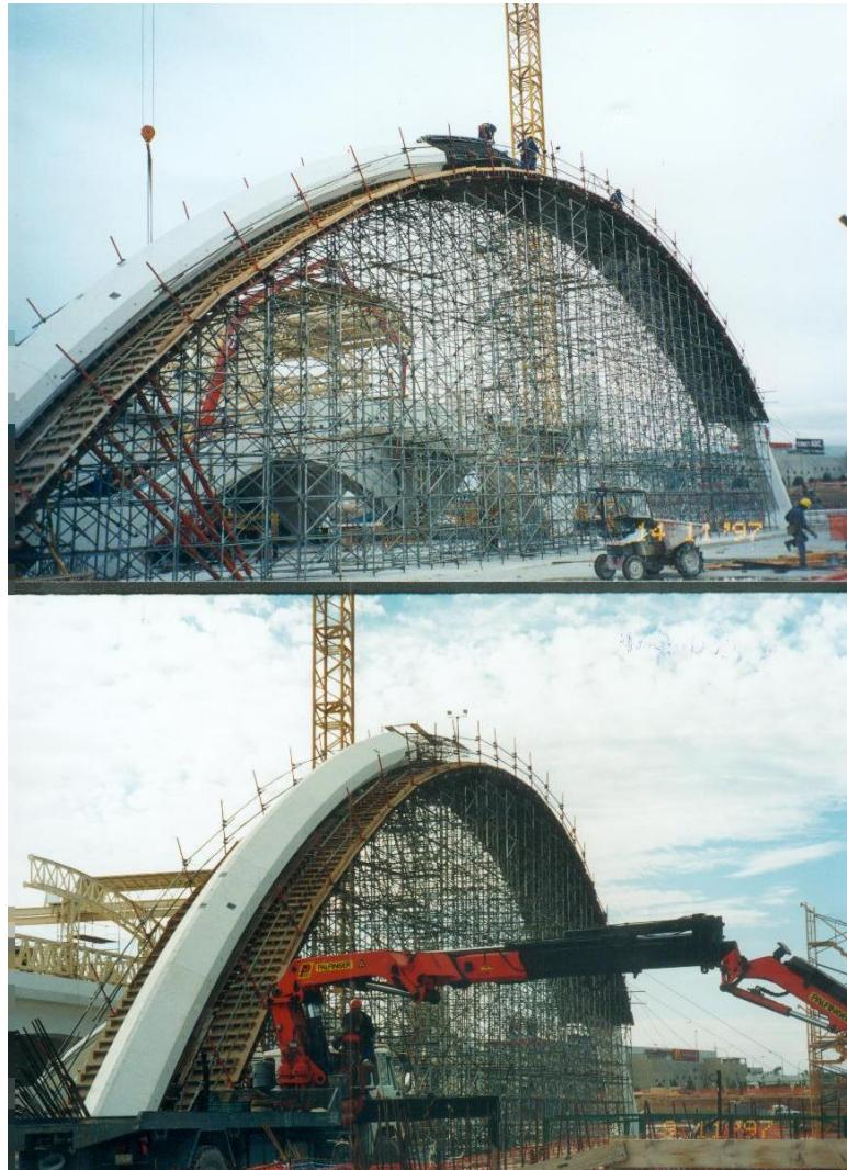
Construcción del arco con cimbrado.
