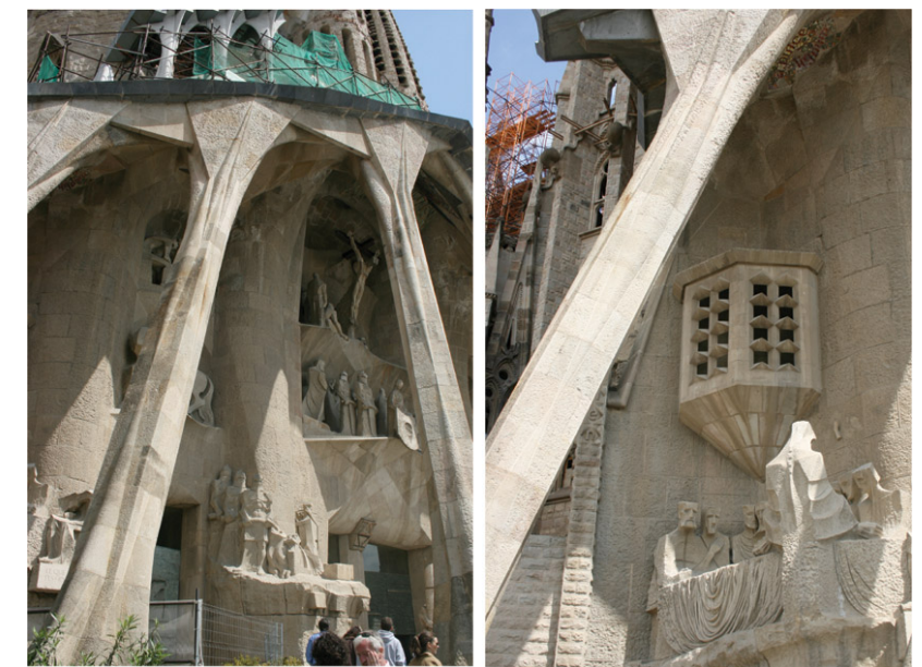
Columnas arboescentes de la entrada de la Sagrada Familia (Barcelona) (2.34)
