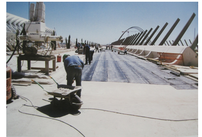
Imagen de la construcción de la cubierta de Umbracle (5.12)
