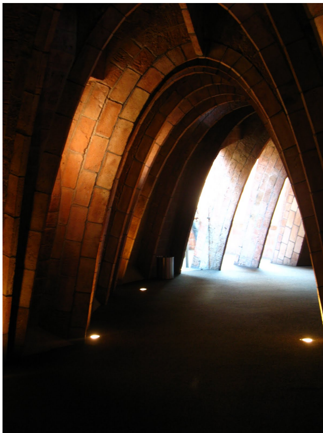
Vista de los arcos catenarios de la casa Mila (4.6)
