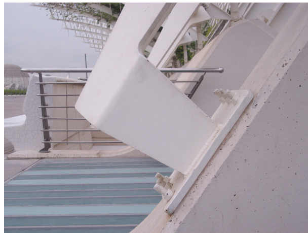
Detalles de la unión entre el soporte de la marquesina y el apoyo. (4.22)
