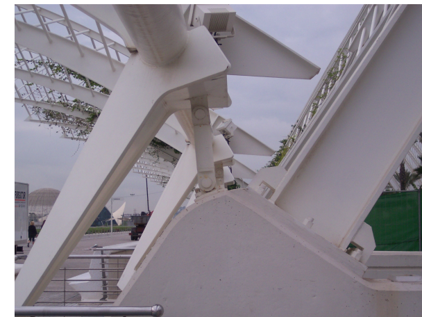
Detalles de la unión entre la marquesina y la pieza especial de soporte. (4.20)
