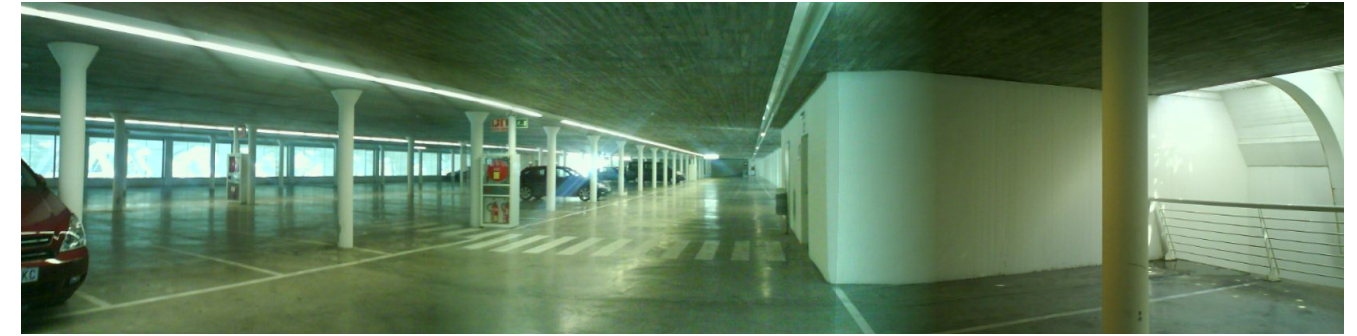
Vista del parking bajo cubierta. (5.1)
