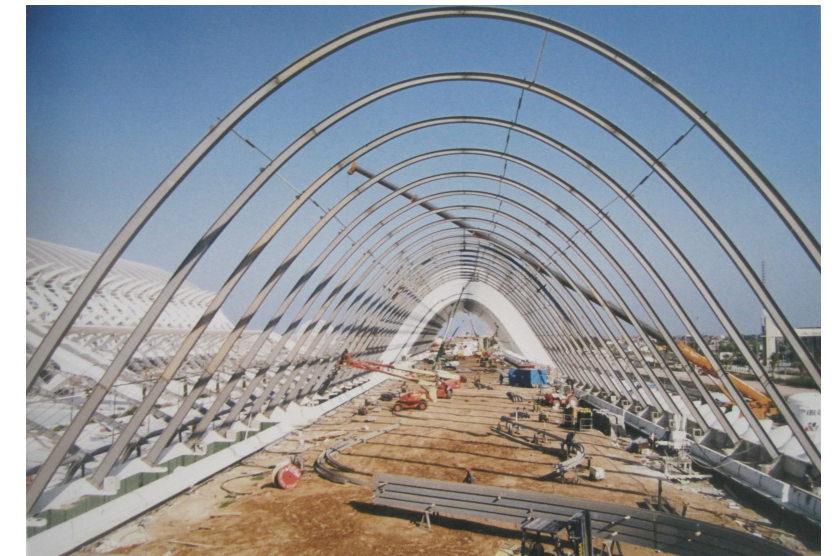
Imagen de la construcción de la cubierta de Umbracle (5.15)
