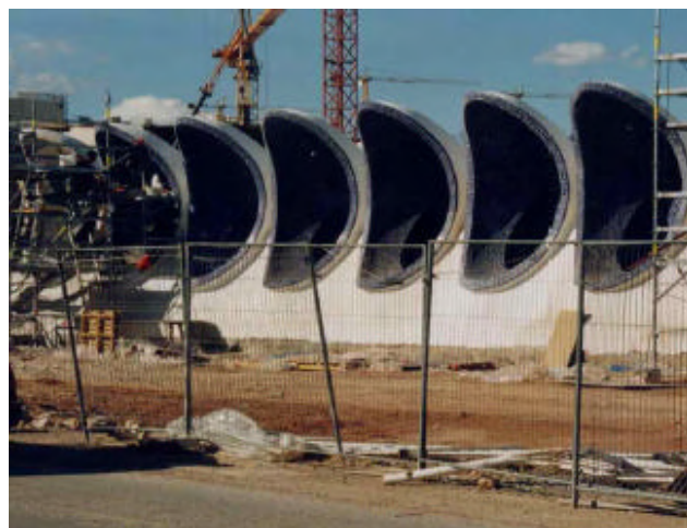
Colocación de trencadís (5.37 a 5.42)
