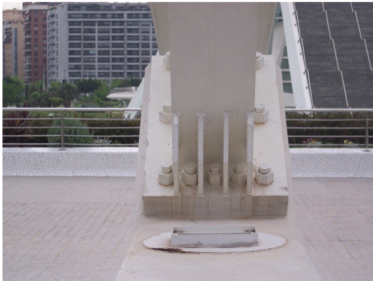
Imágenes de la unión de los arcos con los apoyos (5.25 y 5.26)
