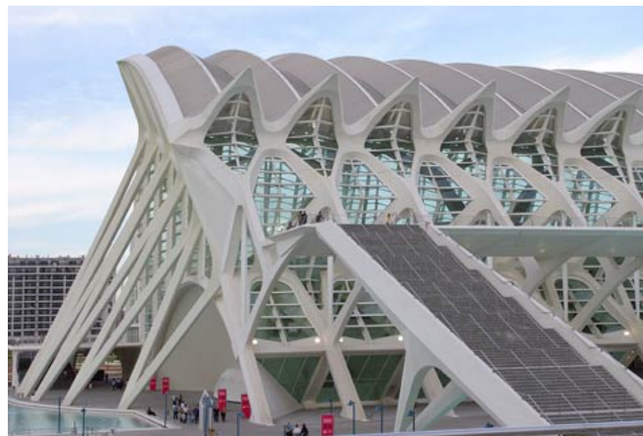
Columnas arboescentes de la fachada este del Museo Principe Felipe (Valencia) (2.32)
