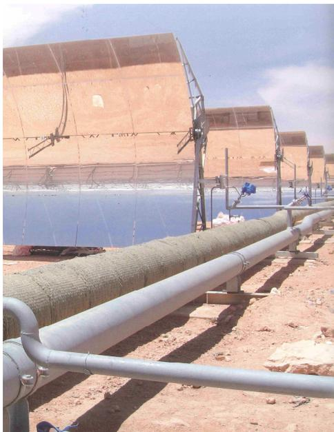
Durante el recorrido a través del campo y para conseguir una presión constante en toda la red, la pérdida de sección en las tuberías es directamente proporcional a la distancia que guarden con el bloque de potencia y al volumen de HTF que deban distribuir por los lazos restantes.
