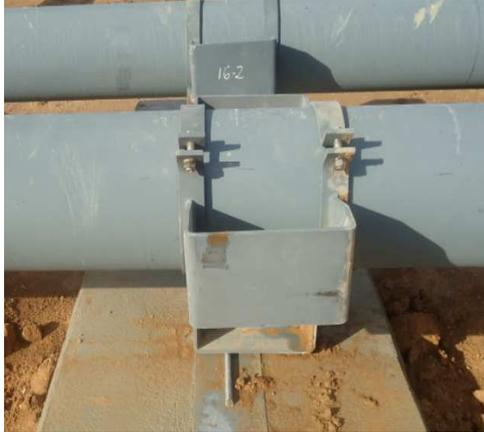
El método más común, consiste en la sujeción de una varilla redonda en la cimentación, sobre la que descansa una estructura de soporte de las tuberías colectoras que permite su deslizamiento.
