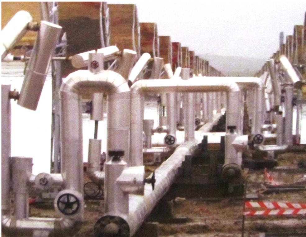
Actualmente en la totalidad de los casos de plantas termosolares instaladas en España no se encuentra realizada la instalación al 100% y el cierre o apertura de estas válvulas se realiza manualmente entre 2 o tres veces al año en concepto de cambio de estación por considerar variaciones de radiación importantes.
