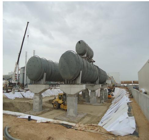
Deben situarse en el punto mas alto de todo el sistema HTF par conseguir una presión en el interior del sistema mediante la altura manométrica, que evite la cavitación en las bombas. Es decir, únicamente con la altura a la que se encuentran y mediante el peso del fluido consiguen establecer la presión que determina el fabricante de las bombas.
