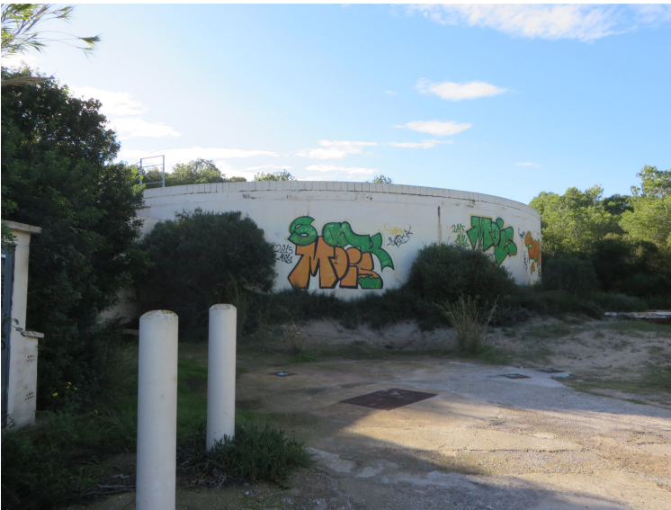
A8.31. Enclavado E33V9, avenida de los pinares s/n. Fuente: www1.sedecatastro.gob.es/Cartografia/mapa.aspx . Contenido: depósito de agua conectado a la red de distribución de agua potable, para dar servicio al monte. Preexistente a la urbanización de la Devesa .
