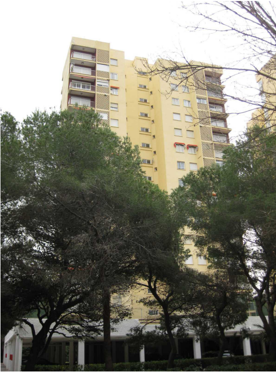
A8.6. Enclavado E8V9, avenida gola del Puchol 14. Fuente: www1.sedecatastro.gob.es/Cartografia/mapa.aspx . Contenido: Torres Proval VII-VIII , par de torres de apartamentos construido en 1977, correspondiente al Núcleo 8 del plan de ordenación de la Devesa .
