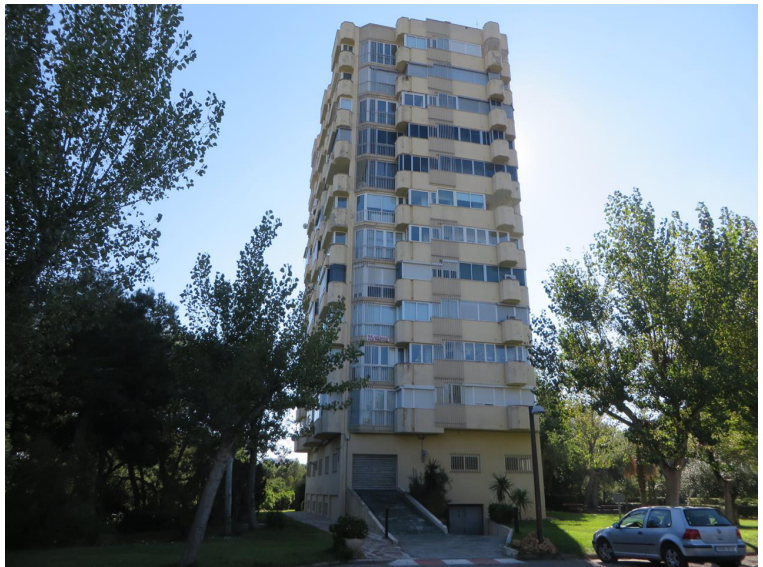
A8.17. Enclavado E19V9, avenida gola del Puchol 17. Fuente: www1.sedecatastro.gob.es/Cartografia/mapa.aspx . Contenido: torre simple de apartamentos construida en 1978, correspondiente al Núcleo 5 ( Aparwarks ) del plan de ordenación de la Devesa .
