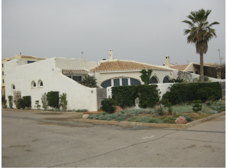
A8.4. Enclavado E6V9, calle Casbah (El Saler). Fuente: www1.sedecatastro.gob.es/Cartografia/mapa.aspx . Contenido: urbanización La Casbah . Poblado costero construido en 1976, correspondiente al Núcleo 2 del plan de ordenación de la Devesa .
