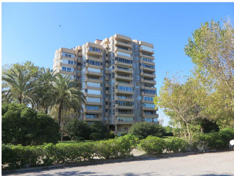
A8.15. Enclavado E17V9, avenida gola del Puchol 7. Fuente: www1.sedecatastro.gob.es/Cartografia/mapa.aspx . Contenido: torre simple de apartamentos construida en 1978, correspondiente al Núcleo 5 ( Aparwarks ) del plan de ordenación de la Devesa .
