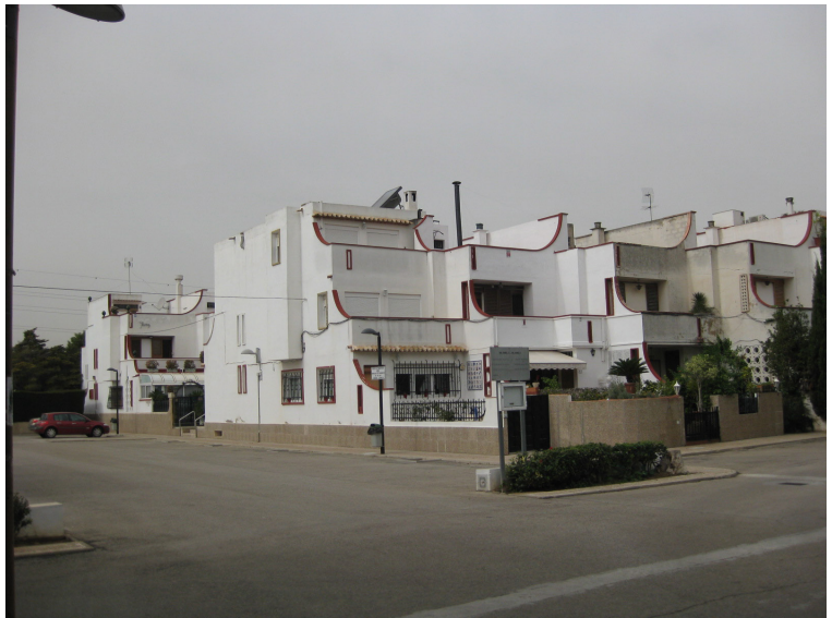
A8.5. Enclavado E7V9, avenida de los pinares 77. Fuente: www1.sedecatastro.gob.es/Cartografia/mapa.aspx . Contenido: urbanización Gavines II . Poblado interior construido en 1978, correspondiente al Núcleo 7 del plan de ordenación de la Devesa .
