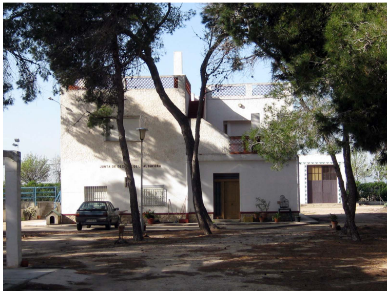
A8.2. Enclavados E1V9-E4V9, avenida de los pinares 89. Fuente: www1.sedecatastro.gob.es/Cartografia/mapa.aspx . Contenido: Edificio de la Junta de Desagüe del lago de L'Albufera de Valencia construido en 1953. La parcela contiene cuatro enclavados preexistentes a la urbanización de la Devesa .
