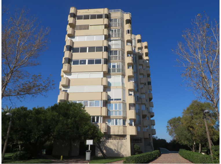
A8.16. Enclavado E18V9, avenida gola del Puchol 1. Fuente: www1.sedecatastro.gob.es/Cartografia/mapa.aspx . Contenido: torre simple de apartamentos construida en 1981, correspondiente al Núcleo 5 ( Aparwarks ) del plan de ordenación de la Devesa .
