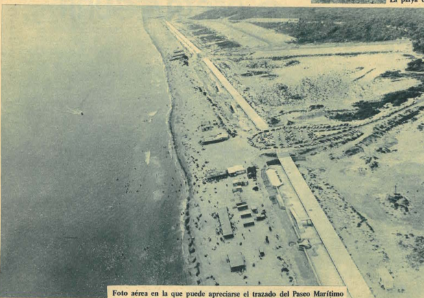
Foto aérea en la que puede apreciarse el trazado del Paseo Marítimo
