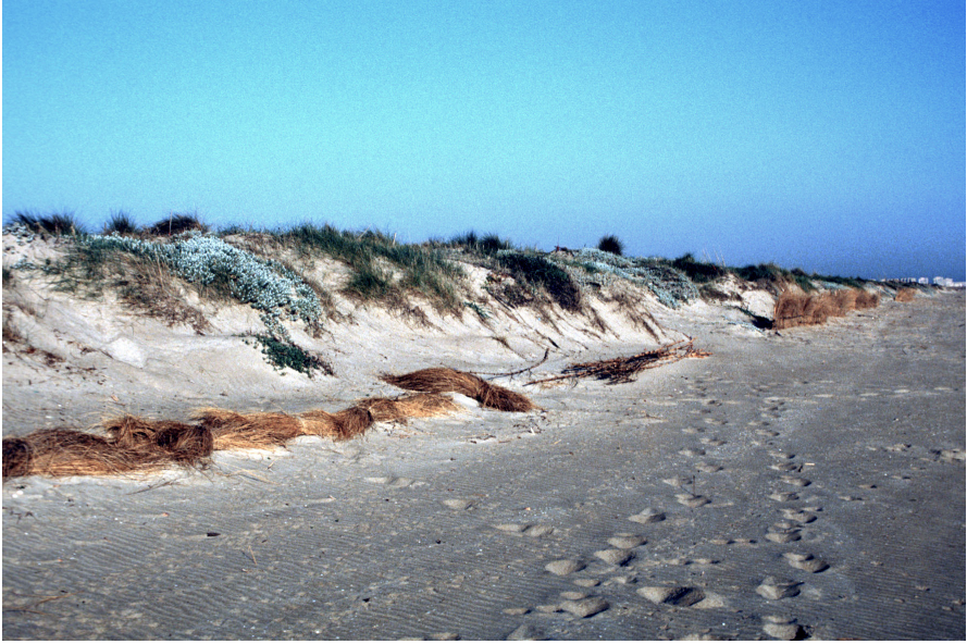
F25. Fotografía de la eliminación de las empalizadas de cañizo en la restauración del primer cordón dunar en la playa La Malladeta ( Devesa Sur ), 2007. Proyecto LIFE Duna . Fuente: Archivo fotográfico del Servicio Municipal Devesa-Albufera .
