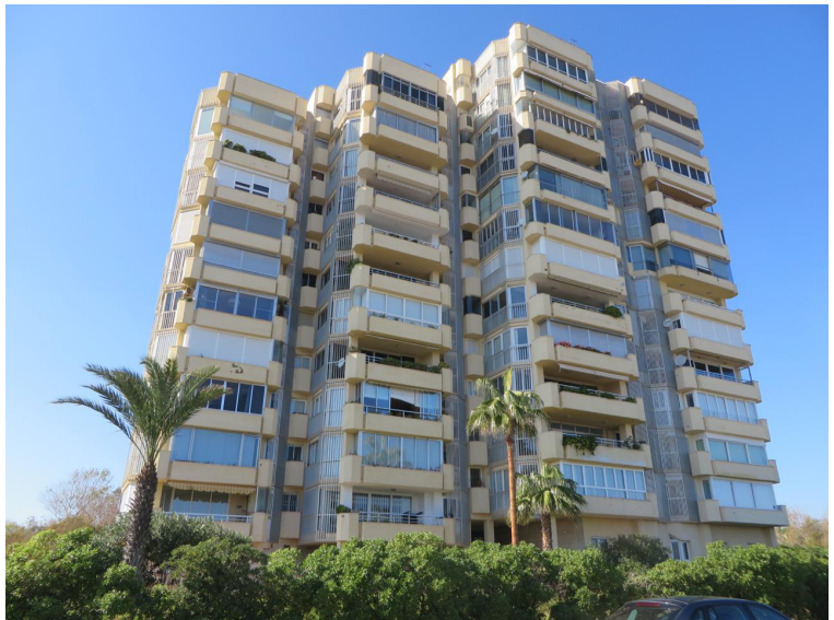
A8.13. Enclavado E15V9, avenida gola del Puchol 13. Fuente: www1.sedecatastro.gob.es/Cartografia/mapa.aspx . Contenido: torre simple de apartamentos construida en 1977, correspondiente al Núcleo 5 ( Aparwarks ) del plan de ordenación de la Devesa .
