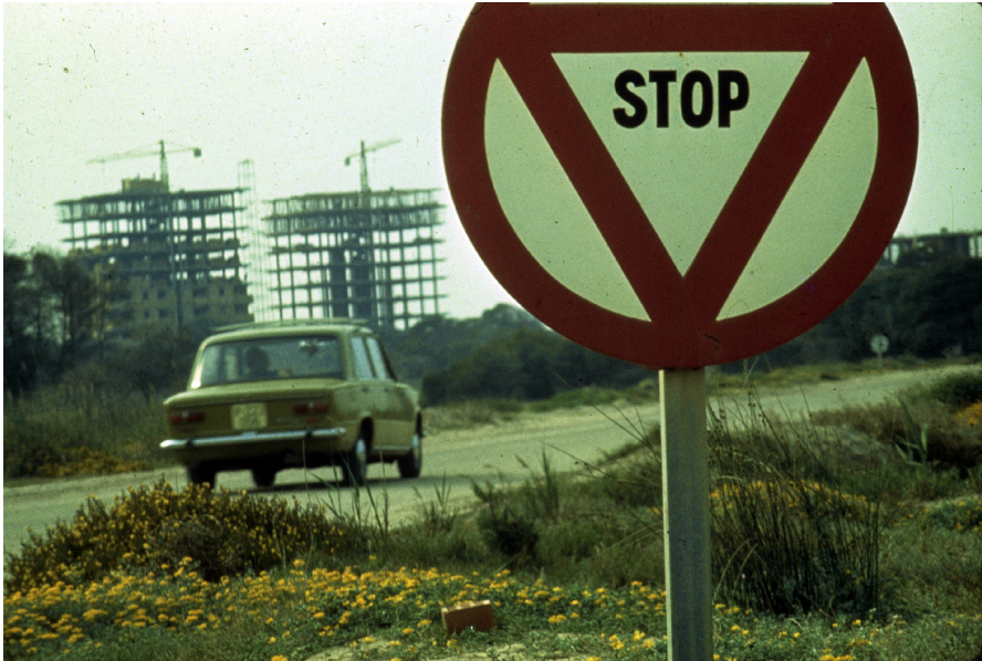
F99. Fotografía de las obras de construcción de dos torres en la Devesa (ca. 1973). Fuente: Archivo fotográfico del Servicio Municipal Devesa-Albufera .
