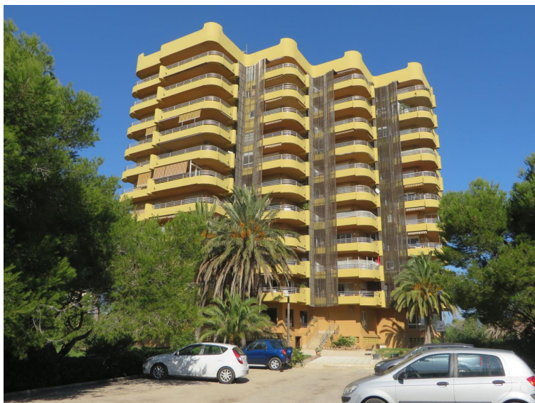
A8.27. Enclavado E29V9, avenida gola del Puchol 21. Fuente: www1.sedecatastro.gob.es/Cartografia/mapa.aspx . Contenido: torre simple de apartamentos construida en 1978, correspondiente al Núcleo 6 del plan de ordenación de la Devesa .
