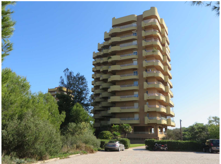
A8.25. Enclavado E27V9, avenida gola del Puchol 27(b). Fuente: www1.sedecatastro.gob.es/Cartografia/mapa.aspx . Contenido: torre simple de apartamentos construida en 1978, correspondiente al Núcleo 6 del plan de ordenación de la Devesa .
