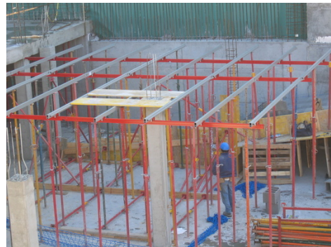
1. La construcción del forjado comienza con la colocación de los apoyos para los encofrados.
