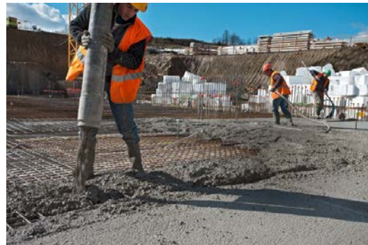
3. Acto seguido se procederá al hormigonado de la losa.
