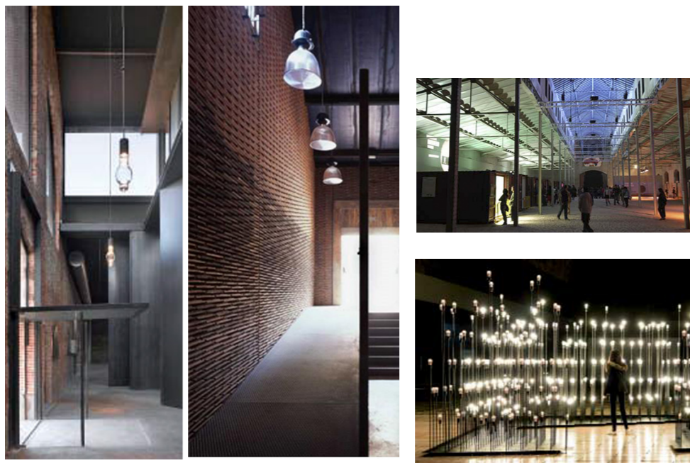
Luminarias (matadero Madrid) colgadas en dobles alturas y acceso Luminarias tubulares suspendidas (bandas) Ledscape (iluminación de suelo)
