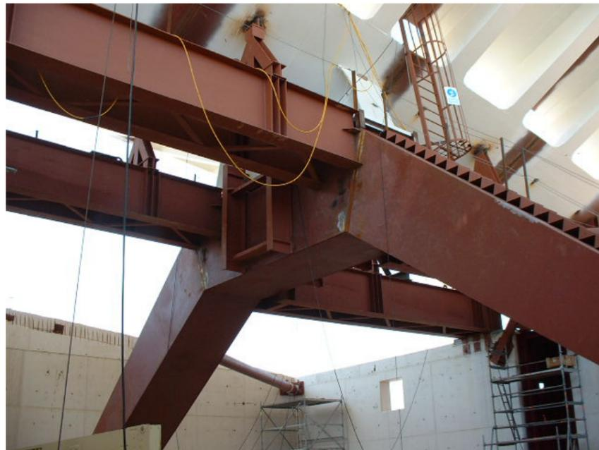
El primer paso de la construcción de la pluma corresponde a la colocación del apoyo intermedio, puesto que, ésta empezará a ejecutarse por la zona central.
