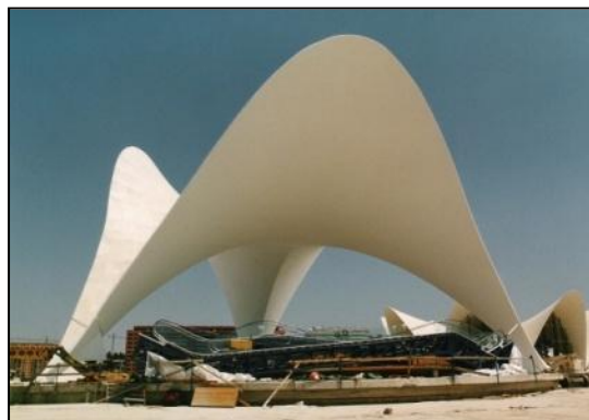
5.36 Cubierta desencofrada y terminada
