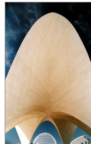
6.11 Cubierta de Restaurante
