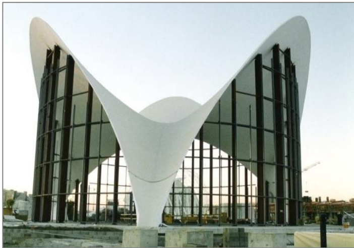
1.26 Estructura auxiliar de cerramiento
