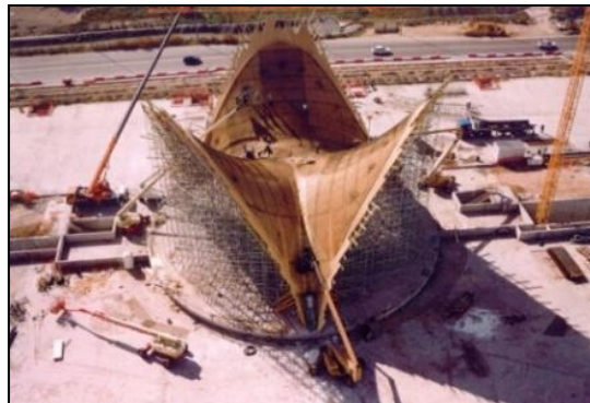
5.32 Inicio de hormigonado proyectada con grúa
