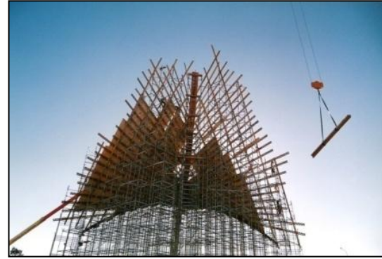
5.29 Entablillado de la cubierta
