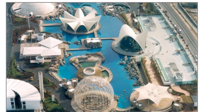
1.15 Construcción Oceanográfico, Valencia, 2002
