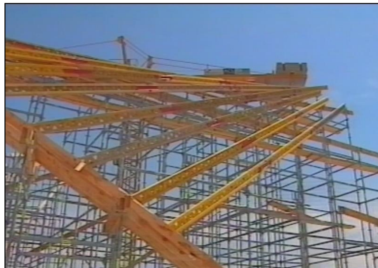
5.9 Colocación de las vigas unidas con perfiles UPN para dar continuidad.
