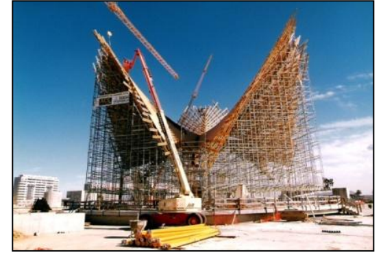
5.31 Fase previa a hormigonado de cubierta
