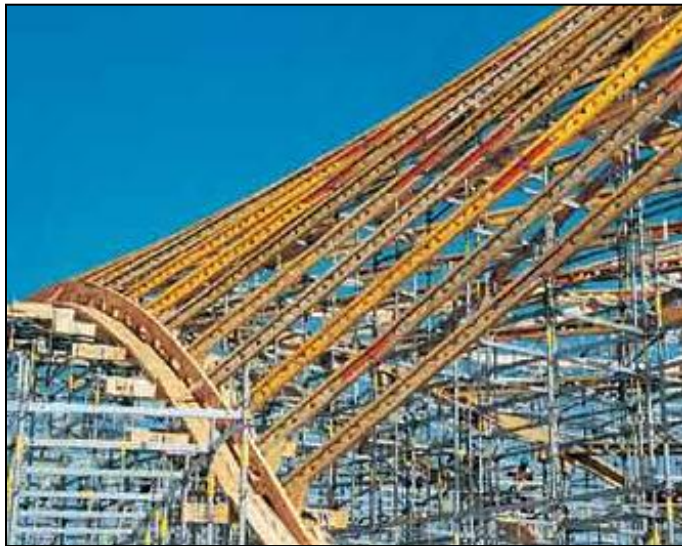
5.11 Colocación del encofrado del nervio
