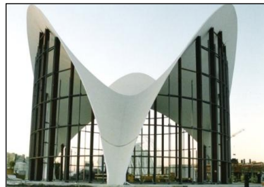
5.37 Estructura auxiliar de muro cortina
