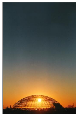
6.9 Construcción de edificio Mares Árticos
