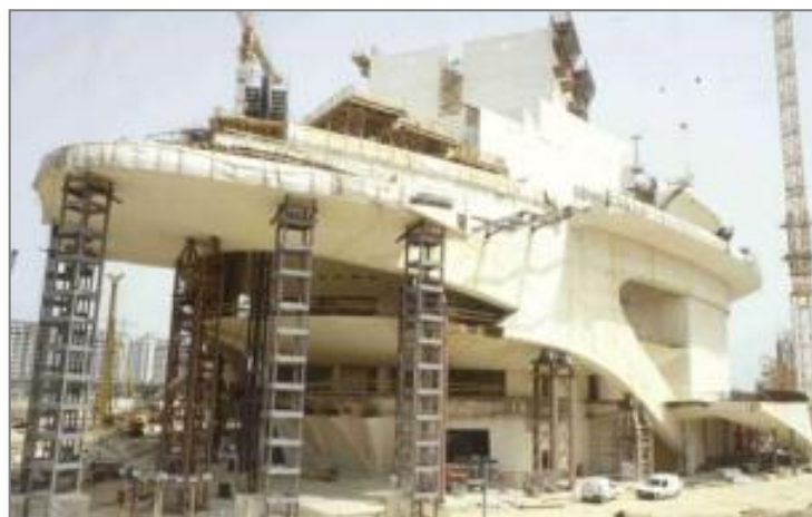
1.6 Palacio de las artes construcción
