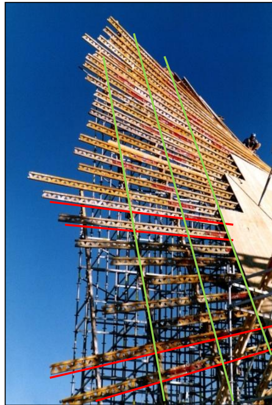
5.5 Acoplo de vigas GT 24
