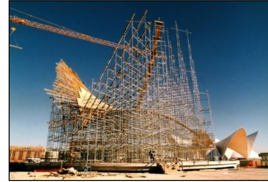
5.30 Encofrado de la cubierta
