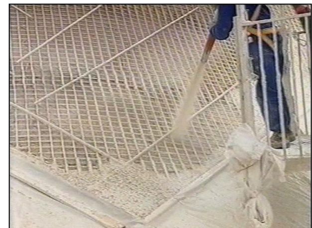
5.19 Proyección del hormigón
