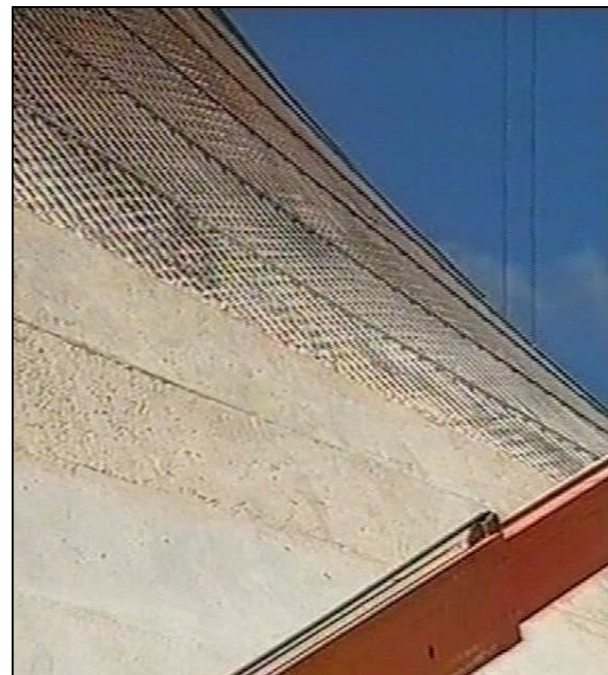
5.17 Fase del hormigonado
