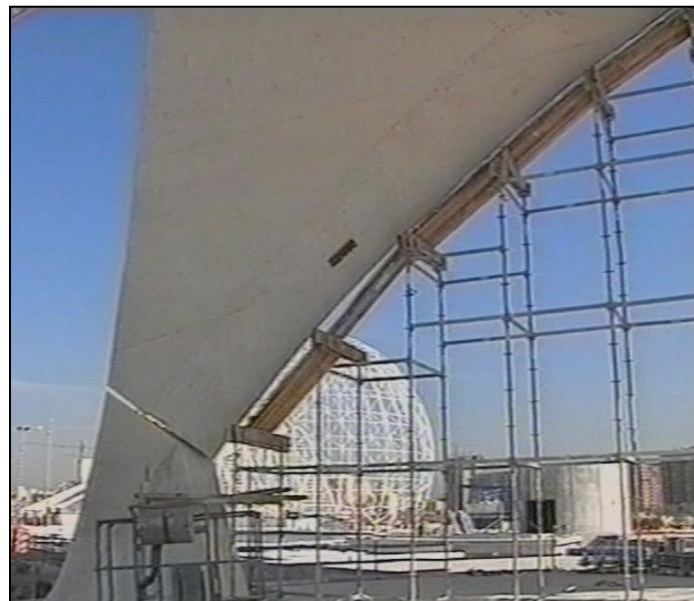
5.21 Descimbrado en zona de apoyo
