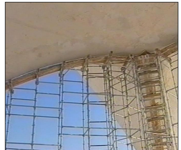
5.22 Descimbrado de la intersección de nervios
