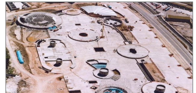
1.14 Construcción Oceanográfico, Valencia, 2000
