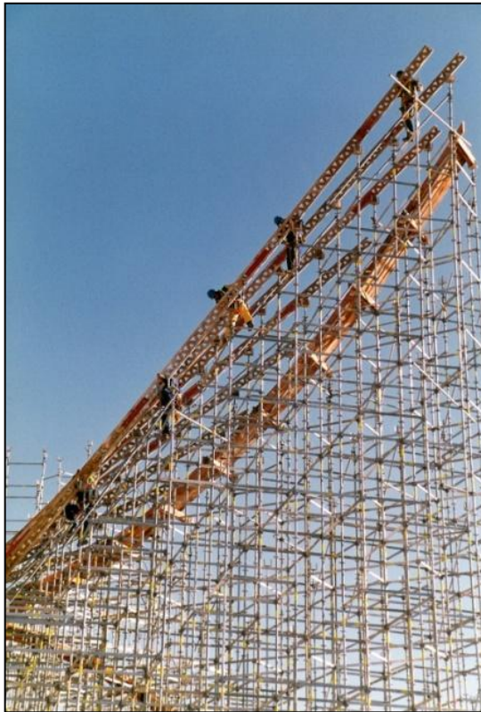
5.4 Colocación del cimbrado
