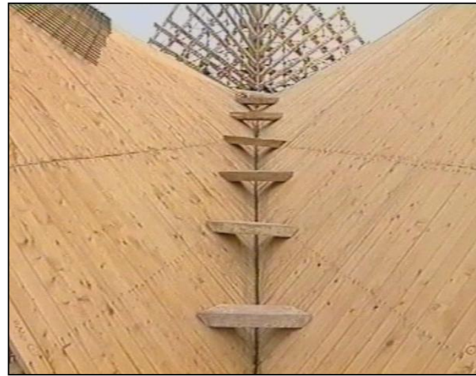
5.12 Encofrado y entablillado del lóbulo
