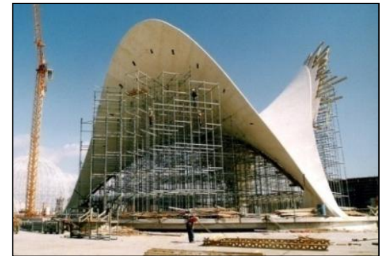
5.35 Cubierta en inicio de desencofrado
