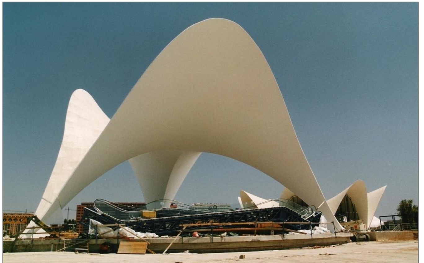
1.30 Cubierta del edificio de acceso
