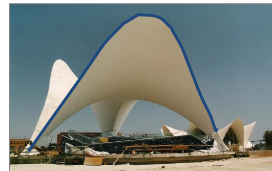
4.1 Borde libre de cubierta del edificio de acceso
