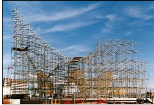
5.28 Colocación del andamiaje
