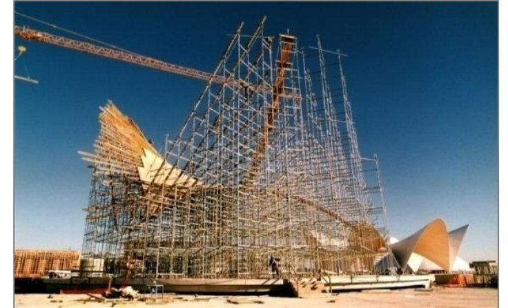
1.23 Inicio de encofrado
