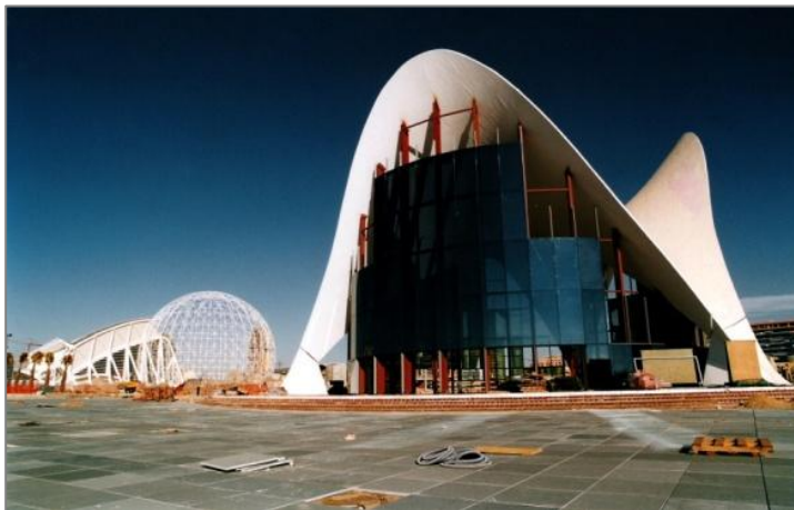
1.27 Ejecución del muro cortina
