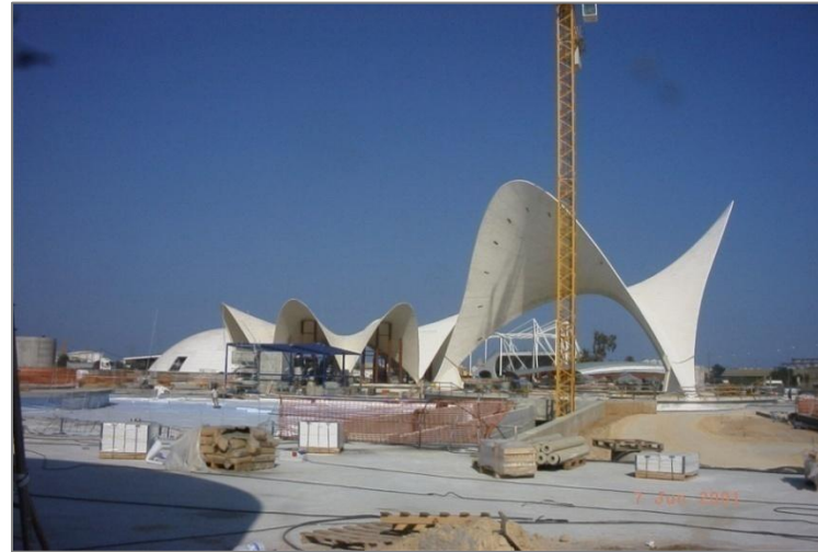
5.24 Inicio de colocación de cerramiento
