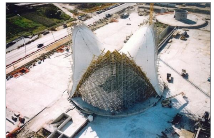
1.25 Finalización de hormigonado
