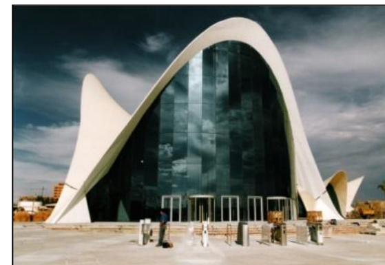
5.39 Edificio de Acceso terminado
