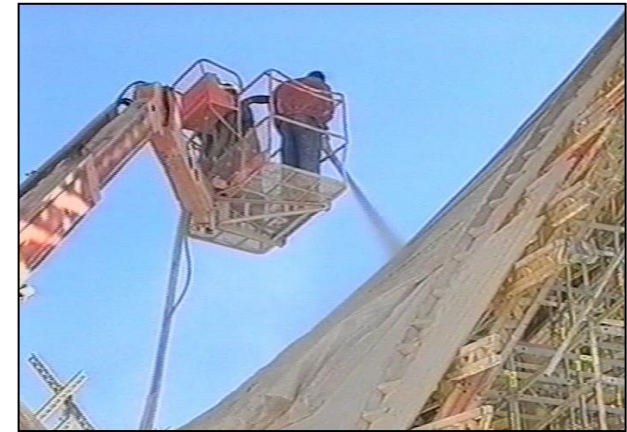
5.16 Proyección del hormigón
