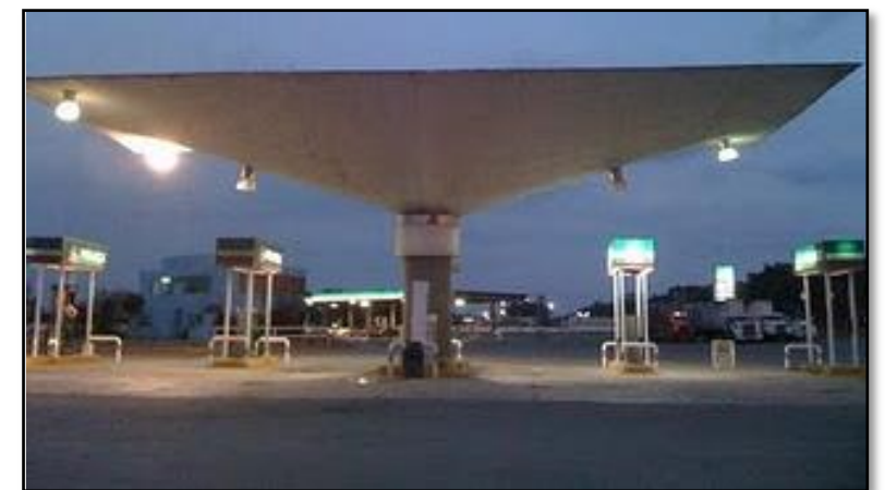
2.32 Paraguas de gasolinera, 2000
