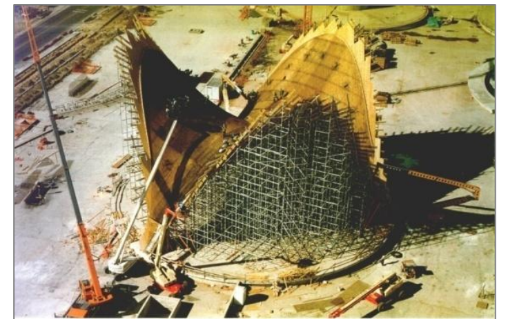
1.24 Inicio de hormigonado
