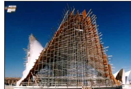
5.34 Curado del hormigonado
