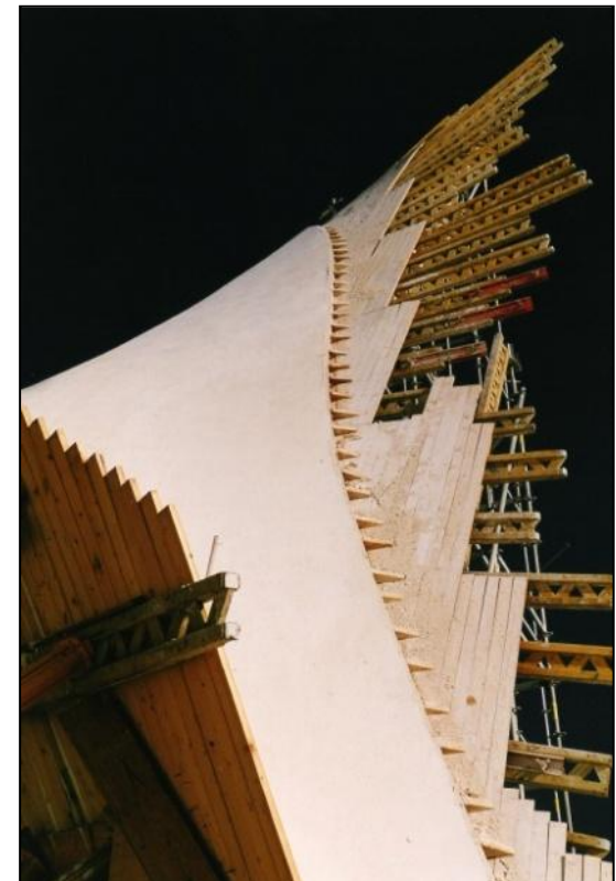
5.6 Cimbrado , encofrado y hormigonado de la cubierta
