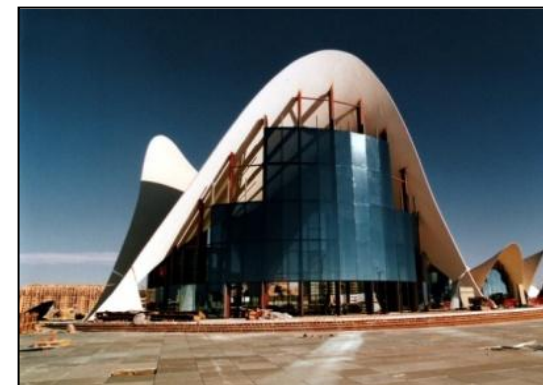
5.38 Colocación de muro cortina
