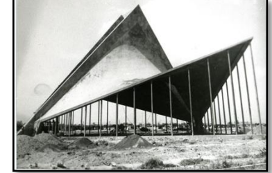
2.12 Iglesia de San José Obrero, Monterrey, 1959
