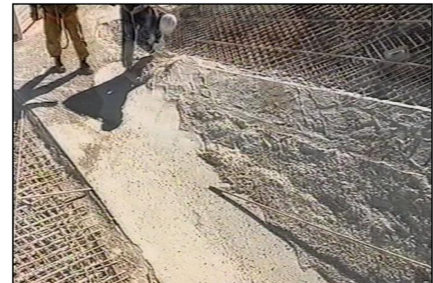
5.18 Colocación del mallazo
