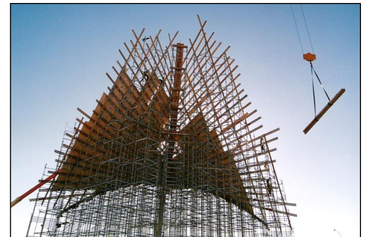
5.2 Arrastramiento de las torres
