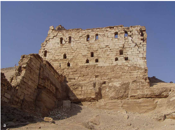
Fig. 11 a-b Detalle del edificio del Pretorio, Halabiye (autores)
