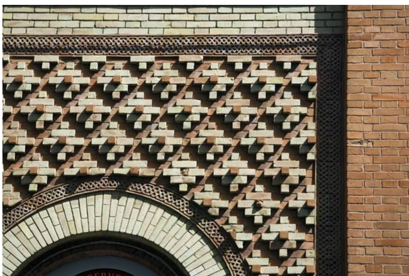
Fig. 7. Detalle fachada ladrillo. Estación de Sevilla Plaza de Armas. IAPH.
