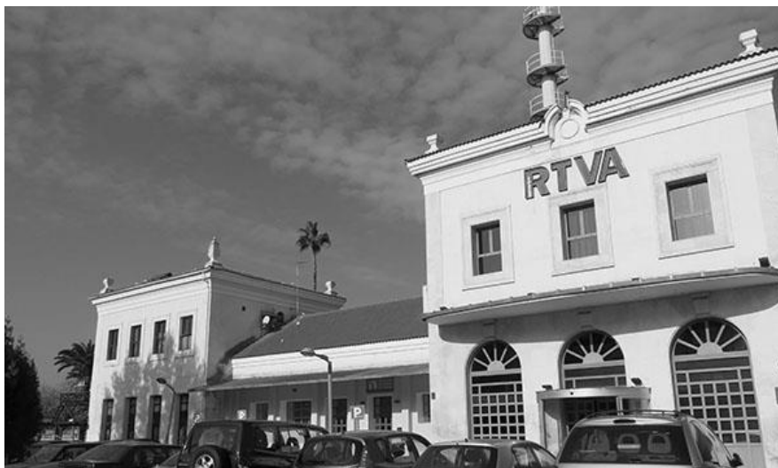
Fig. 6. Estado actual antigua estación de Córdoba. A. Propio (2017)
