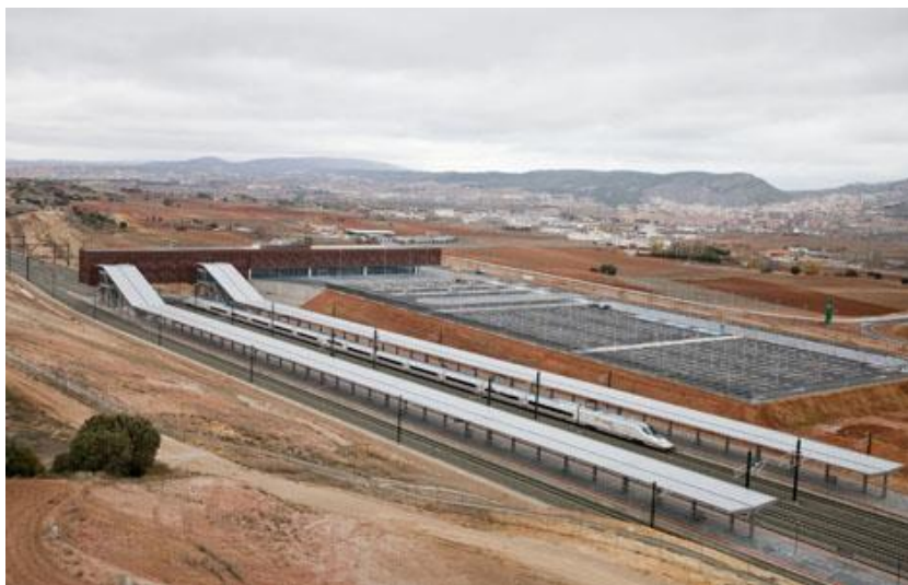
Fig. 8. Estación de Cuenca Fernando Zóbel. Adif.
