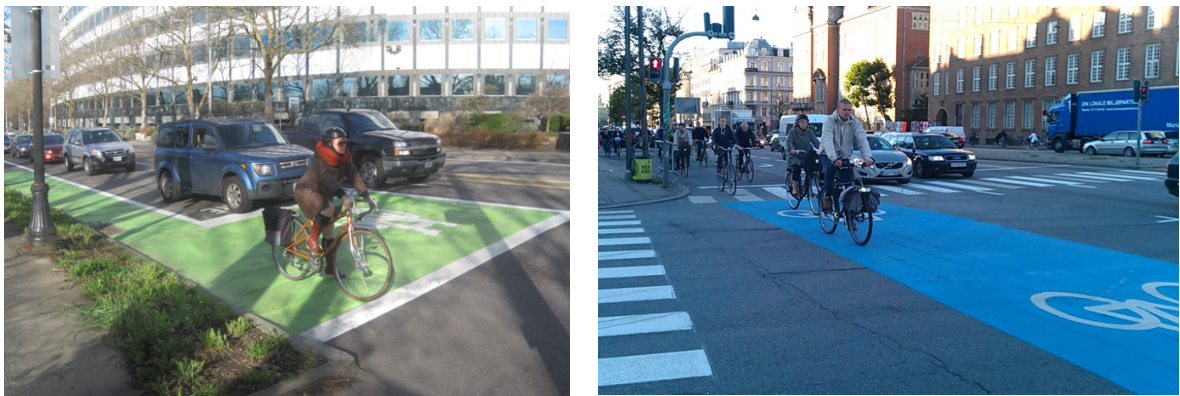
FIGURA 9 – Ejemplos de asfaltos coloridos para demarcar infraestructura ciclista verde en Portland, EE.UU y azul en Copenhague, Dinamarca
