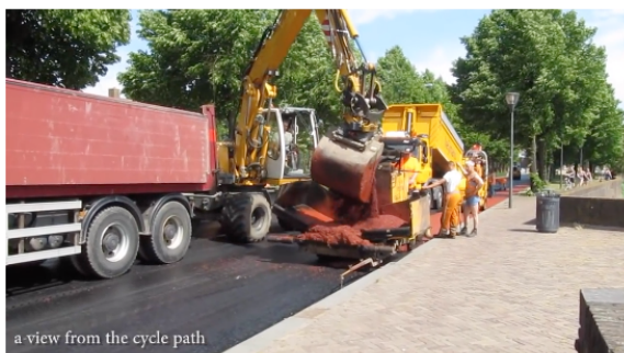
FIGURA 8 - Aplicación de asfalto rojo para demarcación de carril bici en Ámsterdam
