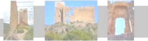
Las troneras de la muralla, circulares, están en las esquinas controlando mejor la base de los muros. Así la construcción del muro exterior responde a los modelos defensivos de finales del siglo XV. La desaparición de los ángulos rectos fue posible sin la tapialera, con construcciones de piedra y mortero.
