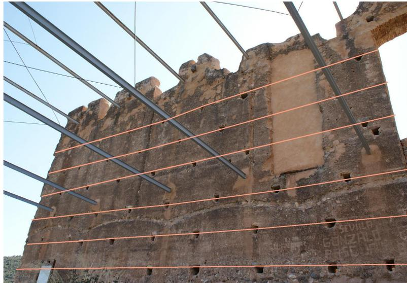
Marca de las agujas y línea del encofrado
