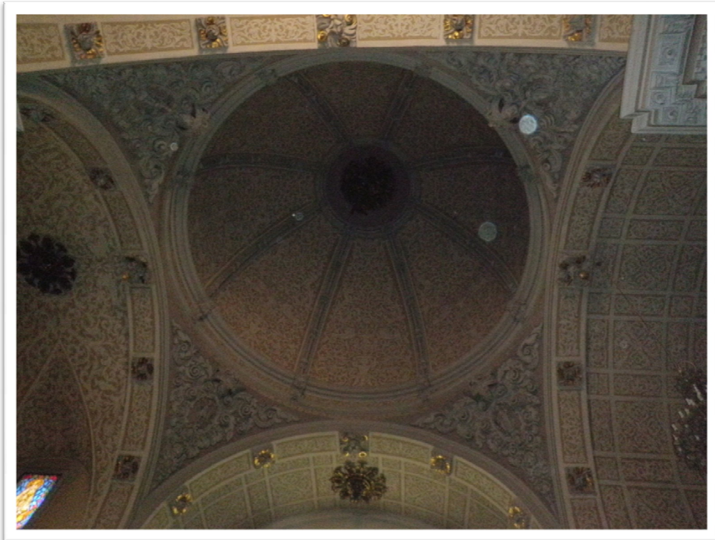
10. Cúpula de la nave central.
