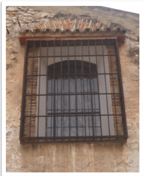
7. Ventana con vidriera de la fachada posterior.
