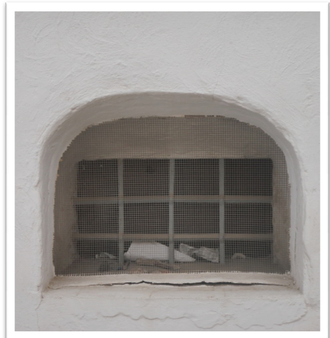
8. Ventana de la fachada posterior.
