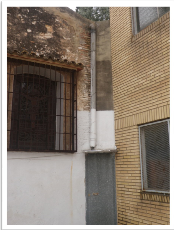
5. Ventana con vidriera de la fachada posterior.
