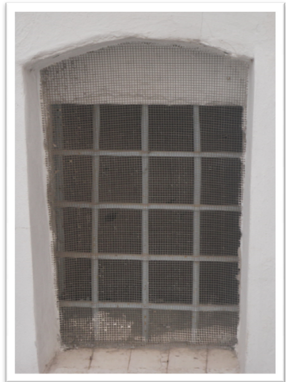
6. Ventana de la fachada posterior.
