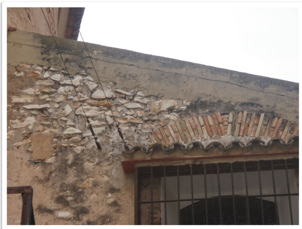
4. Detalle del dintel de las ventanas vidrieras de la fachada posterior.
