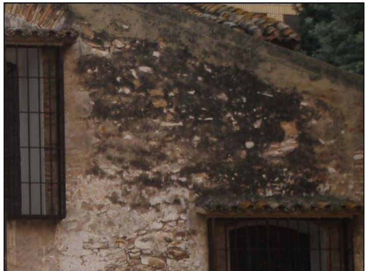
Muro de piedra sobre fábrica de ladrillo macizo
