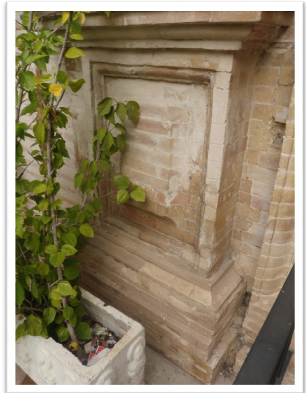
6. Detalle de la basa de la pilastra de la portada.
