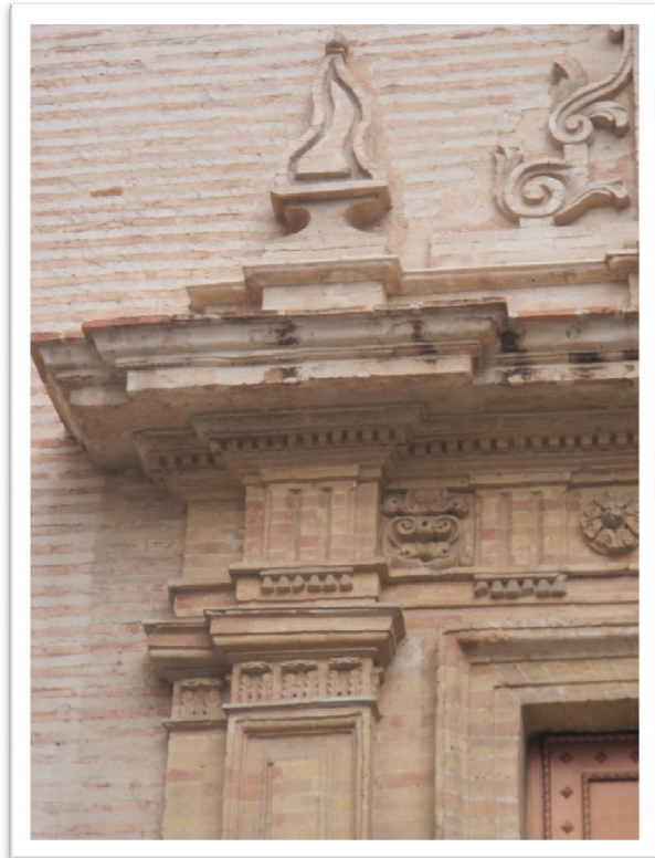
5. Detalle de la cornisa de la portada.
