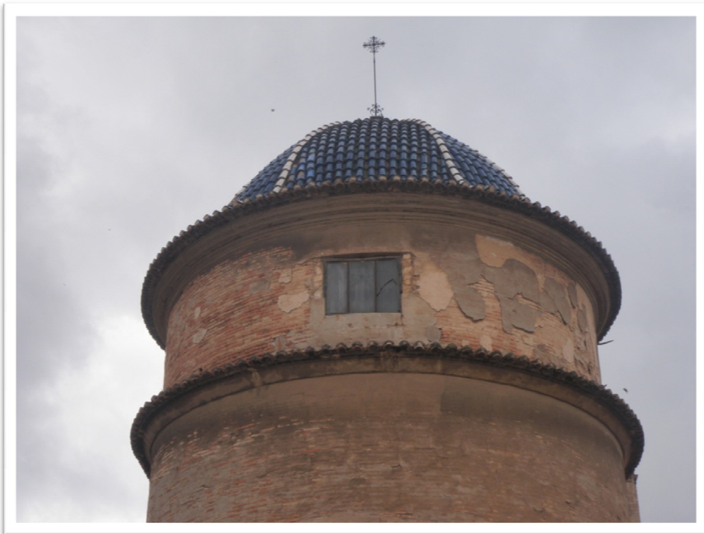
3. Detalle de la cúpula de la fachada
