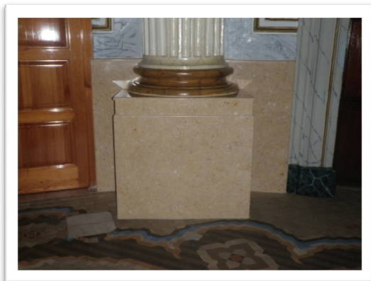
19. Detalle de la basa de la columna
