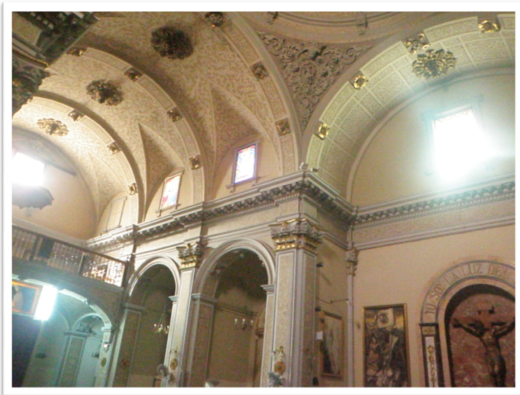
8. Detalle de la bóveda, crucero y pechina.
