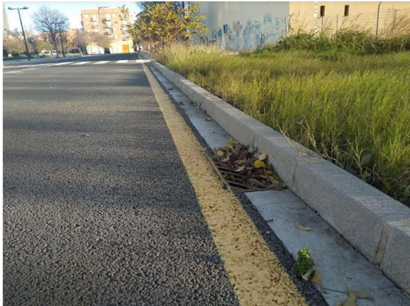
Ilustración 5: Imbornal totalmente obstruido por suciedad y hojas. (C/ Castillo de Cullera, Sociópolis, Valencia)
