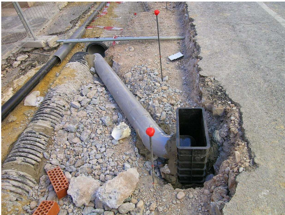
Ilustración 15. Ejecución en obra de un imbornal C-250 cortesía de BoscoHurtado.blogspot.com
