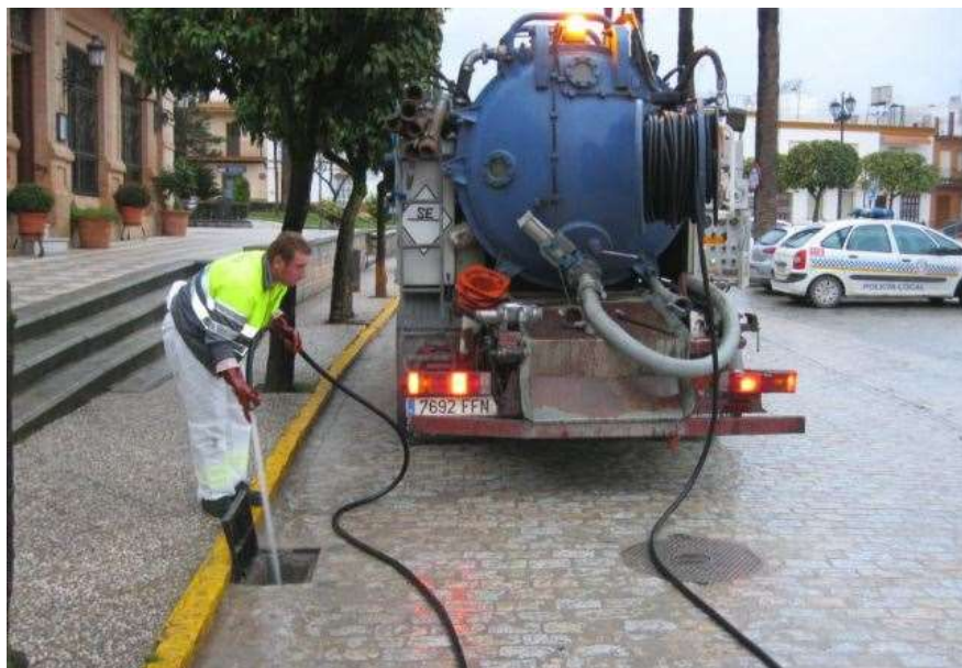
Ilustración 17: Operario realizando limpieza hidrodinámica con camión cisterna. Cortesía de ayuntamiento de Paradas
