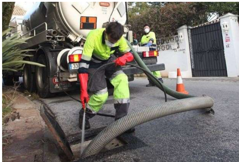
Ilustración 18: Operarios efectuando la labor de limpieza de imbornales mediante sistema impulsor-aspirador. Ayuntamiento de Marbella.
