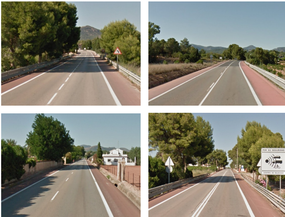
Fig. 11.1 - Imágenes de sección transversal, marcas longitudinales y arcén coloreado de la carretera CV-310
