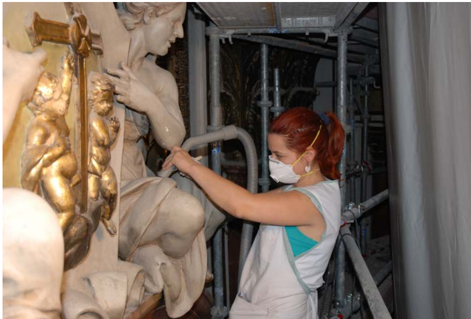
Fig. 11, fig. 12 y fig. 13. Limpieza mecánica de la superficie de las esculturas mediante el uso de la aspiradora y la brocha.
