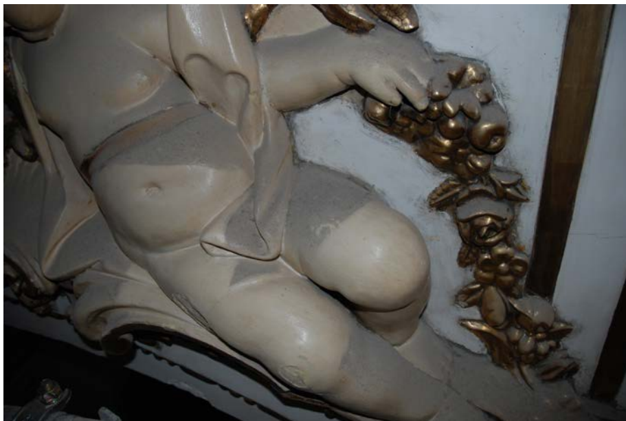
Fig.14, fig. 15, fig.16 y fig.17. Tras las pruebas de limpieza se puede observar la gran acumulación de polvo y suciedad.
