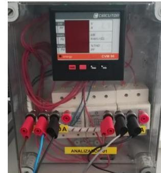
Figura 8. Analizador de energía
