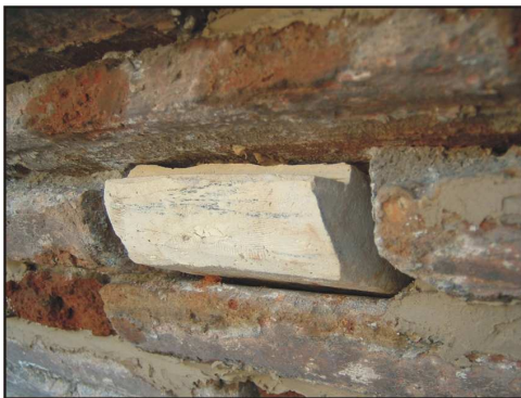
Fig. 31. Reposición de ladrillo.
