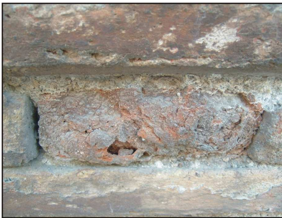
Fig. 28. Detalle de pérdida volumétrica de ladrillo.
