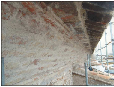
Fig. 41. Aspecto de la cornisa después de la limpieza con chorro de arena.
