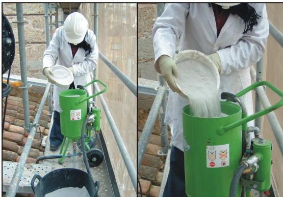
Fig. 23. Aplicación del abrasivo en el compresor.
