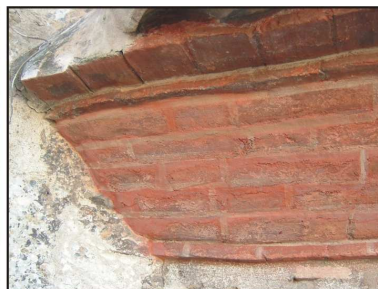
Fig. 48. Detalle de la reintegración cromática.
