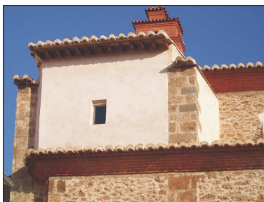
Fig. 60. Detalle de la parte izquierda de la fachada de la Iglesia después de la restauración.
