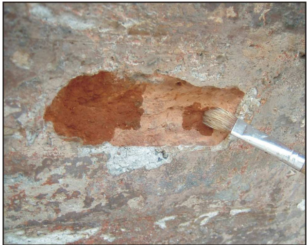
Fig. 22. Detalle de la aplicación del Silicato de Etilo en una laguna con pérdida volumétrica de ladrillo y película pictórica.
