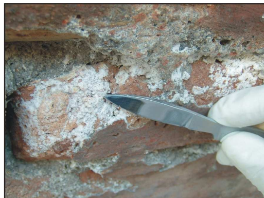
Fig. 15. Detalle de eliminación de concreciones.
