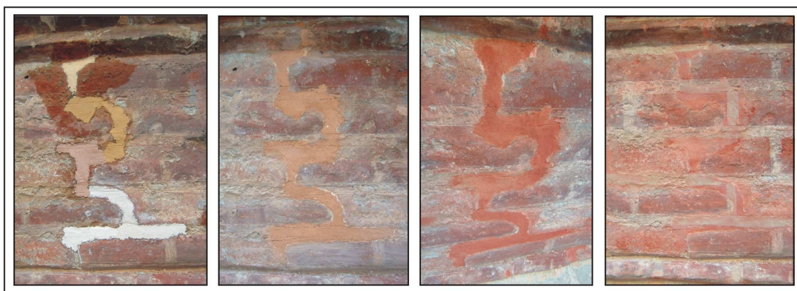
Fig. 54. Encuadre de la misma zona desde el inicio hasta el fin del proceso de intervención.
