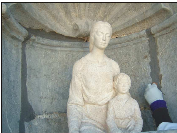
Fig. 65. Detalle de la reposición de mortero en la hornacina de la Virgen.
