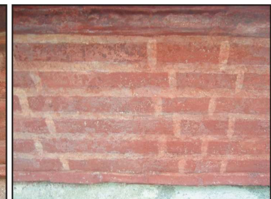
Fig. 49. Detalle de la reintegración cromática.
