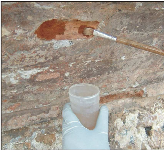
Fig. 21. Aplicación del Silicato de Etilo.
