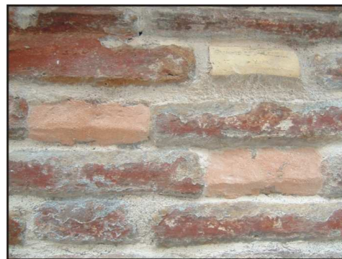
Fig. 32. En la parte superior, el ladrillo anterior con el mortero de las juntas aplicado.
