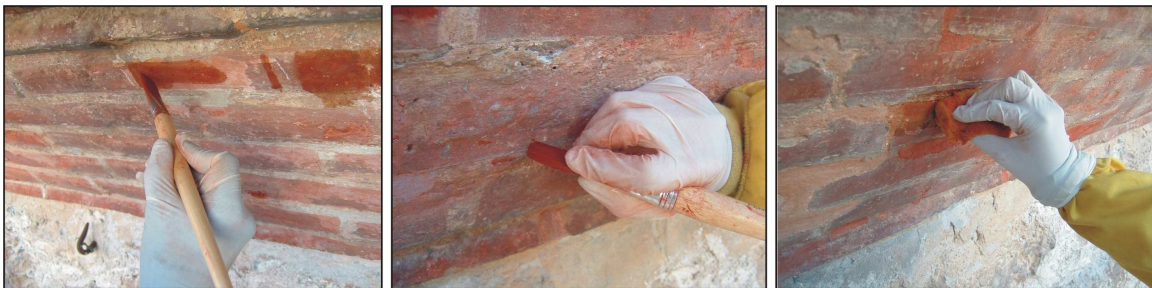
Figs. 33, 34 y 35. Reintegración cromática mediante pincel suave y esponja natural.
