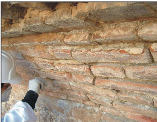
Fig. 18. Aplicación de la sepiolita en las zonas delimitadas.
