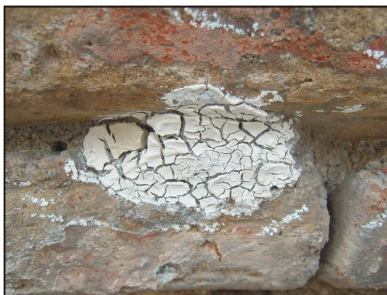
Fig. 20. Detalle del secado de la sepiolita.
