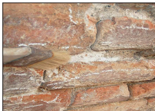
Fig. 17. Eliminación de sales mediante la utilización de brocha suave.
