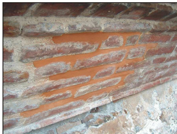
Fig. 30. Aplicación del mortero coloreado con el fin de nivelar la superficie.
