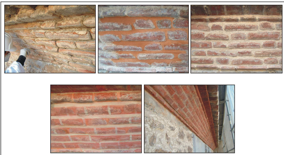
Fig. 57. Proceso fotográfico del antes y después de la restauración.
