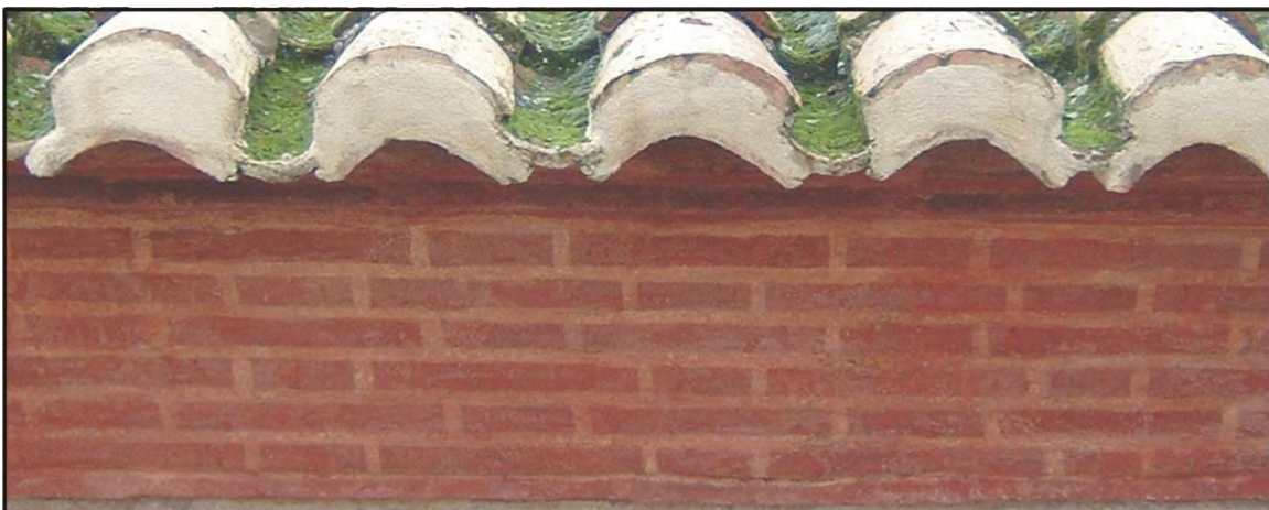
Fig. 51. Reintegración cromática con la línea clara aplicada.
