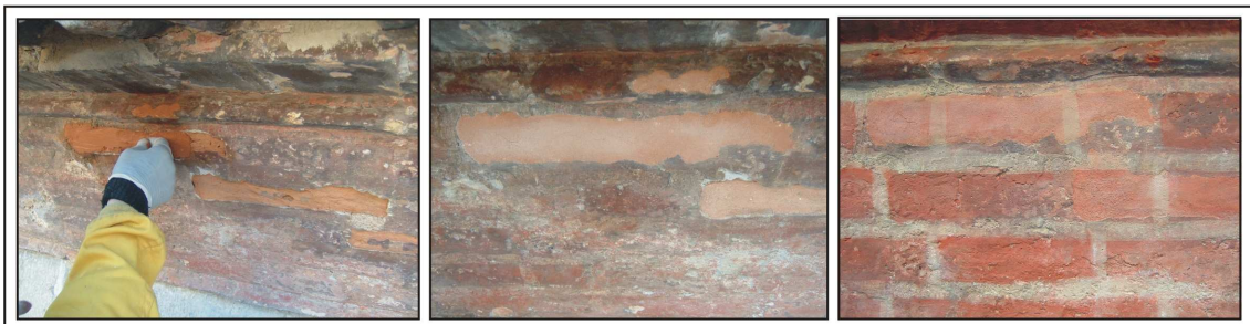
Fig. 56. Proceso de restauración de reintegración matérica.
