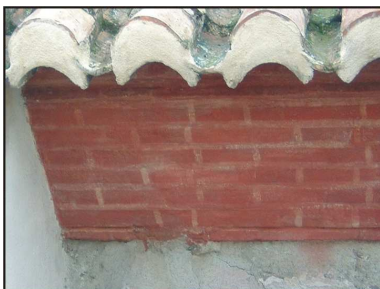
Fig. 47. Detalle de la reintegración cromática.
