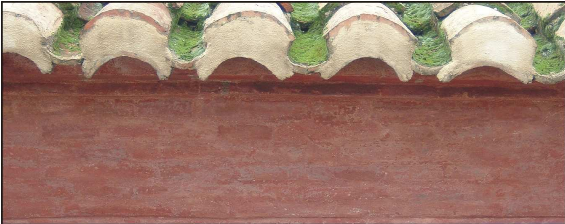
Fig. 50. Reintegración cromática sin aplicar las líneas claras que delimitan los ladrillos.
