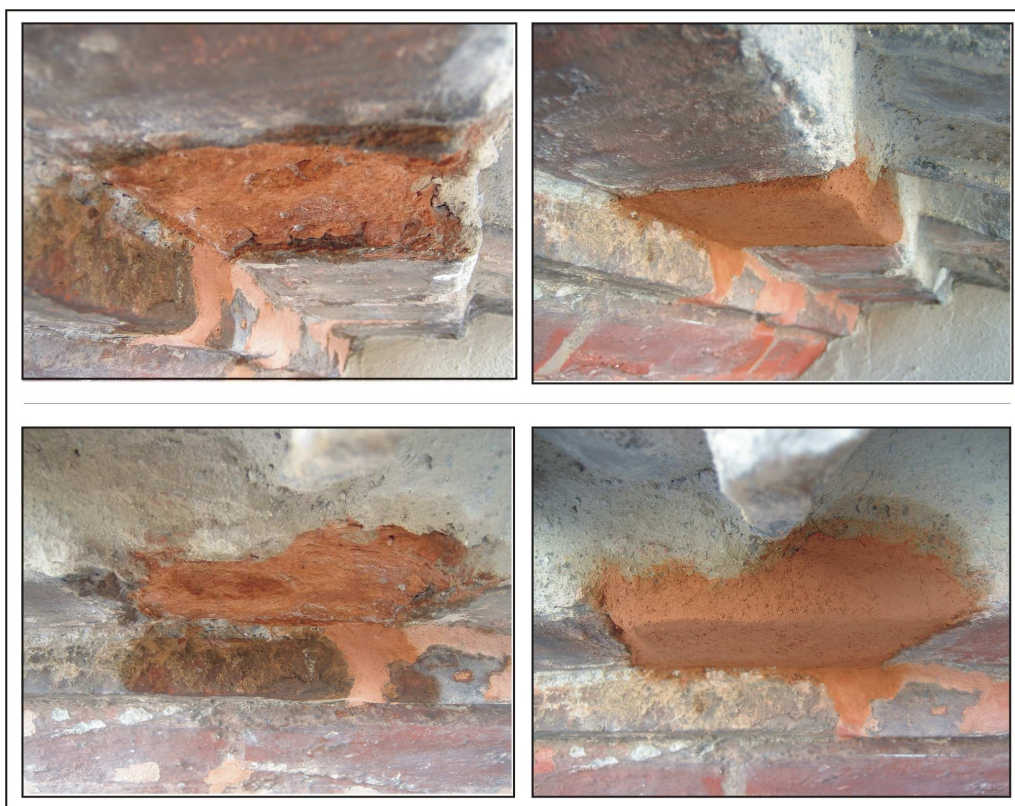
Fig. 53. Proceso de reconstrucción volumétrica de ladrillo, a la izquierda el antes y a la derecha el después de su restauración.
