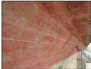
Fig. 45. Utilización del tiralíneas para realizar la silueta de los ladrillos.
