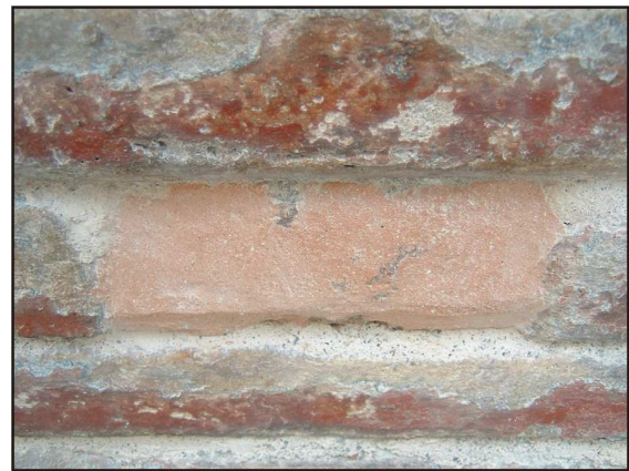
Fig. 29. Detalle de la reconstrucción volumétrica del ladrillo.
