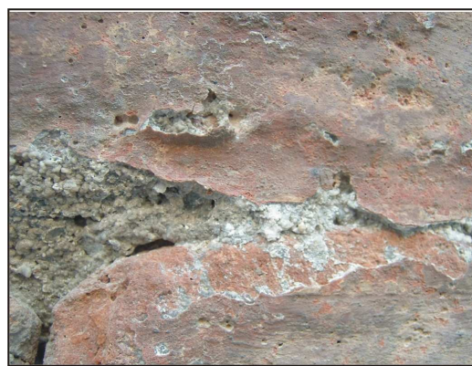
Fig. 7. Detalle de pérdida de película pictórica y parte del soporte.
