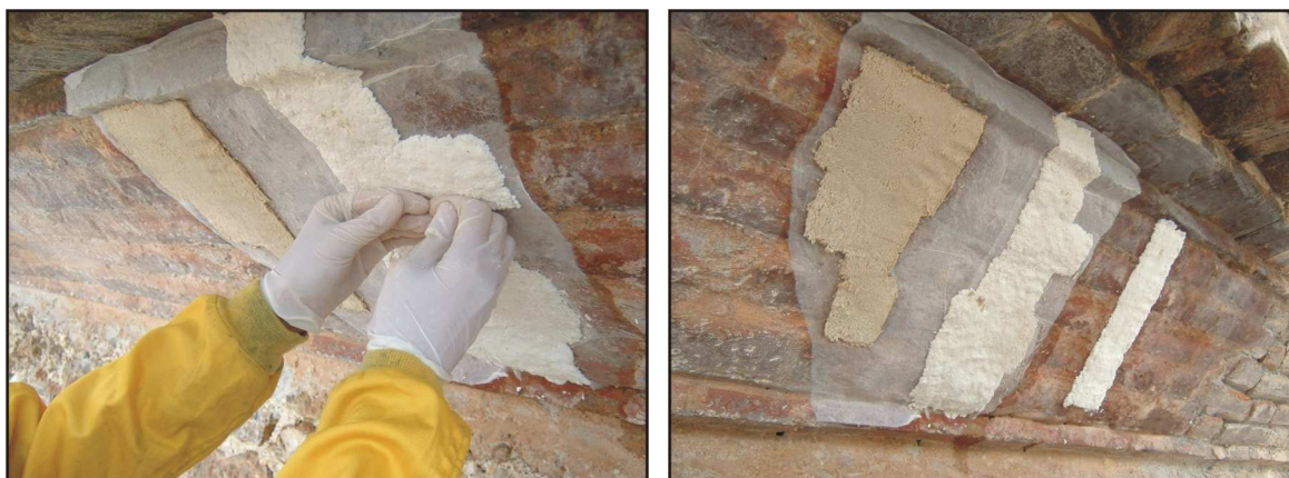
Figs. 12 y 13. Aplicación de diversos empacos.
