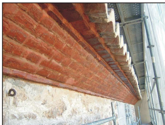
Fig. 40. Silicato de etilo aplicado a lo largo de la superficie.
