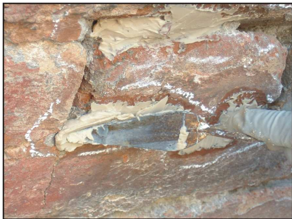
Fig. 19. Detalle de la aplicación de la sepiolita mediante espátula.
