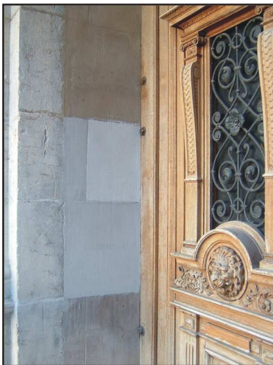
Fig. 63. Detalle de la aplicación de pintura en el interior del pórtico.
