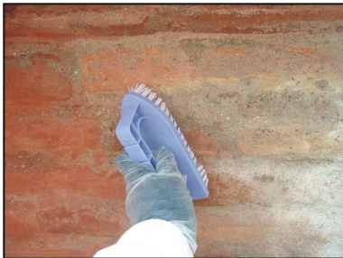
Fig. 44. Aplicación del color de forma uniforme a lo largo de la superficie.
