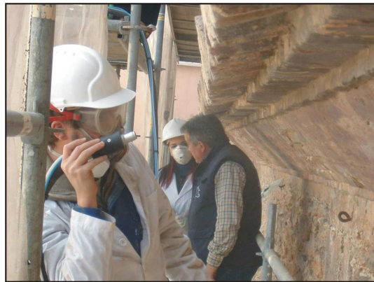
Fig. 24. Limpieza de la superficie mediante chorro de arena.
