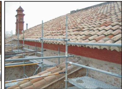
Fig. 46. Aplicación completa del rojo almagra por la superficie de la cornisa.
