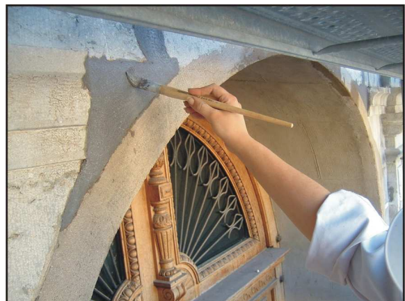
Fig. 66. Detalle de la aplicación de mortero líquido.
