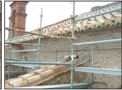
Fig. 43. Reintegración cromática de la parte izquierda de la cornisa.
