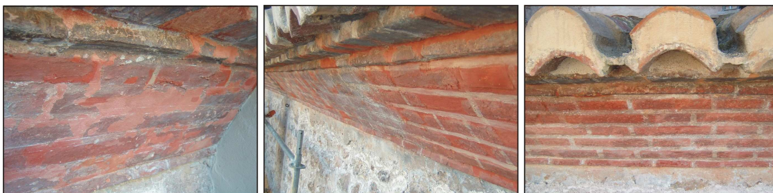
Fig. 36. Reintegración cromática de las lagunas realizadas con mortero coloreado.
