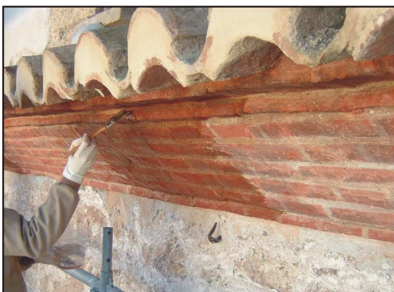
Fig. 39. Aplicación del silicato de etilo sobre la cornisa.
