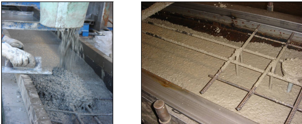
Figura 3.12. Fabricación de las vigas.
