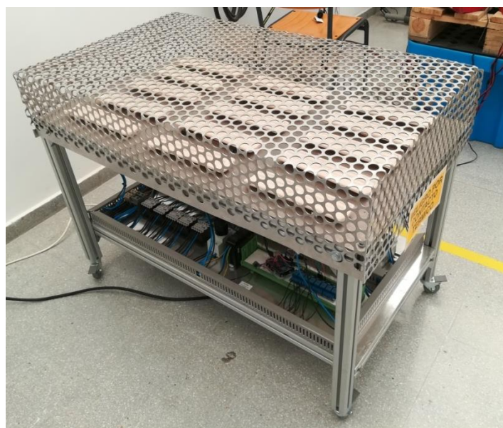
Fig. 30. Banco de resistencias de la instalación de laboratorio
