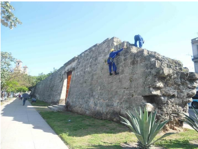
Lesiones en muros de sillares de piedra caliza conchífera y trabajos verticales para eliminar las plantas parásitas en los restos de la Antigua Muralla.
