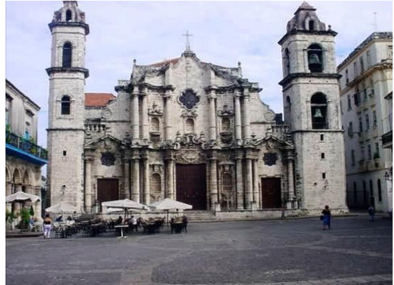
Catedral de la Habana, en la actualidad Fuente: Arq. Melero, Nelson
