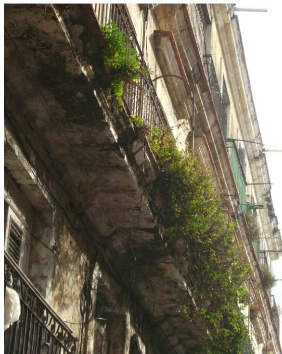
Deterioro avanzado en la fachada del edificio de San Ignacio No. 18 Fuente: Autor.
