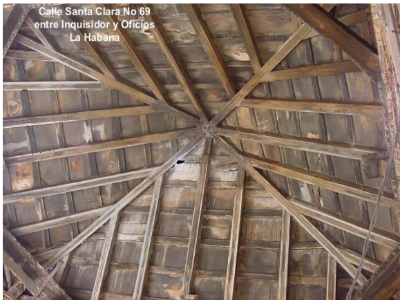
Armadura de par y nabo_ Calle Santa Clara No. 69 Fuente: es.slideshare.net
