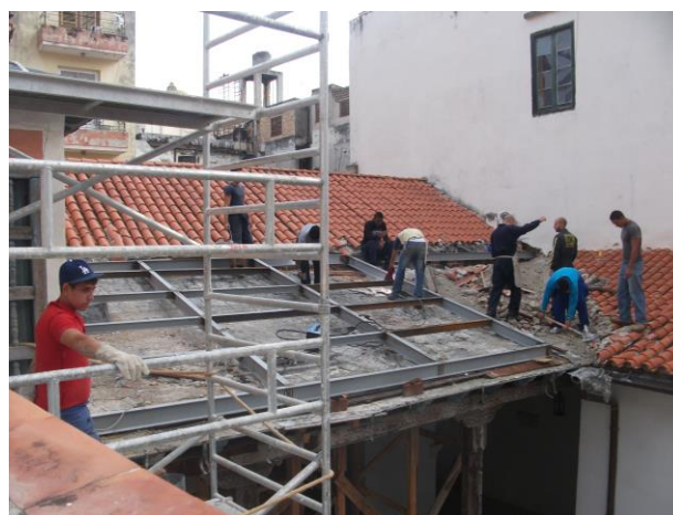
Sustitución del faldón de la galería anterior por una estructura metálica, 2009. Fuente: Archivo fotográfico de la Escuela Taller de la Habana “Gaspar Melchor Jovellanos”.
