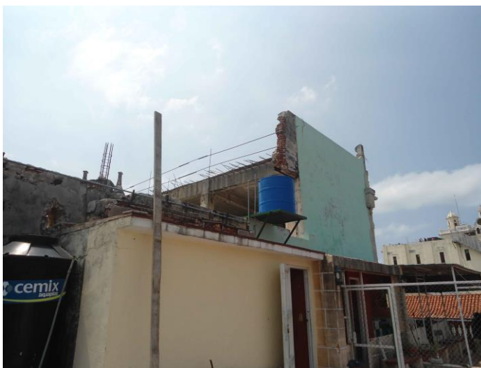
Pésimo estado de la cubierta del edificio de la calle Muralla No. 73_ Casa Zamora. Modificaciones antrópicas indebidas. Fuente: Autor.
