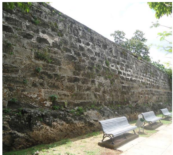
Lesiones en muros de sillares de piedra caliza conchífera y trabajos verticales para eliminar las plantas parásitas en los restos de la Antigua Muralla.
