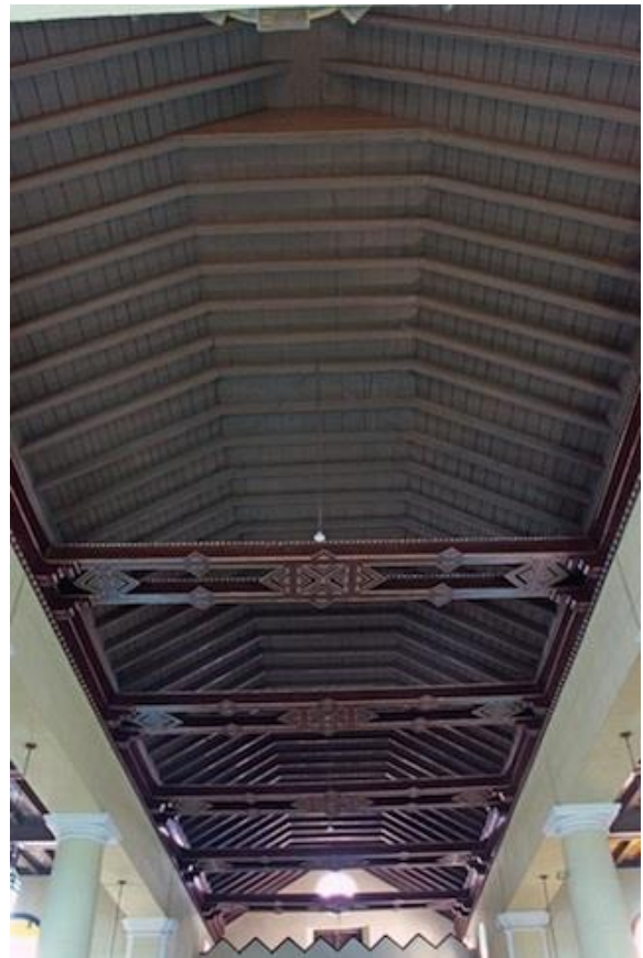
Alfarje de par y nudillo con almizate y tirantes pareados_ Iglesia del Santo Cristo del Buen Viaje Fuente: Alka Patel
