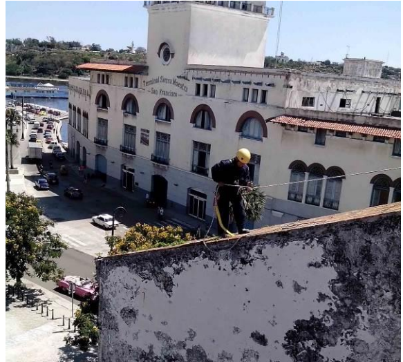
Lesiones en muros de sillares de piedra caliza conchífera y trabajos verticales para eliminar las plantas parásitas en del Convento de San Francisco de Asís.
