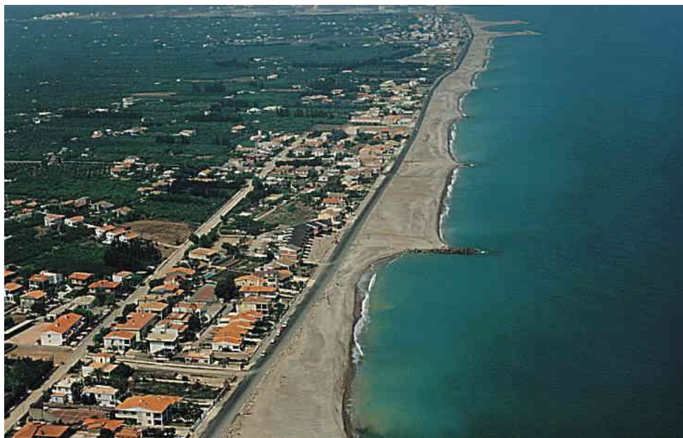
Imagen 2 Ejemplo de espigones de contención para la estabilización de la playa en el TM de Almazora (playa de La Torre)
