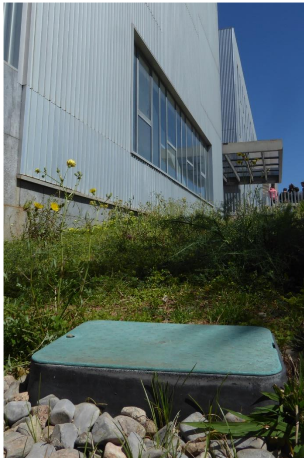
Ilustración 1. Arqueta de riego del recinto
