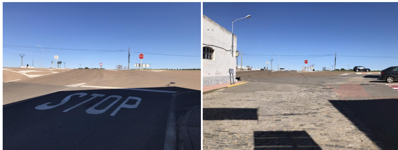
Figuras 21 y 22. Llegada a la intersección en pendiente desde la travesía de la EX-105 (izquierda) y desde las calles José Segundo Flores y Egido Thovar (derecha), con el acceso a la estación de servicio a la derecha antes de acometer el cruce. Fuente: Elaboración propia.
