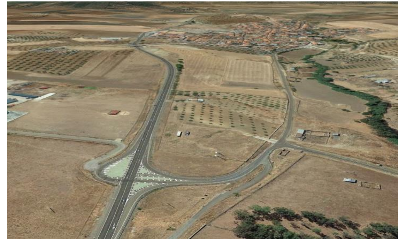
Figura 28. Nudo que conecta la N-435 y la EX-105 visto desde el Norte (en la llegada desde Badajoz – la Albuera hacia Almendral, situada al fondo); se aprecia a la derecha el trazado de la EX-105 tras la intersección de Almendral y la travesía que recorre el Norte de la localidad. Fuente: Google Earth.
