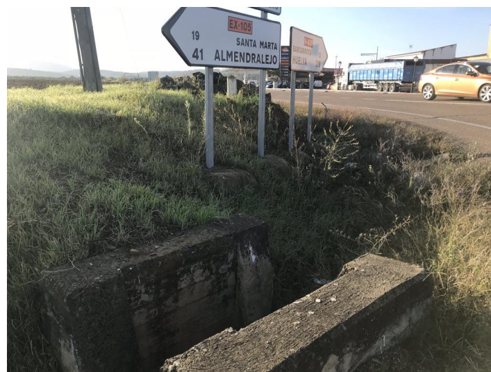
Figura 9. Arqueta de drenaje en la llegada de la EX-105 a la intersección de Almendral desde Torre de Miguel Sesmero.
