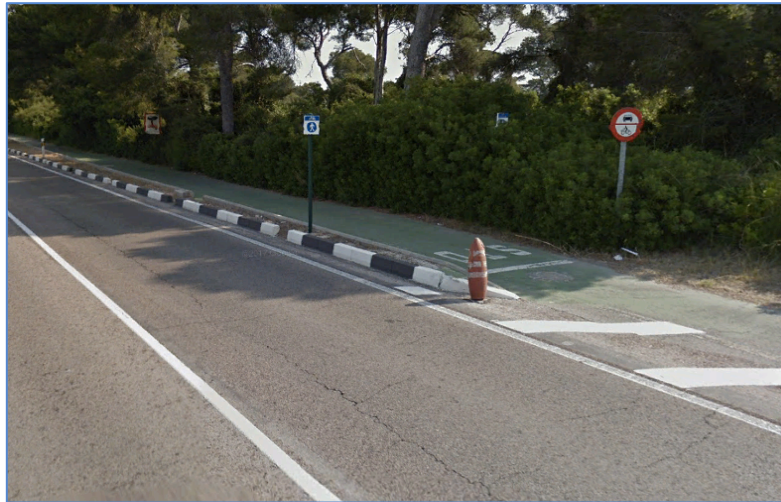
Figura 9. Carril bici carretera CV - 500. (Fuente: Google Earth)
