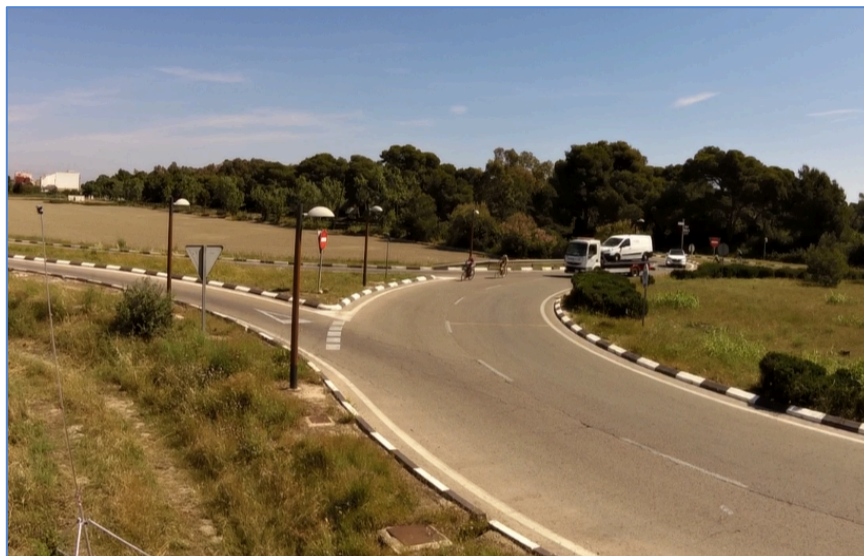
Figura 114. Situación cámara A.
