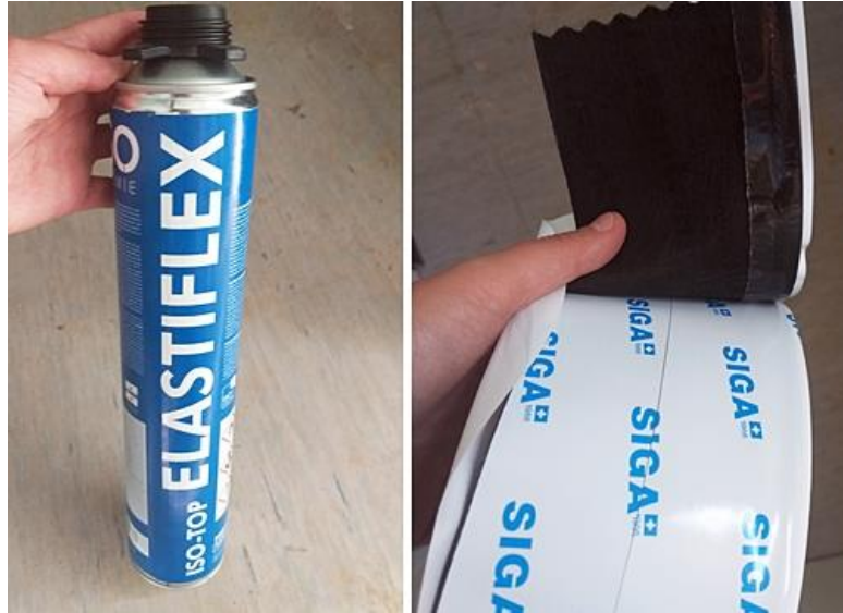
Figura 75. Espuma aislante y cinta hermética aplicadas sobre el marco exterior de PVC en la vivienda. Fuente: elaboración propia.
