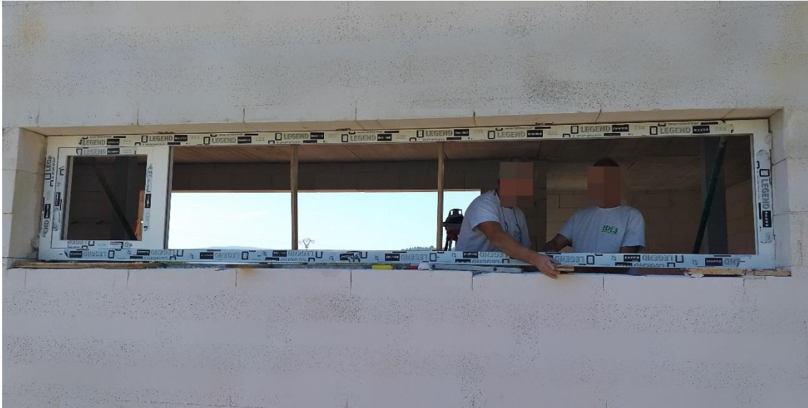
Figura 70. Nivelación de una ventana mediante calzos o cuñas con ayuda del láser. Fuente: elaboración propia.
