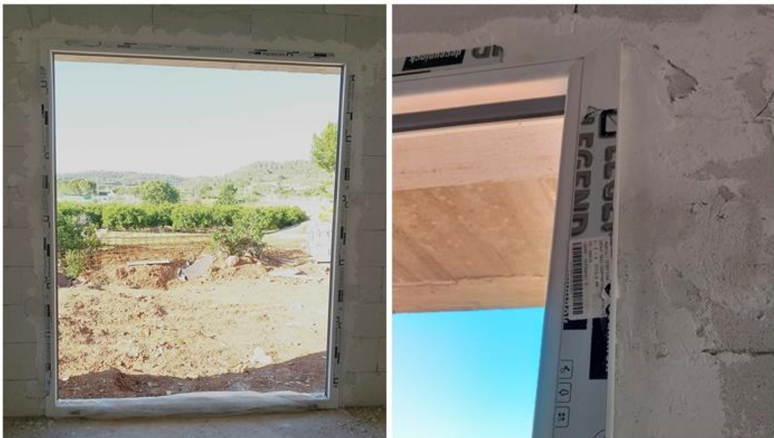
Figura 71. Sellado de los marcos de PVC contra el muro mediante yeso. Fuente: elaboración propia.
