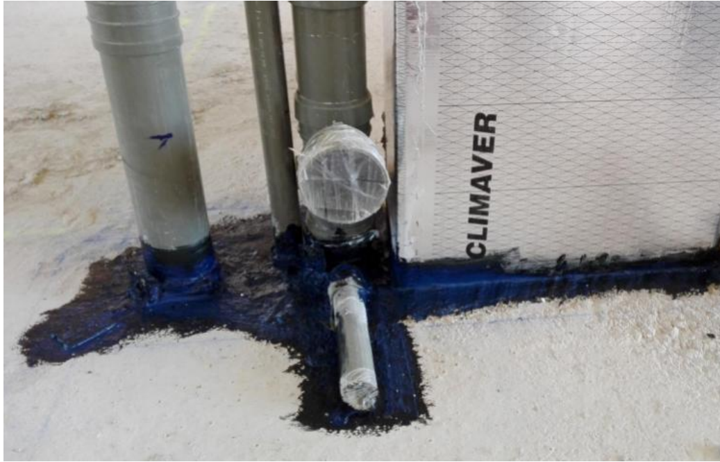
Figura 79. Sellado de instalaciones con membrana líquida. Fuente: BLOWERPROOF LIQUID, 29 Viviendas Soto Lezkairu ( https://www.blowerproof.es/realizaciones/29-viviendas-soto-lezkairu ).
