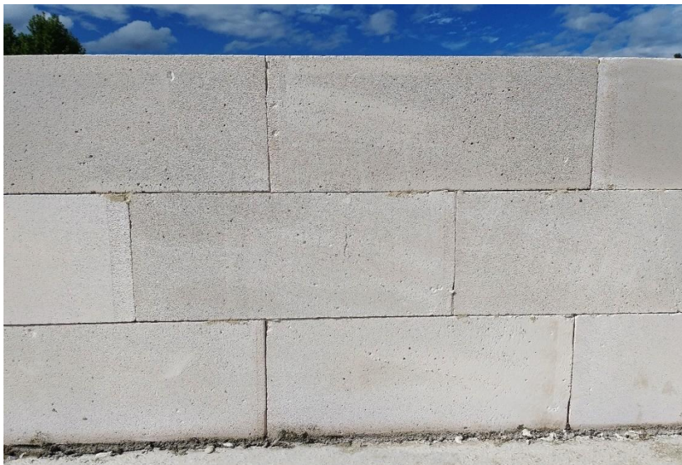
Figura 34. Colocación del bloque de hormigón celular. Fuente: elaboración propia.
