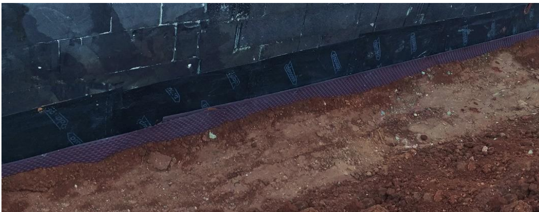
Figura 60. Relleno del trasdós con las propias tierras extraídas de la excavación del sótano. Fuente: elaboración propia.
