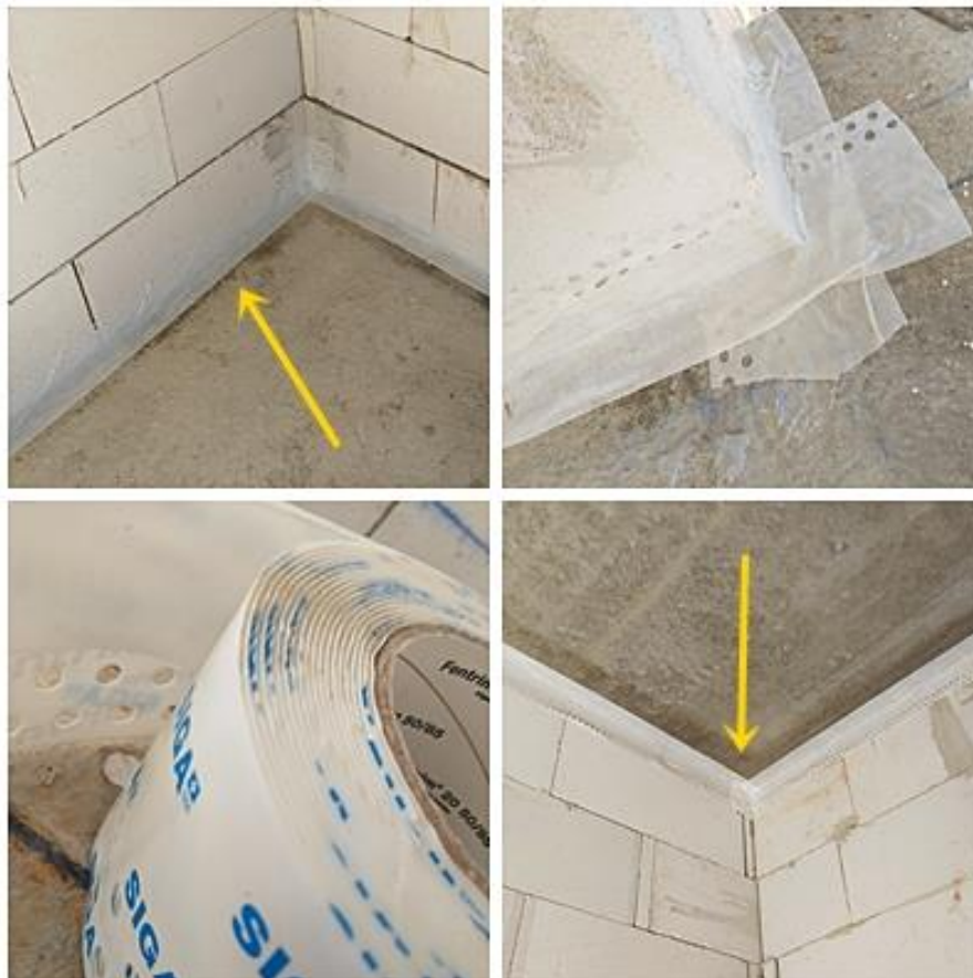
Figura 77. Colocación de cintas herméticas sobre la imprimación en encuentro de forjado y fachada. Fuente: elaboración propia.
