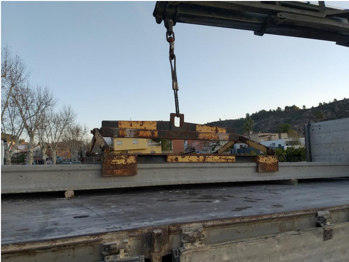
Figura 44. Pinza especial empleada para el montaje de placas alveolares de 1,20 m de anchura. Fuente: elaboración propia.
