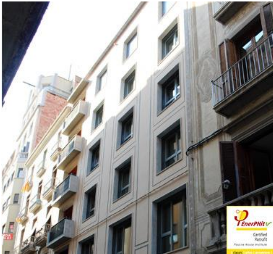
Figura 22. Edificio multiresidencial rehabilitado en el año 2017 en Girona. Fuente: ENERPHIT NOU2, Proyecto de certificación. Energiehaus, Edificios pasivos ( http://www.energiehaus.es/proyecto/enerphit-nou2/ ).
