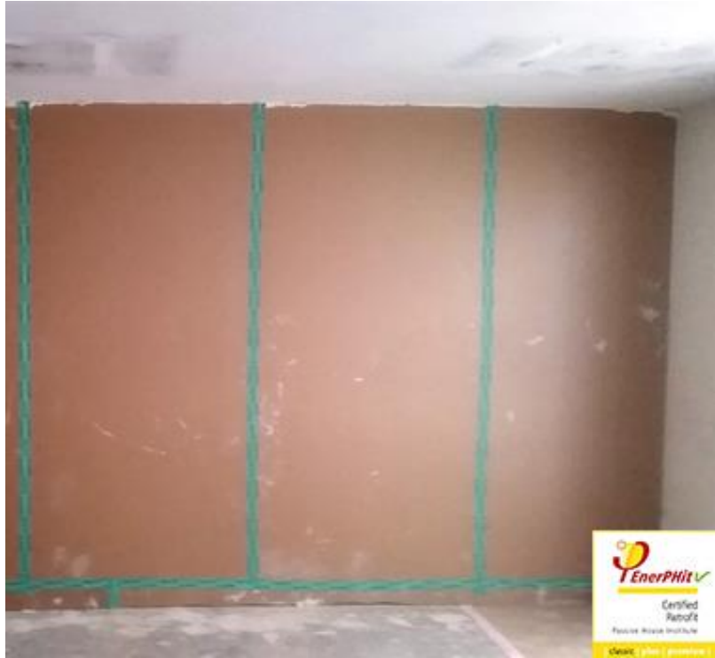
Figura 23. Edificio multiresidencial rehabilitado en el año 2017 en Girona. Fuente: ENERPHIT NOU2, Proyecto de certificación. Energiehaus, Edificios pasivos ( http://www.energiehaus.es/proyecto/enerphit-nou2/ ).
