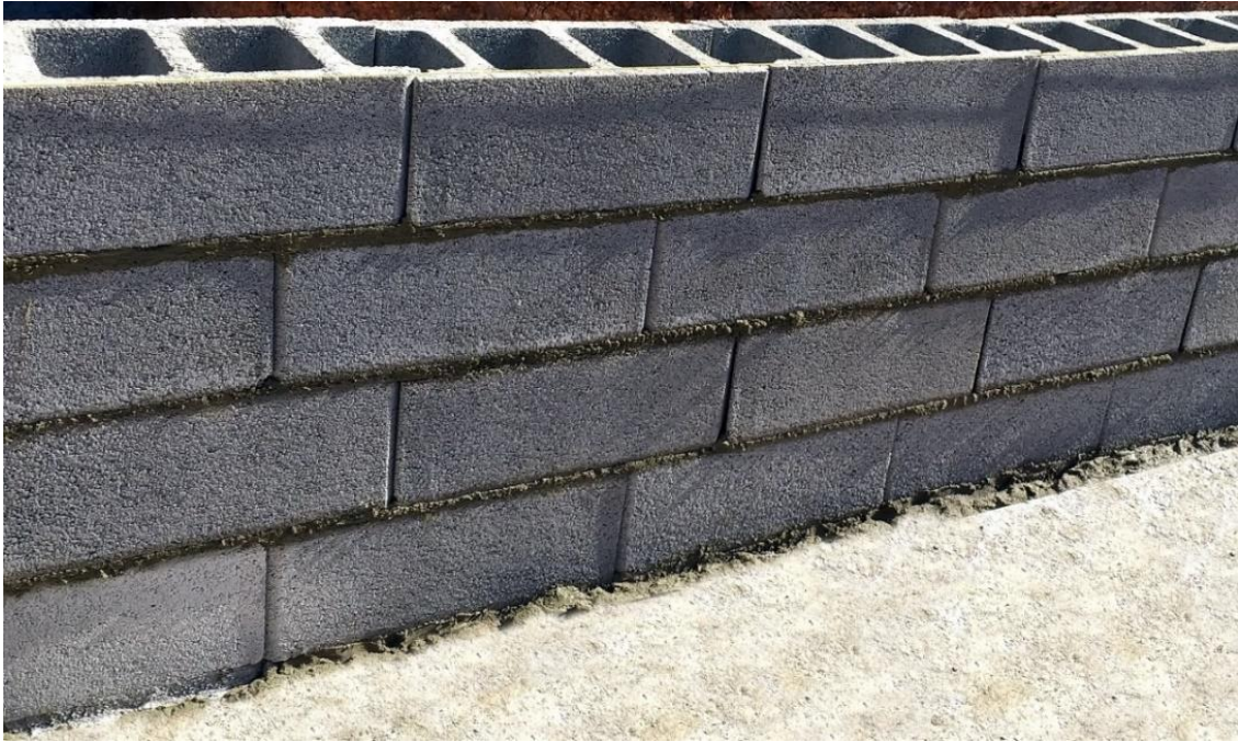
Figura 28. Muro de sótano con bloques de hormigón estructural. Fuente: elaboración propia.
