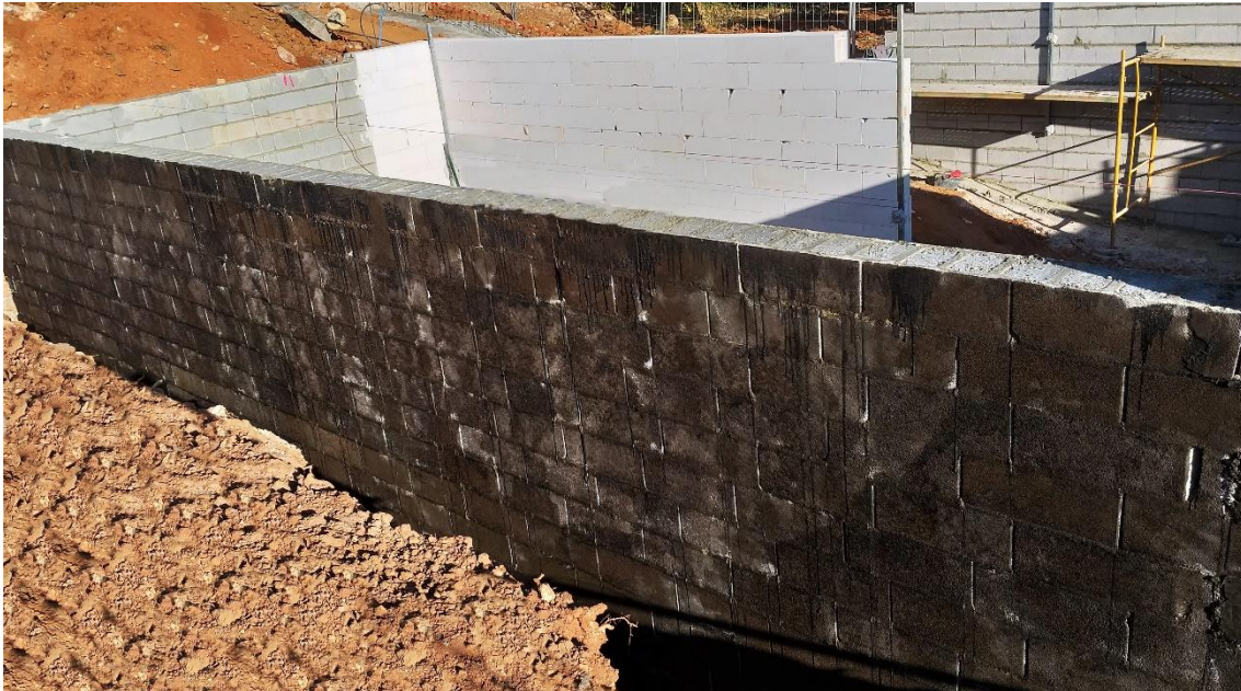
Figura 52. Revestimiento de pintura bituminosa a base de polímeros asfálticos sobre el bloque de hormigón que forma el muro de sótano. Fuente: elaboración propia.
