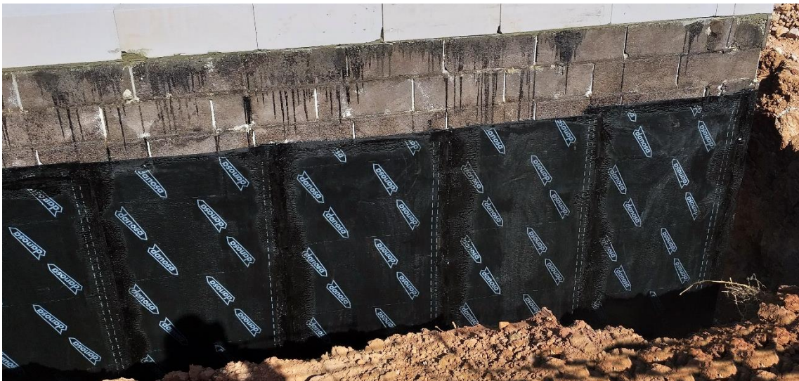
Figura 54. Lámina de betún modificado con elastómero sobre revestimiento de pintura bituminosa asfáltica. Fuente: elaboración propia.
