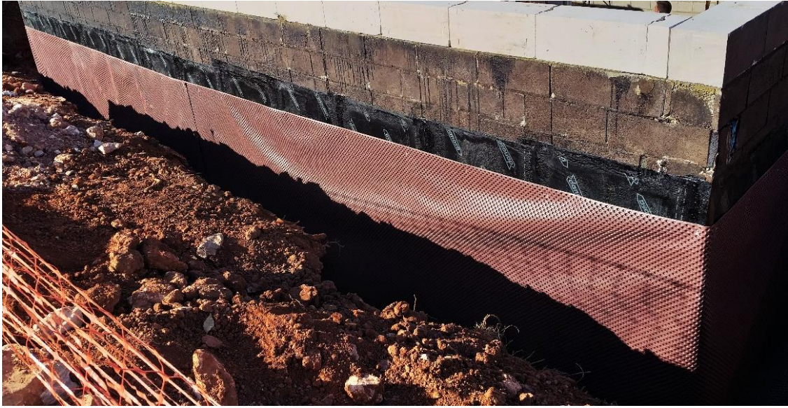
Figura 55. Lámina nodular de polietileno de alta densidad sobre lámina de betún modificado. Fuente: elaboración propia.
