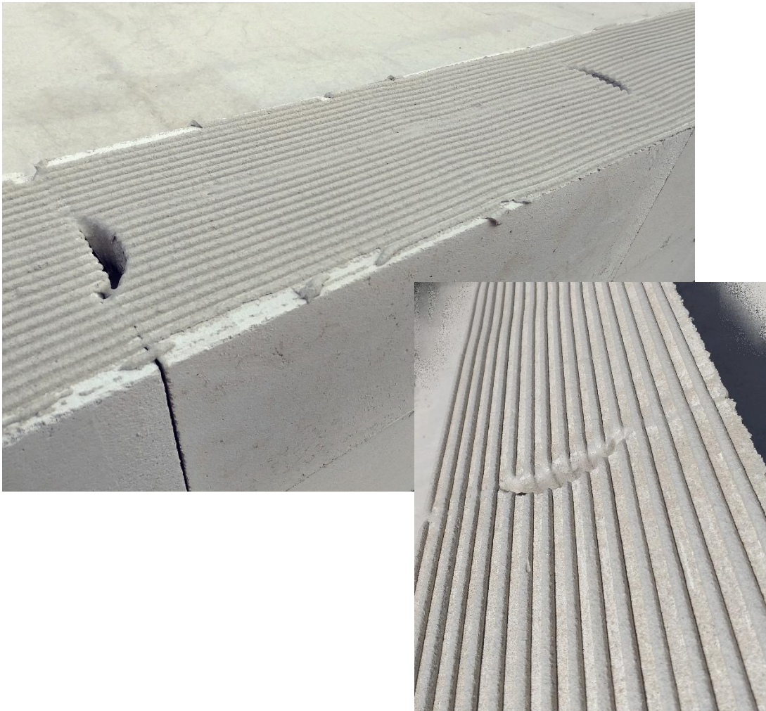
Figura 32. Aplicación de mortero-cola en junta fina sobre bloque de hormigón celular. Fuente: elaboración propia.
