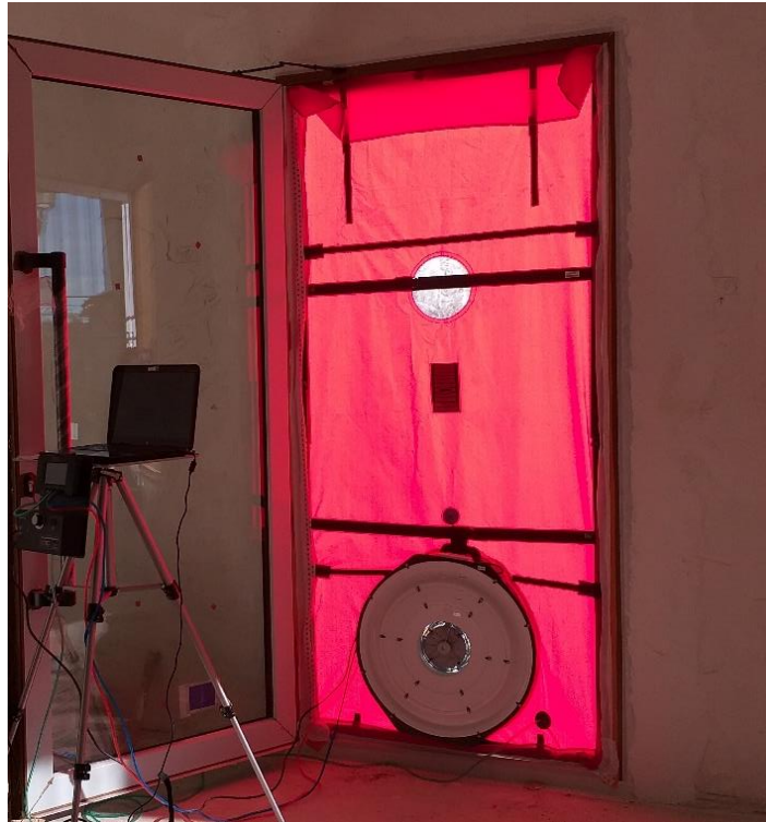
Figura 15. Puerta principal de una vivienda donde se colocan los materiales empleados para realizar el test de Blower Door. Fuente: elaboración propia.
