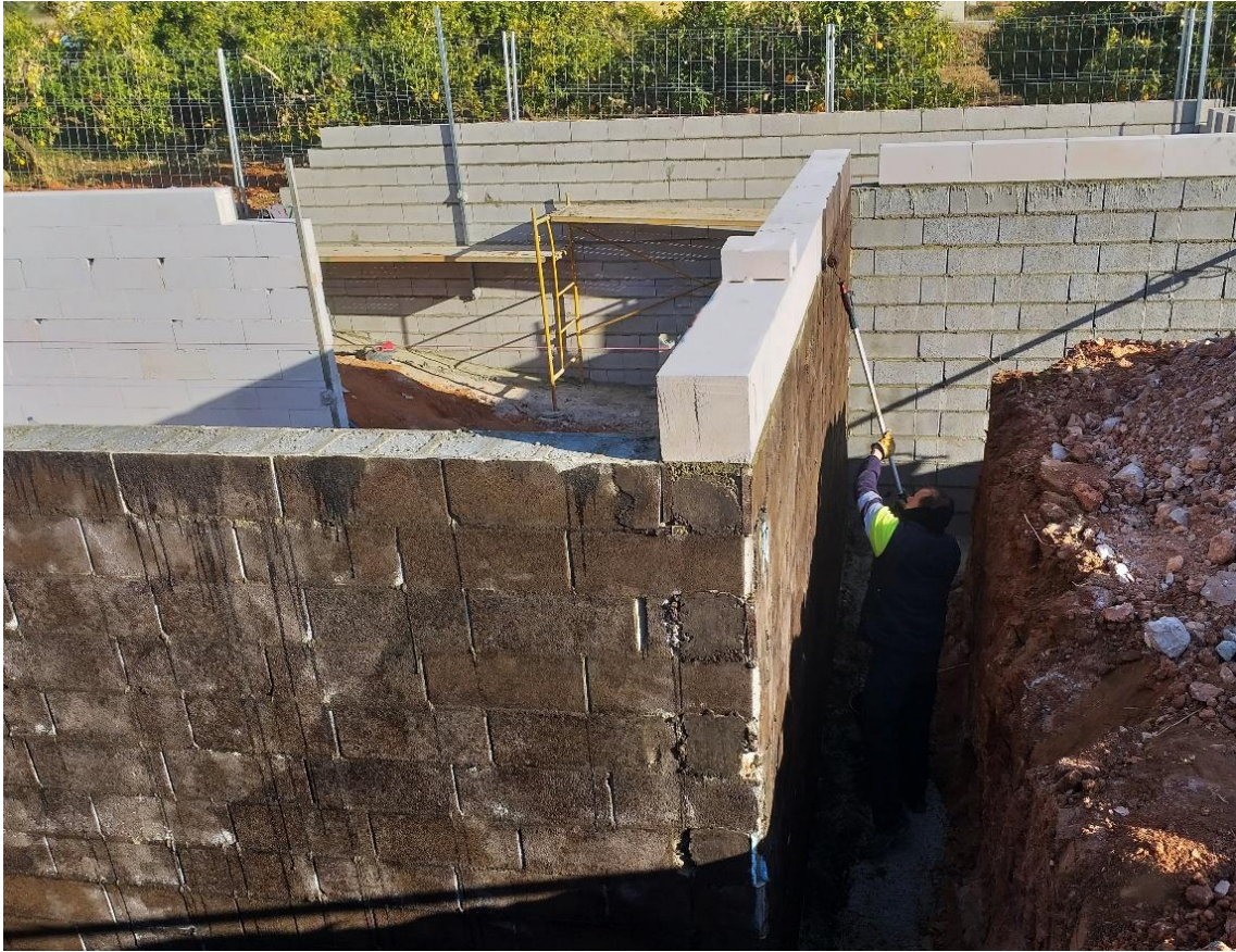
Figura 53. Aplicación de pintura bituminosa asfáltica mediante rodillo. Fuente: elaboración propia.
