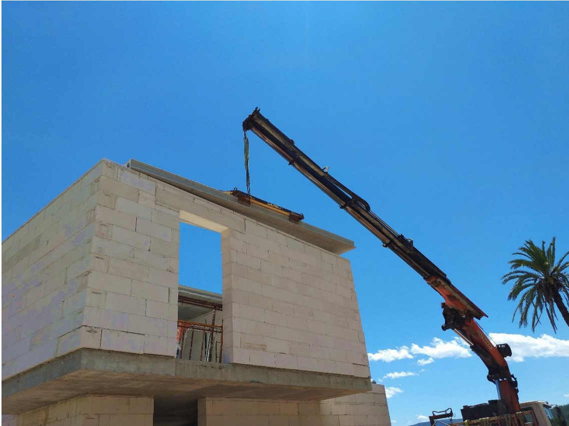
Figura 45. Colocación de placas alveolares en forjado mediante grúa y pinza especial. Fuente: elaboración propia.
