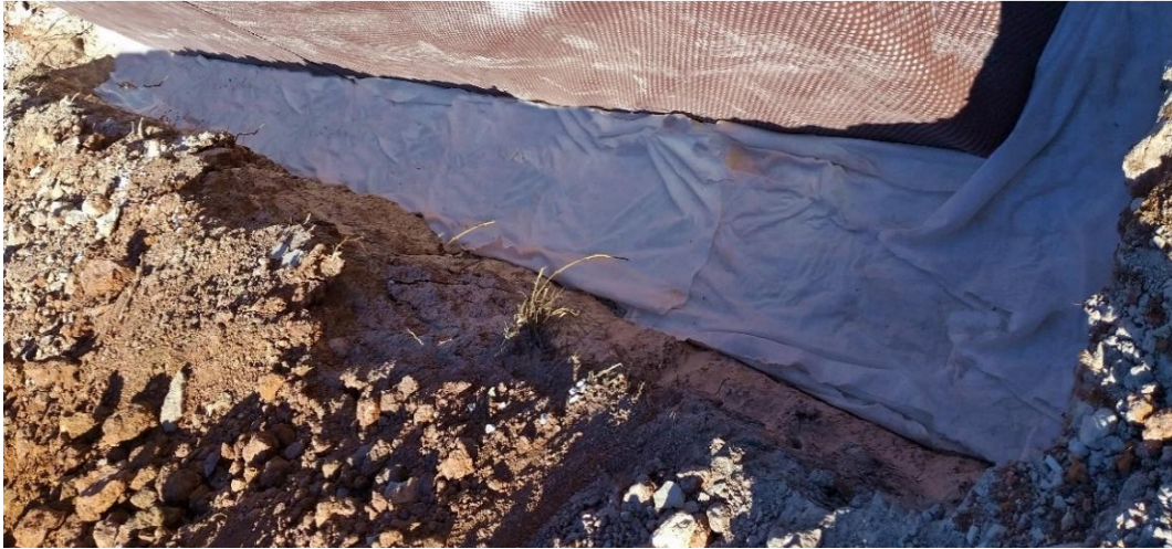
Figura 59. Lámina de geotextil sobre capa de gravas. Fuente: elaboración propia.
