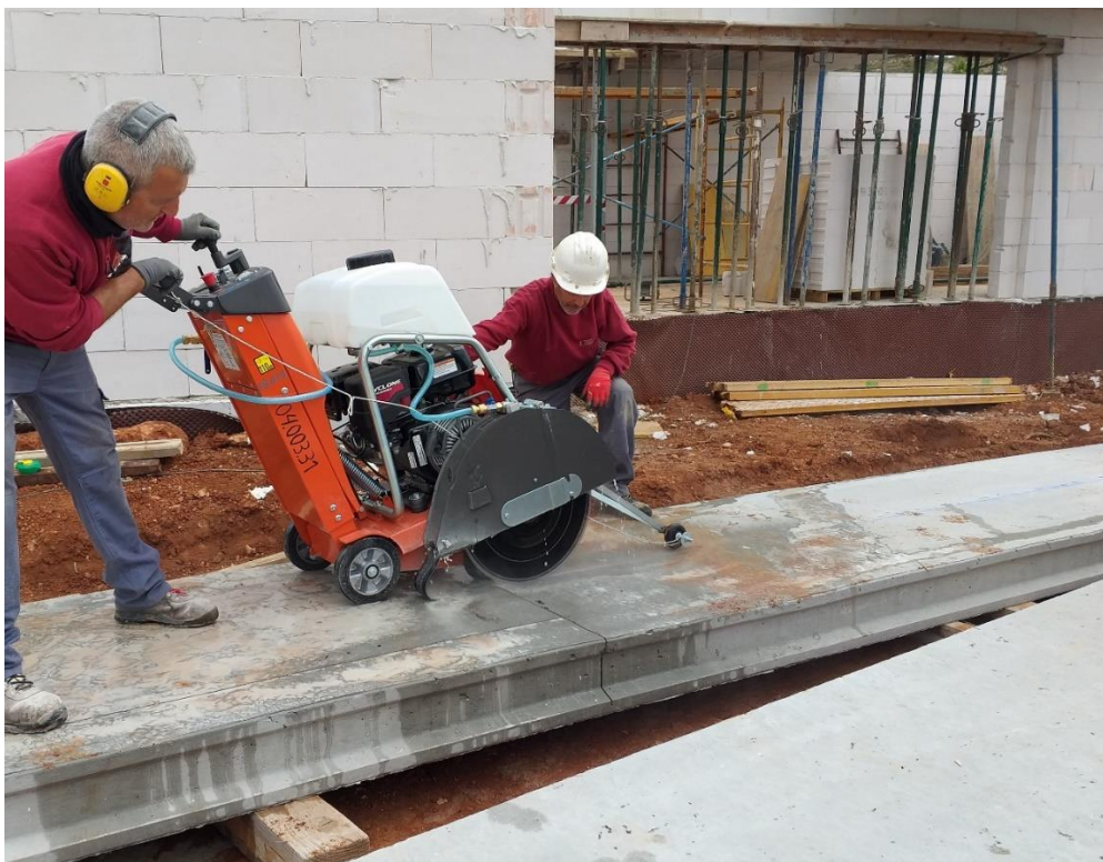
Figura 46. Máquina cortadora de agua para seccionar una placa alveolar a la distancia necesaria. Fuente: elaboración propia.
