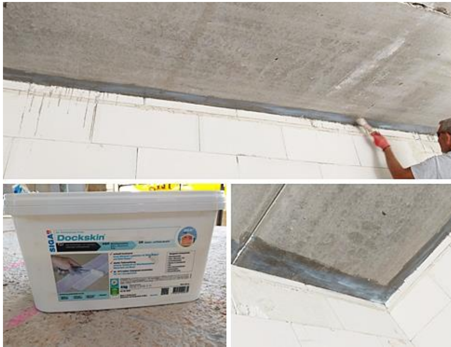
Figura 76. Aplicación de la imprimación sobre encuentro entre forjado y fachada. Fuente: elaboración propia.
