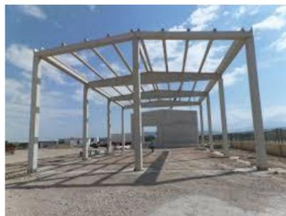
Ilustración 5 Ejemplo de nave prefabricada de hormigón
