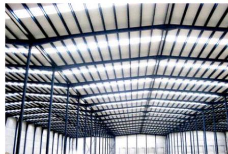
Ilustración 6 Ejemplo de nave prefabricada metálica
