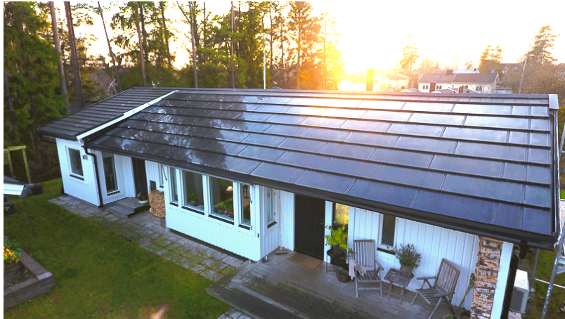
Figura 1.10: Una cubierta integrada con placas fotovoltaicas.
