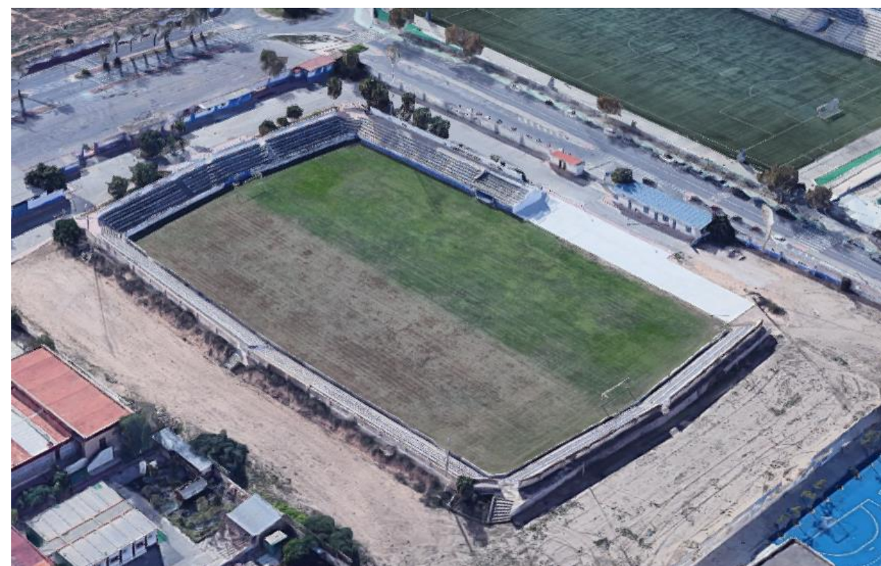
Figura 2. Vista aérea del estadio Vicente García en 2019. (Fuente: Google Maps)
