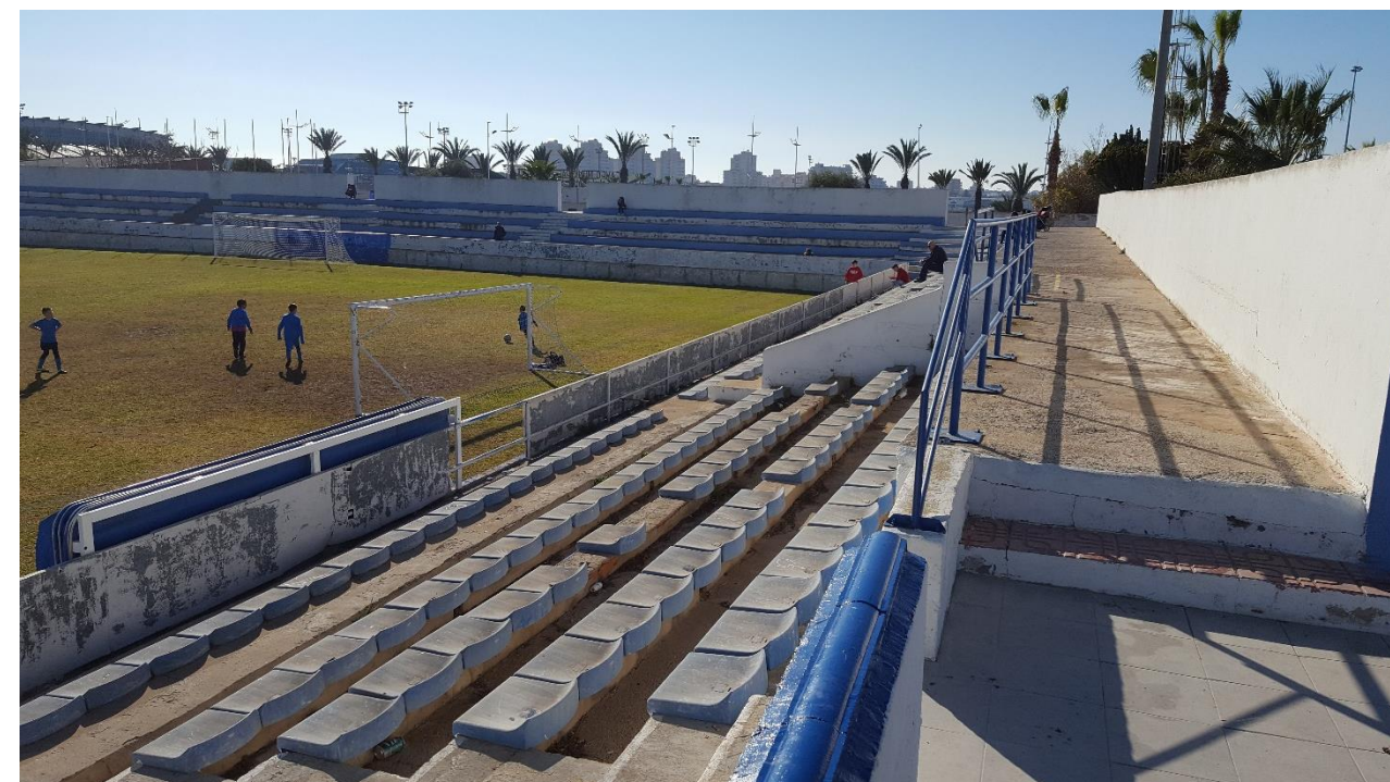
Figura 3. Parte no demolida de la grada oeste. (Fuente: elaboración propia)
