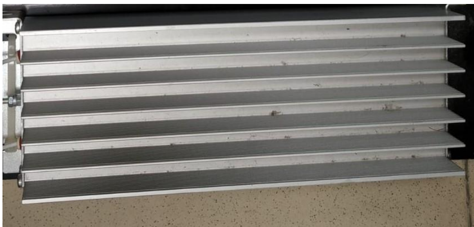
Figura 66. Resistencia del breaker.
